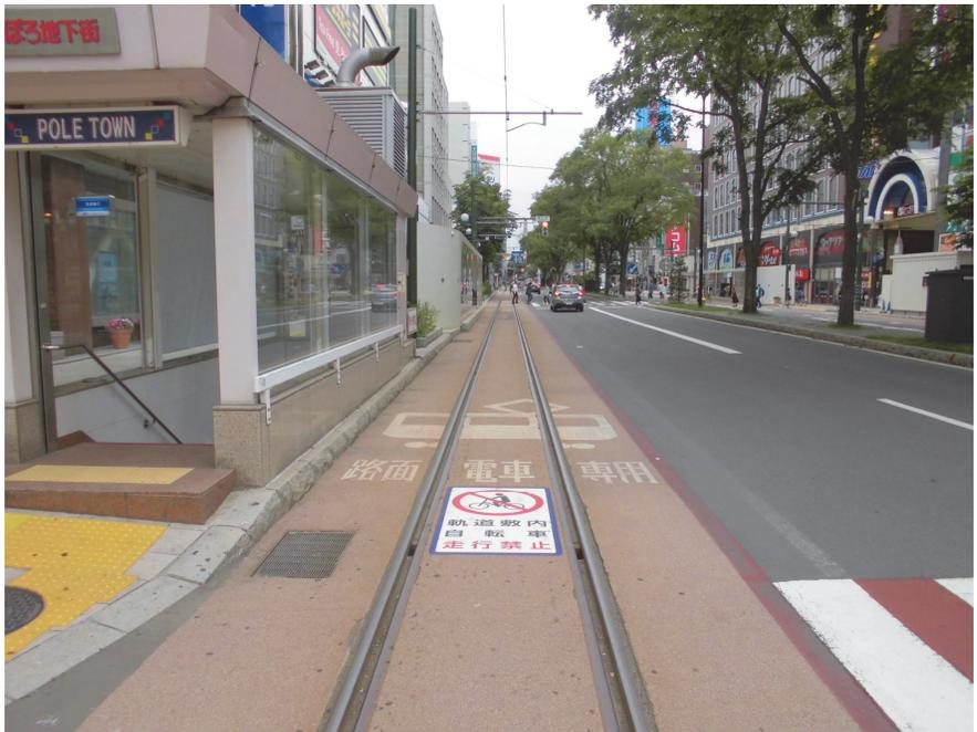
サイドリザベーション方式を採用したことによる軌道への車両や自転車等の誤進入を防ぐため、注意喚起の看板類を設置(北海道札幌市 札幌駅前通:市電ループ化)
