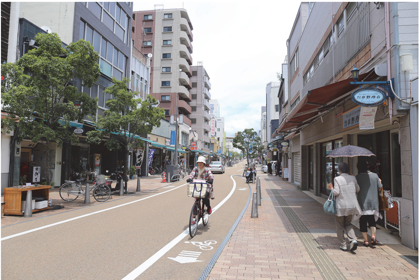
スラロームの導入による車両の速度抑制と併せてアーケードを撤去するとともに、高質な空間をトータルデザイン ロープウェイ通り(愛媛県・松山市)
