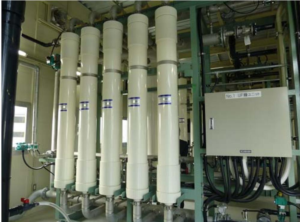
図 2-5 UF 膜ろ過装置(実証施設)の外観
