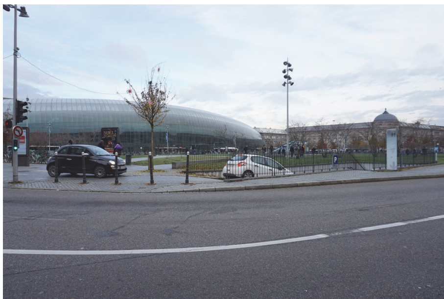
駅周辺に地下駐車場が整備されている (フランス・ストラスブール)
