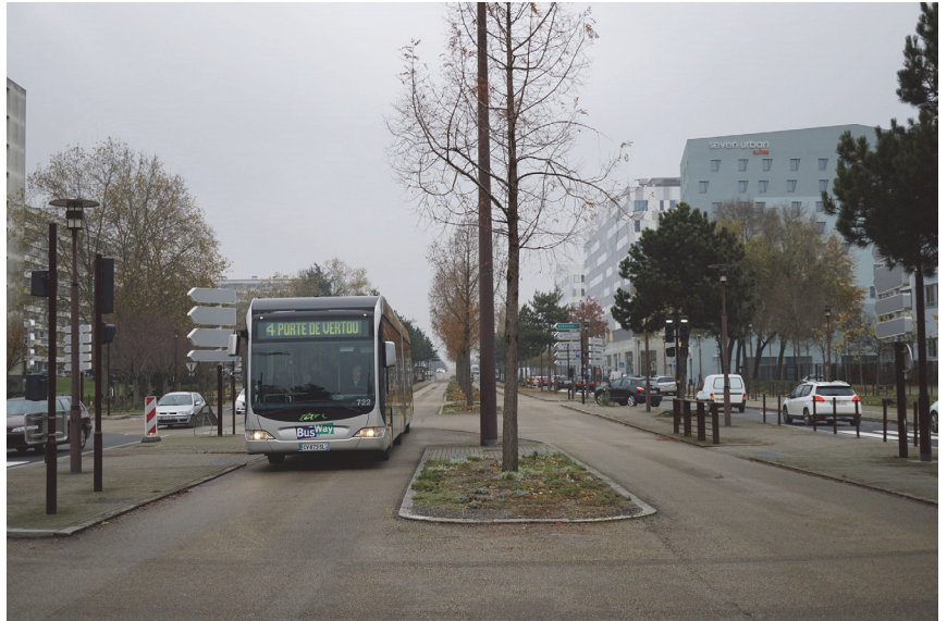
BRTが一般車の走行車線と物理的に分離したバス専用空間を走行する (フランス・ナント)
