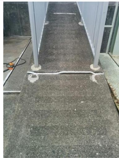
写真 36 : 益城町浄化センター反応槽 EXP. Jズレ
