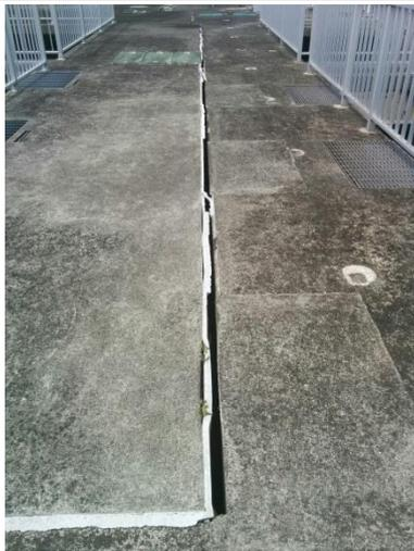
写真 35 : 益城町浄化センター反応槽 EXP. Jズレ
