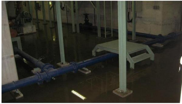
写真 37 : 城町浄化センター管廊浸水 (4 月 16 日)
