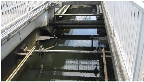
写真 39 : 益城町浄化センター最初沈殿池
