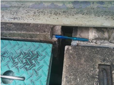
写真 33 : 益城町浄化センター反応槽 EXP. Jズレ
