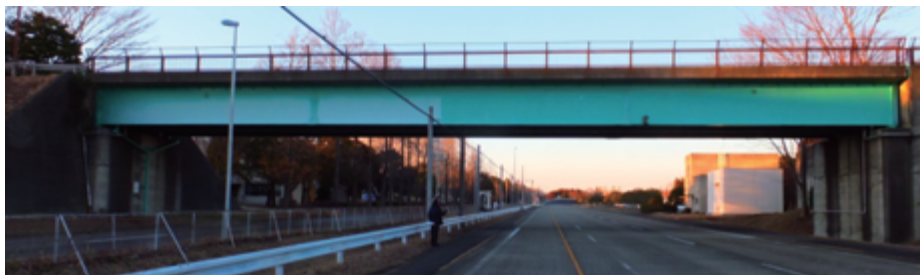
図-4.3.1 実験対象橋梁（側面写真）
