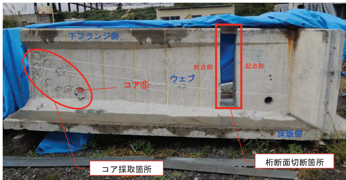
写真-3.1.5 解体調査状況 (C-6)
