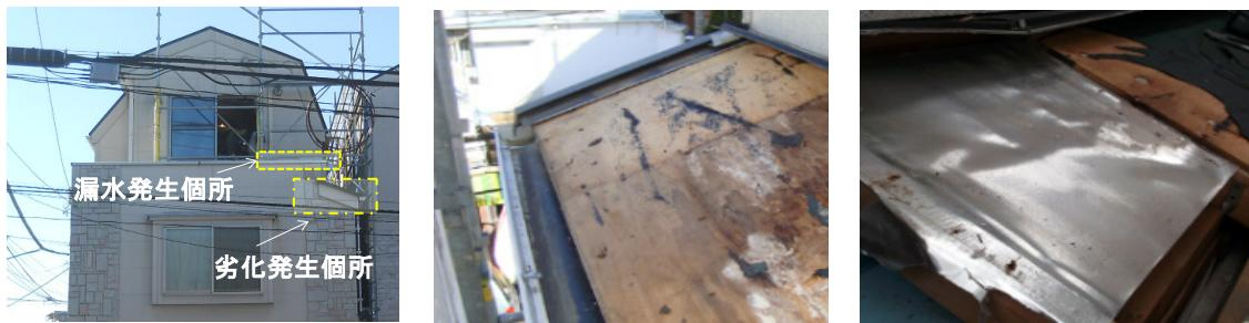
写真 6.1.1 調査物件外観と劣化部位（左：西側外観、中央：劣化部位、右：アルミクラフト紙）
