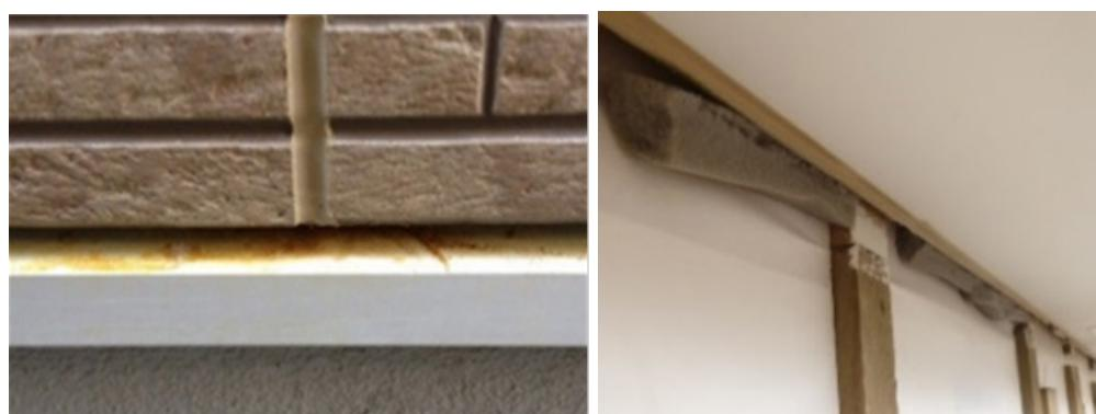
写真 3.3.2 結露による土台水切りの腐食例 写真 3.3.3 通気層上端の状態
