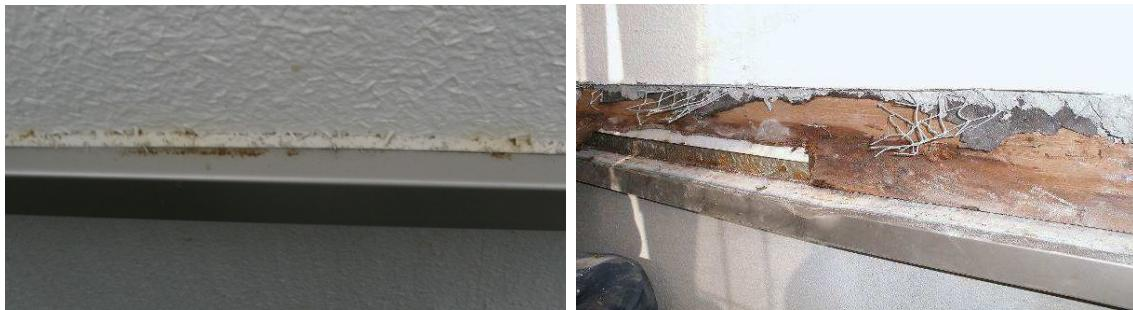
**写真 3.3.4 モルタル外壁土台水切りの腐食**
