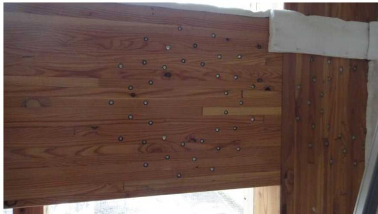
写真 3.7.7-30 ドリフトピンの施工状況
