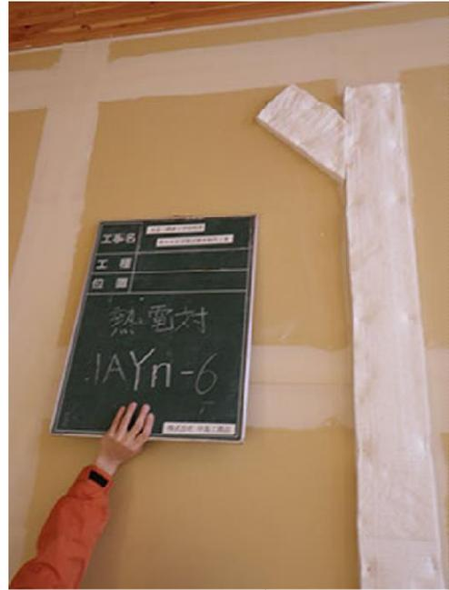
写真 3.5.3-4 熱電対の配線状況
