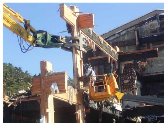
写真 3.7.7-2 構造部材解体・採取の様子
