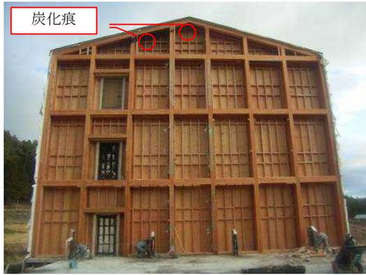
写真 3.7.7-27 合板撤去後の防火壁の状況
