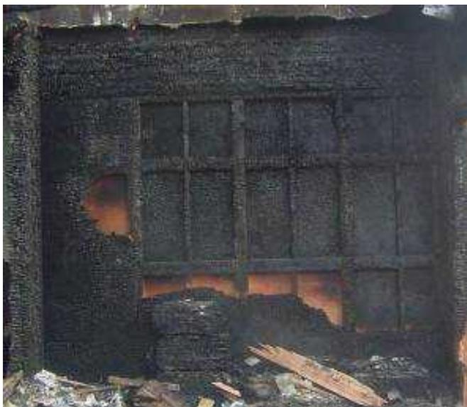
写真 3.7.7-12 1階防火壁側耐力壁の様子
