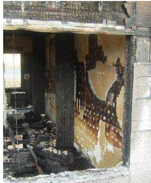
写真 3.7.7-16 2階階段室側耐力壁の様子
