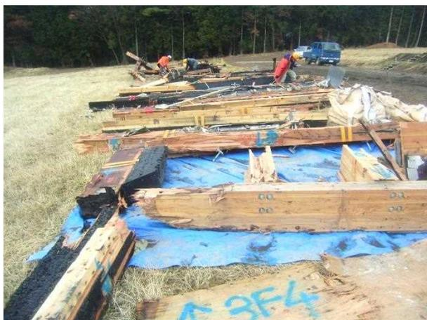
写真 3.7.7-3 解体部材のナンバリング
