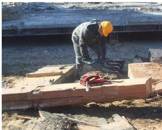
写真 3.7.7-4 解体部材からの断面サンプル採取
