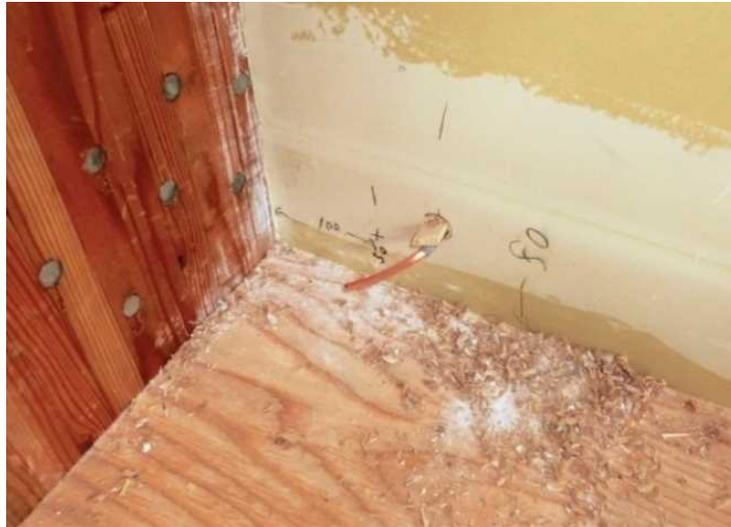
写真 3.5.8-1 微差圧計のチューブの端部（施工中に撮影）
