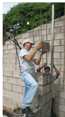
写真2 コンクリートブロック造
