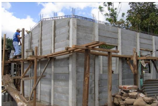
写真1 ブロックパネル造
