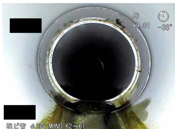
図 2-32 継手ズレの直視画像
