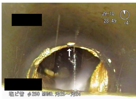
図 2-48 浸入水の直視画像
