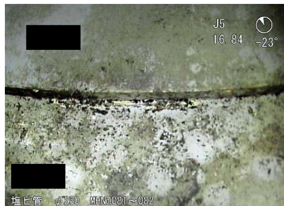
図 2-43 継手ズレの側視画像
