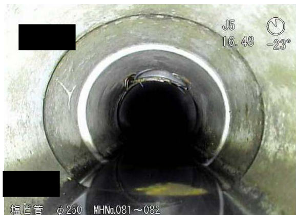
図 2-42 継手ズレの直視画像
