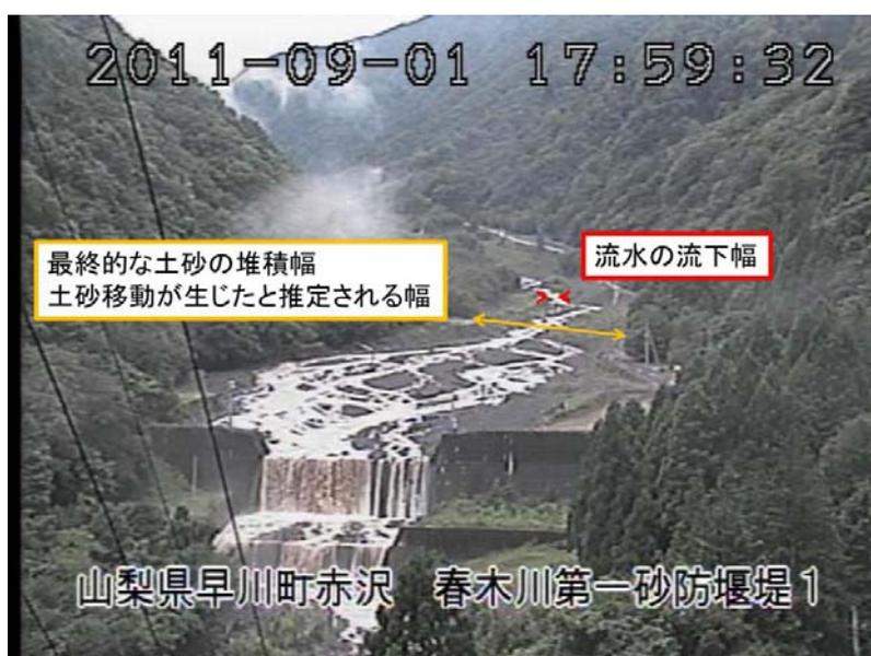
図 2.6 流水の流下幅と最終的な土砂の堆積幅（土砂移動が生じたと推定される幅）
