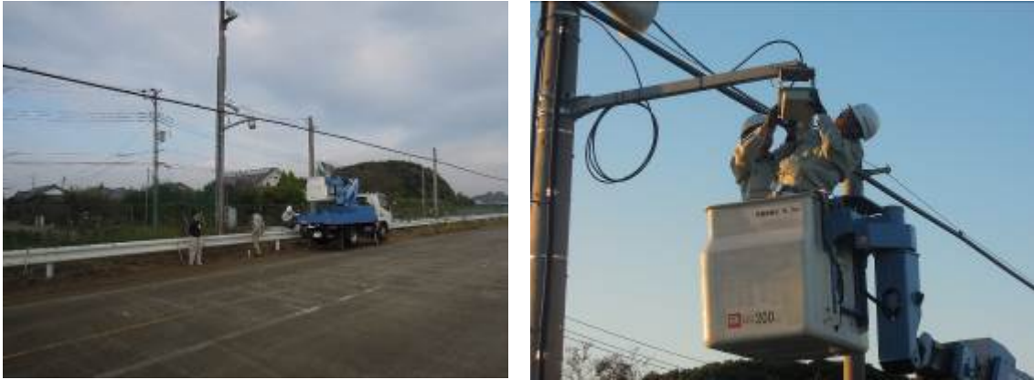
図 4.5-4 高所作業実施状況
