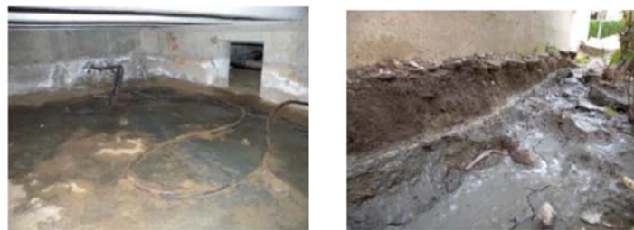
(a) 北東床下屋内 (b) 南西妻側屋外
