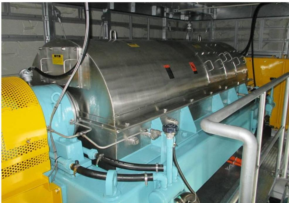
図 2-4 低含水脱水設備（実証設備）
