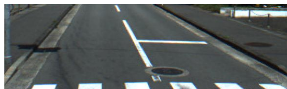
車線と路肩との境界が路面の色彩で明確であり、 車道外側線が省略された例
