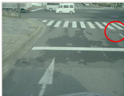
図 29 管理用開口部の見落としが起きやすい事例
