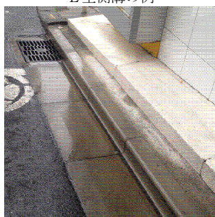
L型側溝の例
