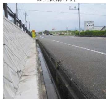
U型側溝の例
