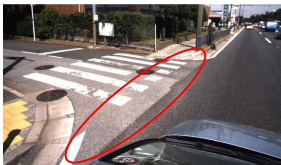
図 28 舗装の色彩の変化による側溝の誤認識の例
