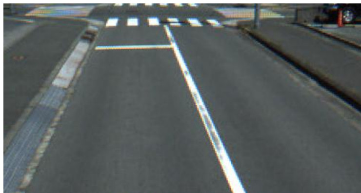
図 23 車線と側溝の境目を区画線と誤って取得しやすい例
