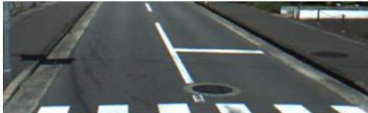
車線と路肩との境界が路面の色彩で明確であり、車道外側線が省略された例
