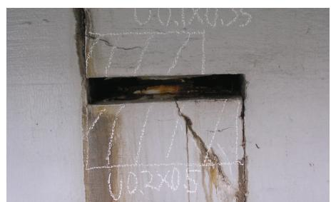
写真-5.2.8 ゲルバー部のひび割れ
