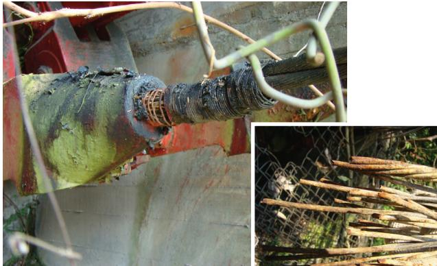
写真-5.1.32 吊橋ケーブル定着部の破断の例
