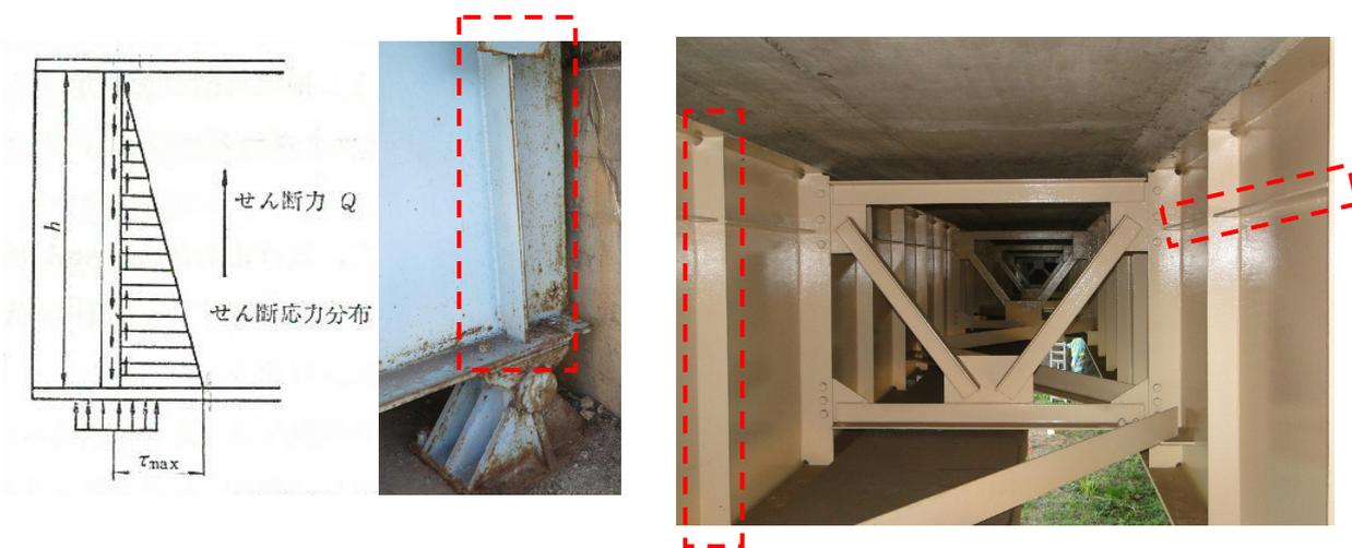
図-3.1.15 鋼部材の座屈崩壊を防止するために設置する補剛材の例
