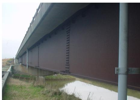
図- 3.1.5 耐候性鋼材の使用例
