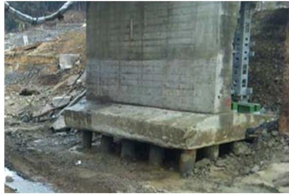
図-3.2.10 河床低下や洗掘を受けた橋の例
