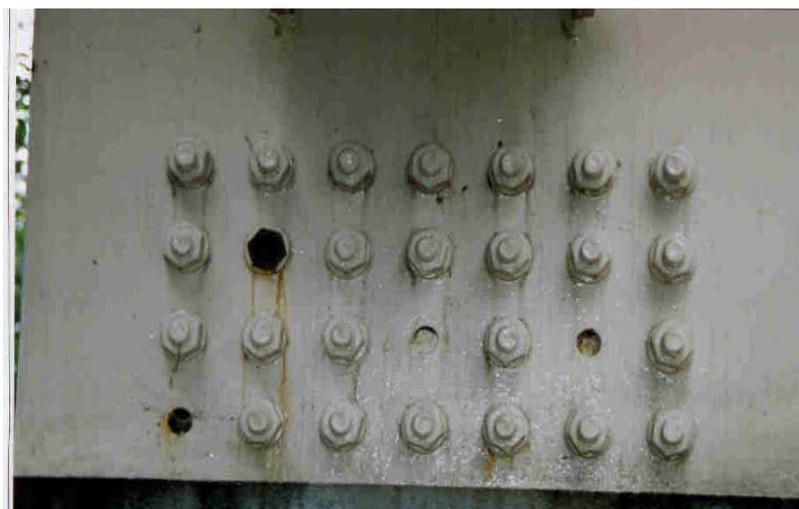
図-3.2.2 遅れ破壊が生じたボルトが脱落した接合部の例
