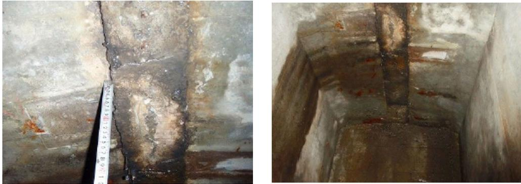
図-3.2.6 PCT 桁の間詰め部の写真（漏水、さび汁）
