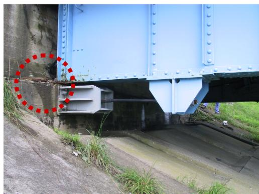
図-3.1.29 落橋防止構造の機能(地震後)
