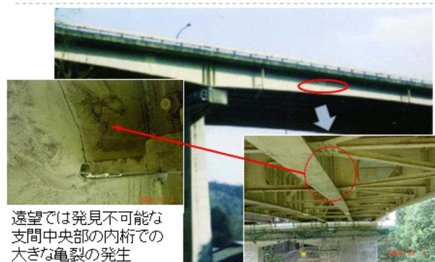
遠望では発見不可能な支間中央部の内桁での大きな亀裂の発生
