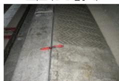
土圧(側溝・監査歩廊変形)
