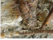
PC鋼材の著しい腐食・破断
