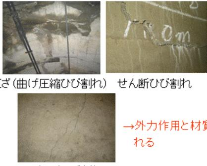
圧ぎ(曲げ圧縮ひび割れ)    せん断ひび割れ    →外力作用による
