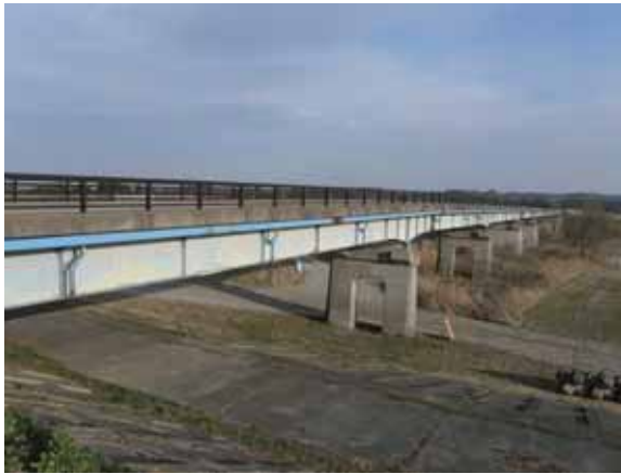
写真-4.2.11.1 志田橋(左岸 A1 側より)
