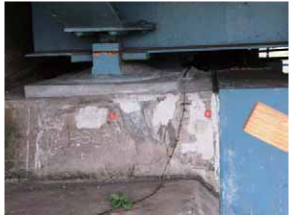
写真-4.3.15.7 沓座コンクリートの修復状況 (A2 橋台)
