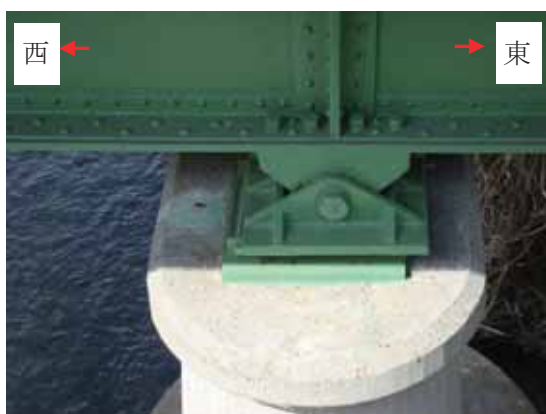
写真-4.4.2.6 P2 支承の移動
