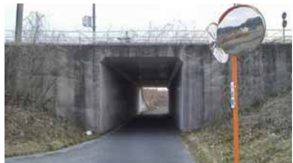
写真-4.3.4.3 矢田川橋の左岸側に隣接するボックスカルバート(右が矢田川橋)
