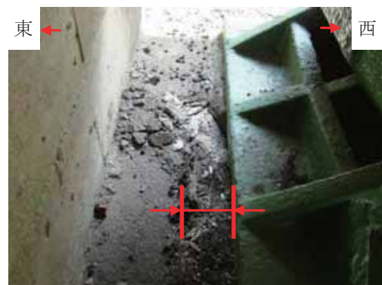
写真-4.4.2.3 A1 橋台支承の移動
