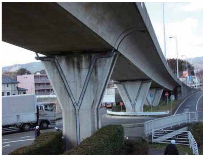
写真-4.4.1.1 高戸大橋
