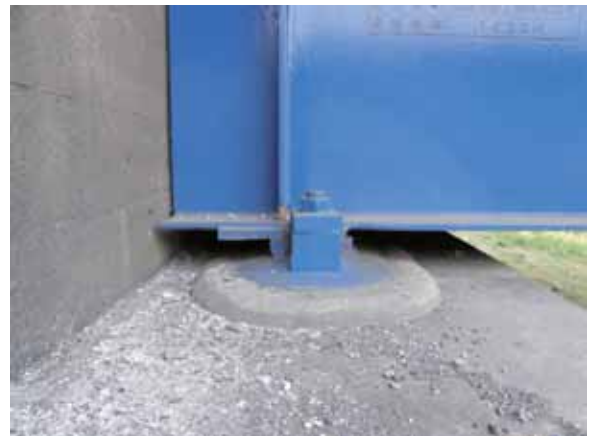
写真-4.4.13.17 右岸側橋台と桁端部
