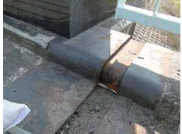
写真-4.4.7.2 A1 橋台上の伸縮装置の状況
