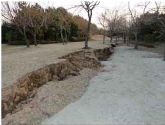
(a) 美浜大橋近傍の公園の地盤に生じた段差
