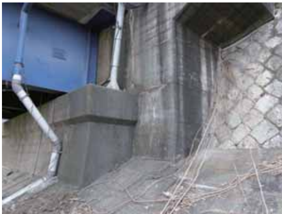
写真-4. 4. 13. 4 右岸側橋台部側面の状況
