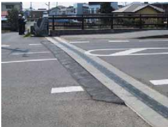
写真-4.4.19.2 段差補正後の様子 (左岸側橋台部)
