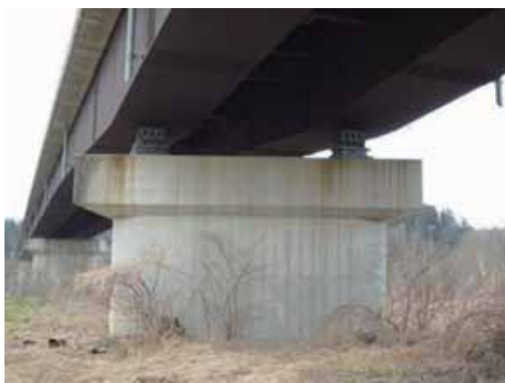
写真-4.1.7.8 P6 橋脚(A2側より)
