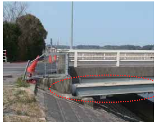
写真-4. 4. 20. 3 右岸下流側の添架物
