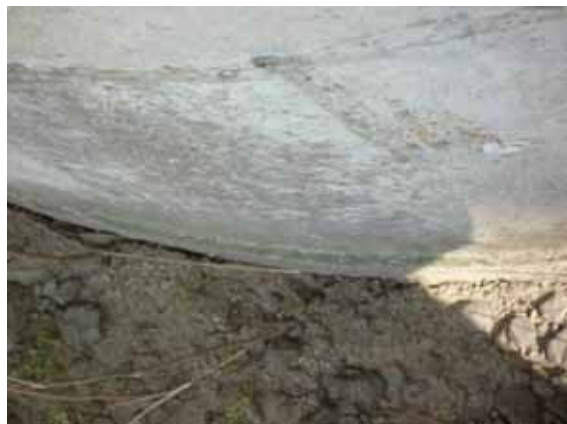
写真-4. 2. 10. 15 P2 橋脚基部
