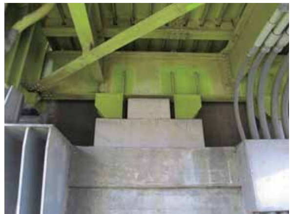
写真-4.4.28.5 A2 橋台支承部前面の状況
