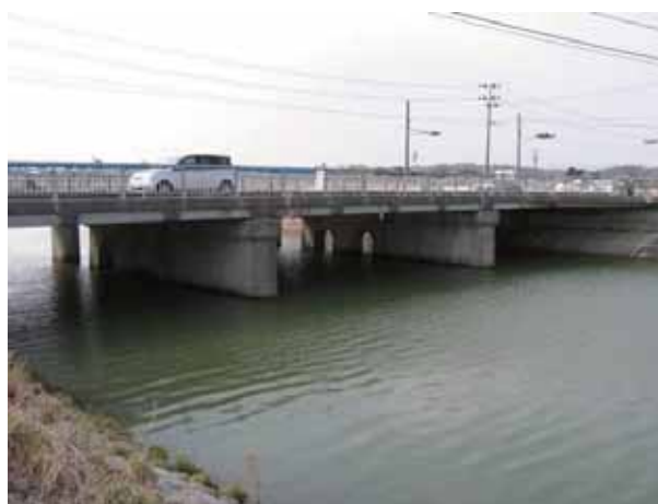
写真-4.3.3.1 滑津橋(東側より)
