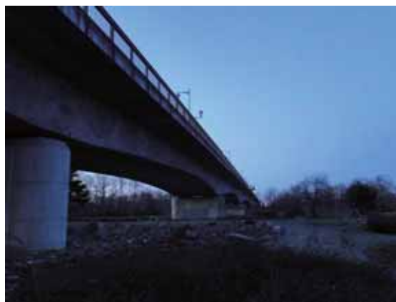
写真-4.1.10.1 九年大橋
