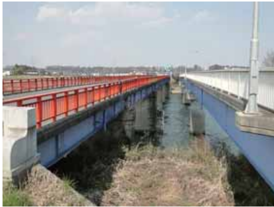
写真-4.4.9.1 勝田橋(左)と側道橋(右)
