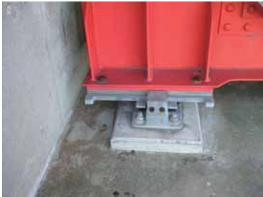
写真-4.5.1.21 側道橋A1 橋台支承部
