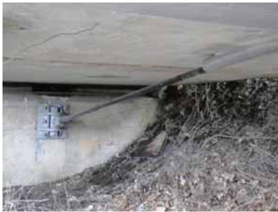
写真-4.1.9.2 左岸側橋台の落橋防止構造
