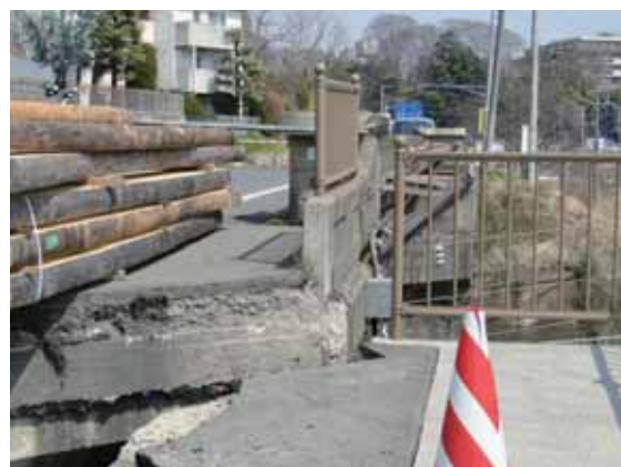
写真-4.4.8.3 橋台背面の沈下と橋軸直角方向への横ずれ
