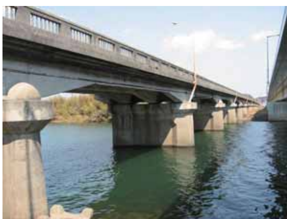
写真-4.3.12.1 旧鮫川橋(右岸(南)下流側 より)
