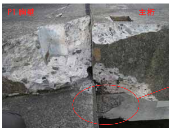
写真-4. 1. 20. 5 水門堰柱P1 支点主桁端部の損傷状況(上流側より撮影)
