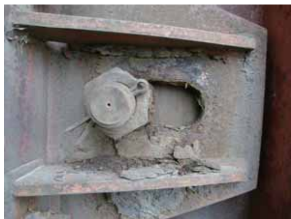
写真-4.2.12.13 A2 橋台上の桁～パラペット連結構造
