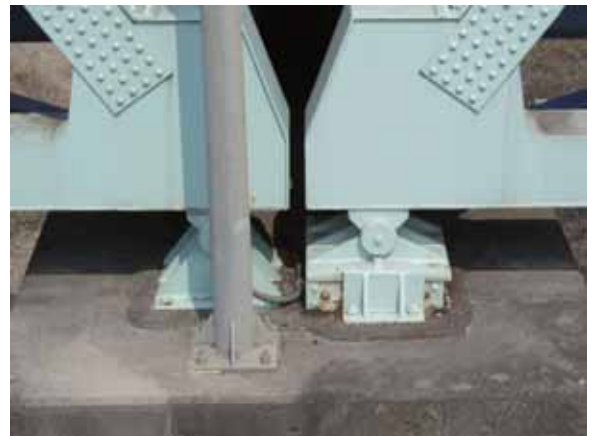
写真-4.4.13.11 左岸側より2脚目の支承
