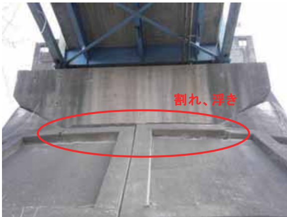
写真-4. 1. 16. 7 左岸橋台前面
