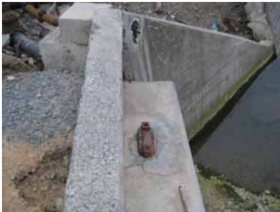
写真-4.2.4.6 大倉橋の支承部
