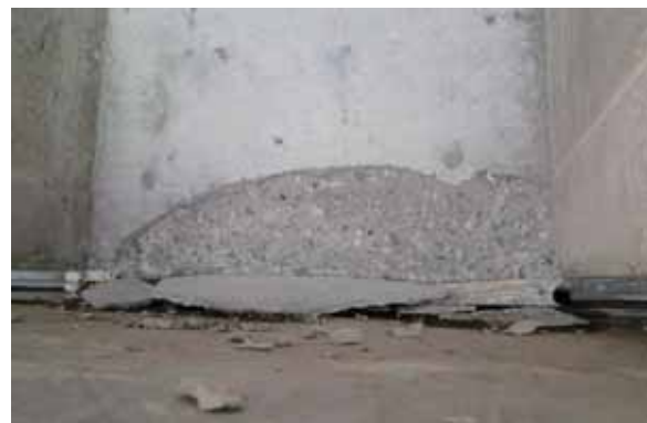
写真-4.1.15.2 左岸側の橋台上の横桁のかぶりコンクリートの剥落
