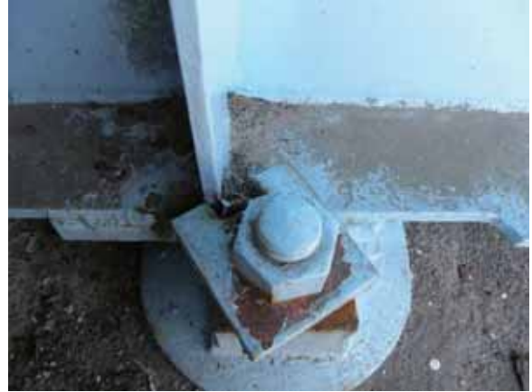
写真-4. 4. 5. 29 A2橋台支承の状況
