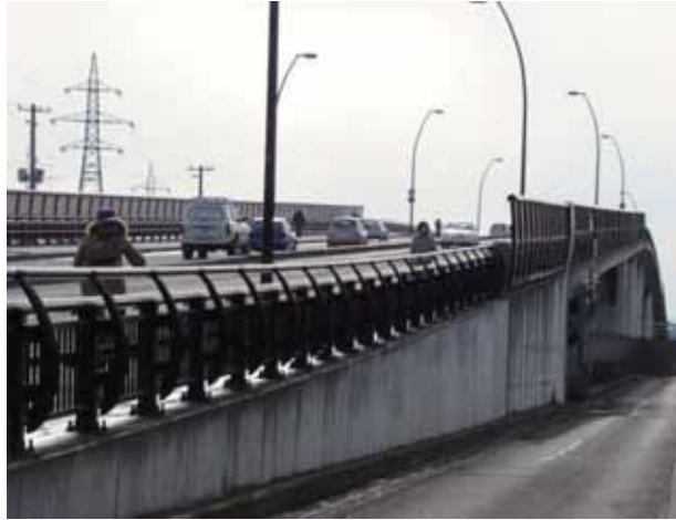
写真-4.2.8.1 宮城野大橋 (A1 側)
