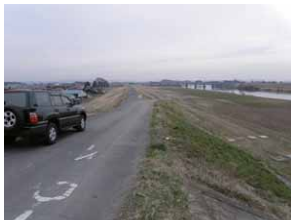
写真-4.2.12.3 左岸側(A2)堤体の状況
