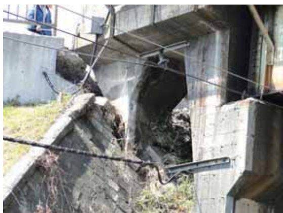
写真-4.4.8.3 橋台背面の沈下と橋軸直角方向への横ずれ
