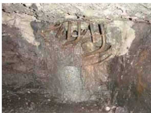
(a) A1 橋台下流側
