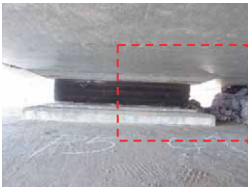
写真-4.3.14.14 P5橋脚上のゴム支承の亀裂(写真提供：福島県)
