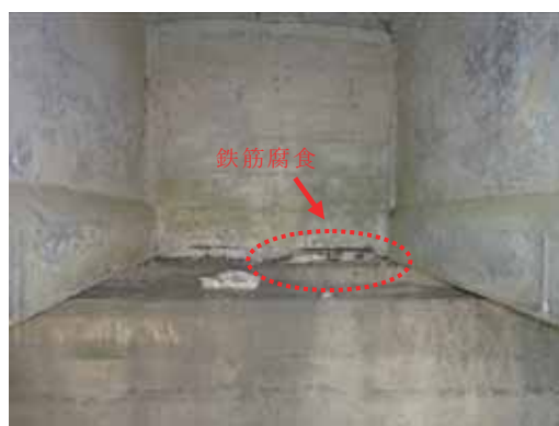
写真-4.4.32.9 橋台端横桁(香取市側)
