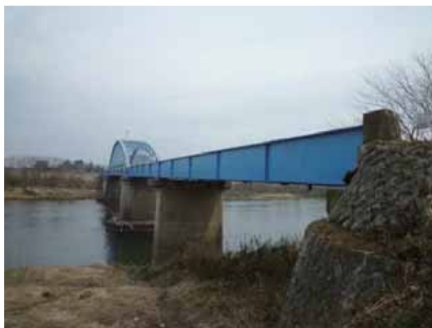
写真-4.1.8.1 昭和橋(右岸 A1 側より)
