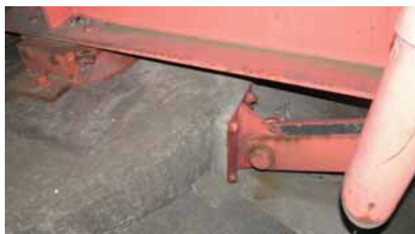
(a) 落橋防止構造
