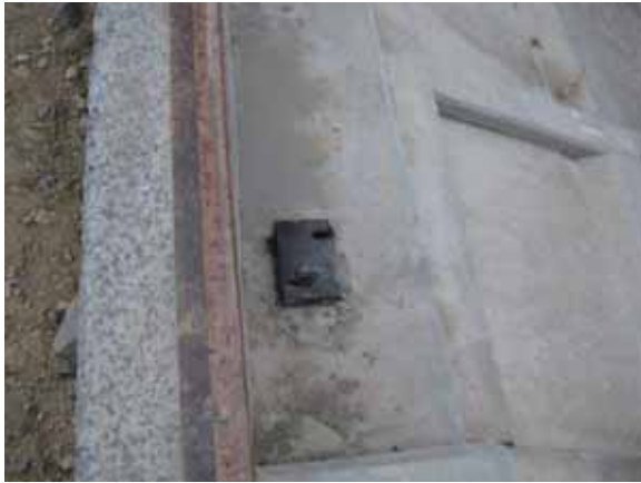
写真-4.2.4.4 揚屋橋の支承部
