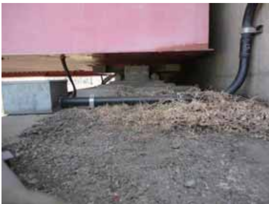
写真-4.4.6.10 A2 橋台支承
