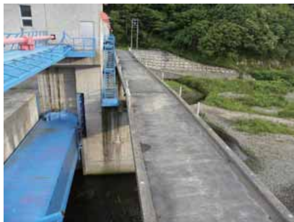
(b) 左岸側より撮影
