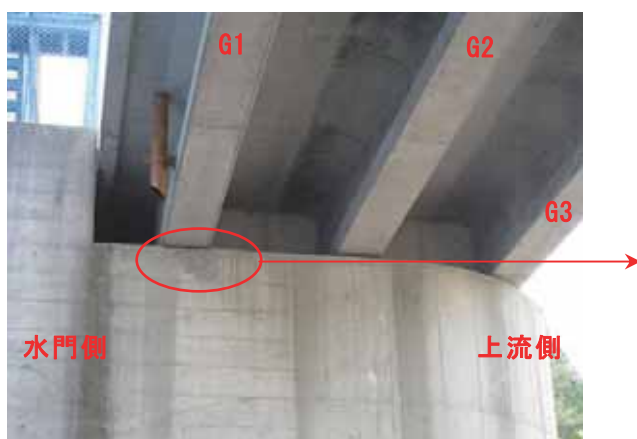
写真-4. 1. 19. 12 水門堰柱P3 の橋座の損傷状況 (G1 桁部のみ剥落)
