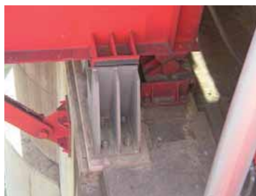
写真-4.5.1.7 P3 橋脚支承部の状況 (下流側より)
