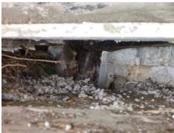
(b) アンカーバーの変形(60mm)
