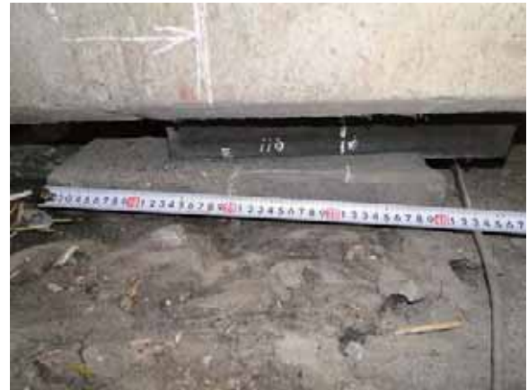
(b) ゴム支承の側方への移動 (110mm) (G4 主桁)
