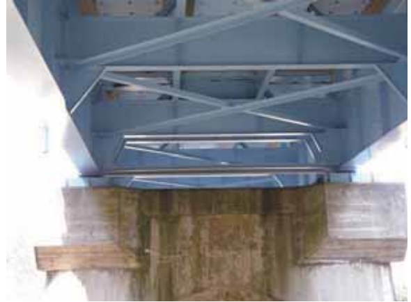
写真-4.4.5.23 P3 橋脚上の上部構造の 状況：ニーブレース等の損傷見られず
