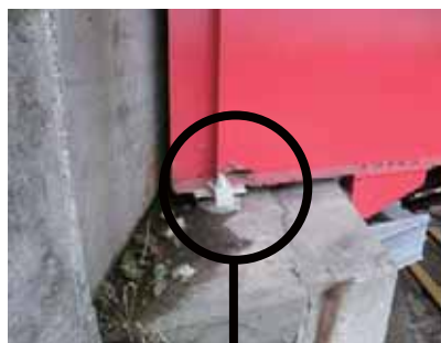
写真-4.2.16.10 橋台のベントの設置状況
