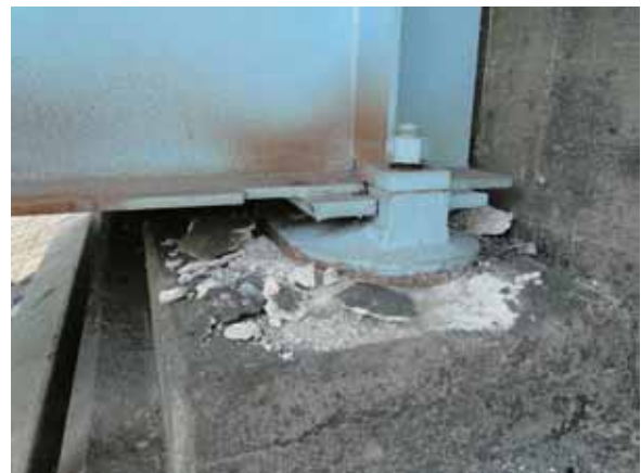
写真-4.4.5.15 A1橋台下流側支承部側面の状況
