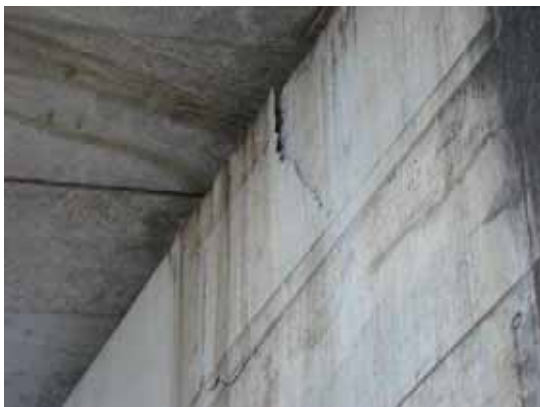
写真-4.2.8.3 橋脚天端の損傷(西側主径間部)
