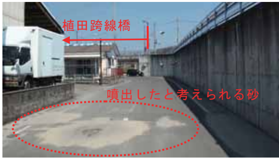
写真-4.3.8.21 東側橋台部近隣の状況
