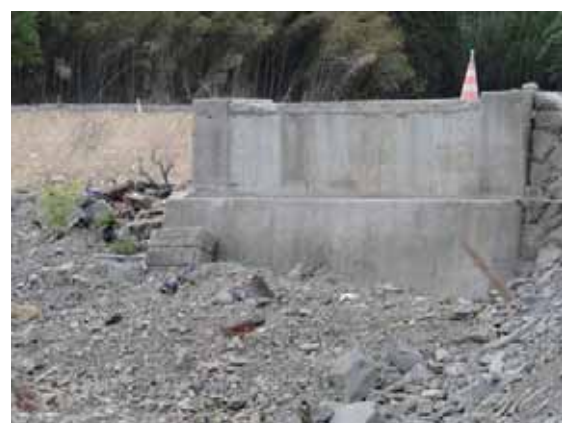
写真-4.2.3.6 左岸側橋台の状況
