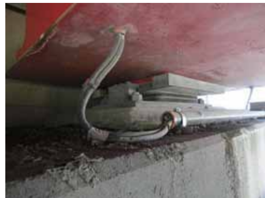
写真-4.4.6.11 A2 橋台支承側面
