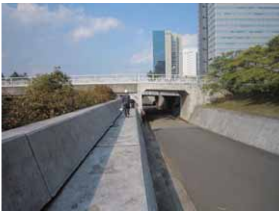
写真-4.5.3.2 中浜橋周辺の状況
