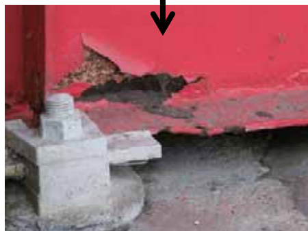
写真-4.2.16.11 橋台に生じたひび割れ 及び鋼桁の塗膜のはがれの状況
