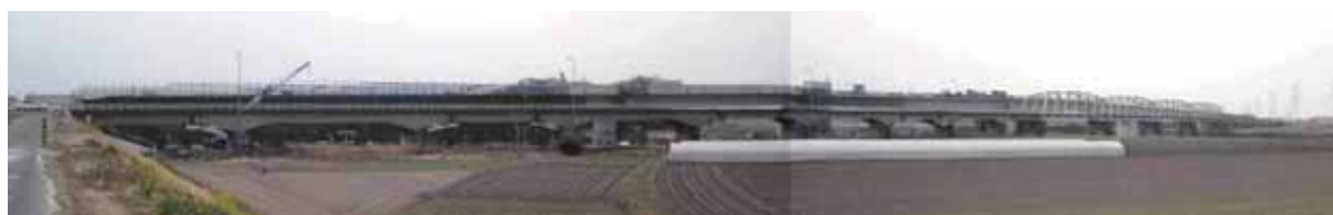
写真-4.4.15.1 鬼怒川大橋(筑西市、上流側から撮影)
