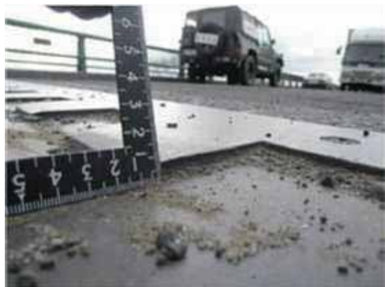
写真-4.2.16.7 A2 橋台部の伸縮装置の段差 (8mm) (資料提供：宮城県)
