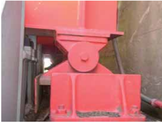
写真-4.5.1.19 A2 橋台支承部
