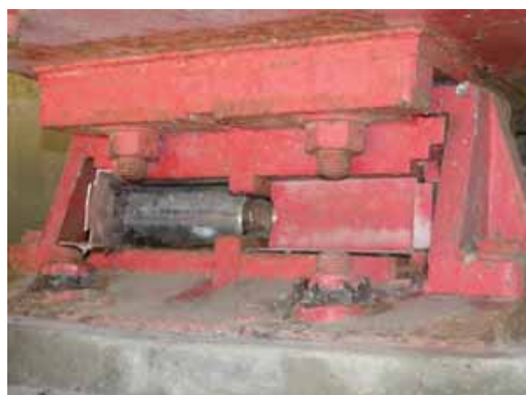
写真-4.1.14.2 江刺側の橋台上の可動支承のローラーカバーのはずれ
