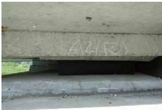
写真-4.2.15.2 A2 橋台支承部支承に変 形、損傷は見られない
