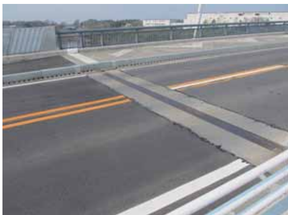
写真-4.4.29.2 A1 橋台上の路面状況
