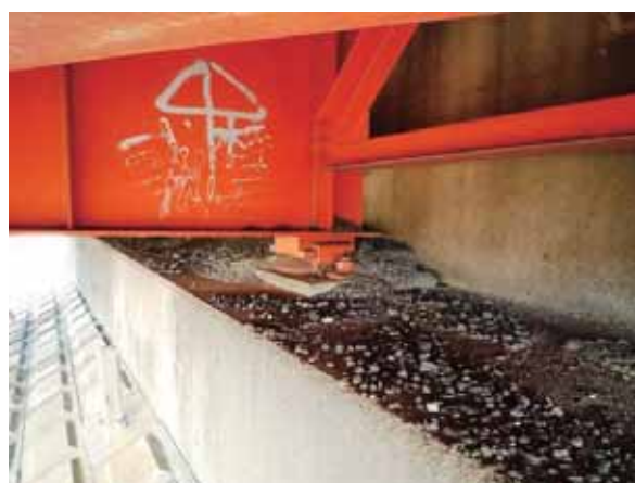
写真-4.4.27.3 桁端部の状況
