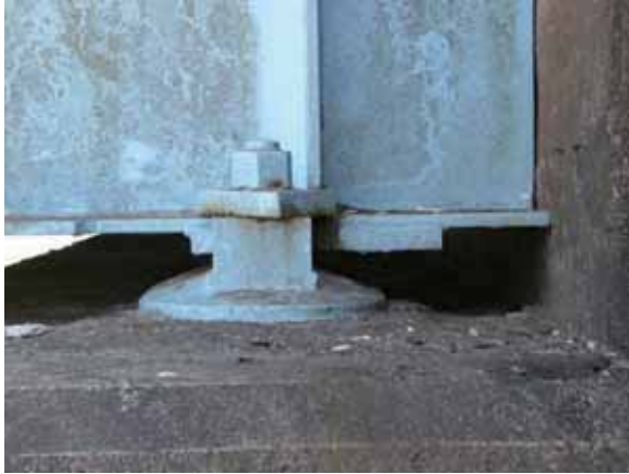
写真-4. 4. 5. 28 A2橋台側桁端部の状況
