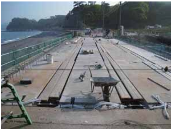
写真-4.1.17.9 新たに架設されている 上部構造の建設状況(橋面)
