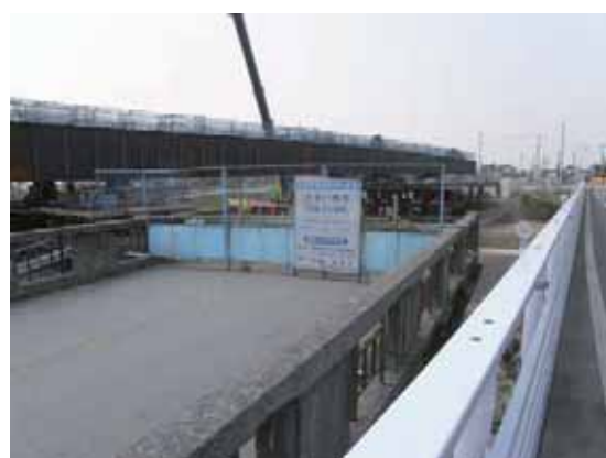
写真-4. 4. 26. 6 右岸側橋梁撤去部
