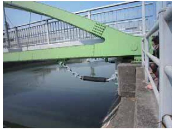
写真-4.5.9.2 落橋防止構造(左岸)
