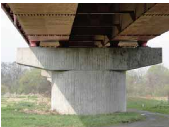
写真-4.1.14.3 江刺側から 1 基目の橋脚のひび割れ
