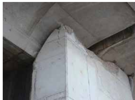
写真-4.2.8.3 橋脚天端の損傷(西側主径間部)
