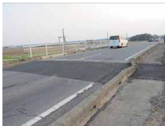
写真-4.4.25.3 橋台背面段差の修復状況(東側橋台)
