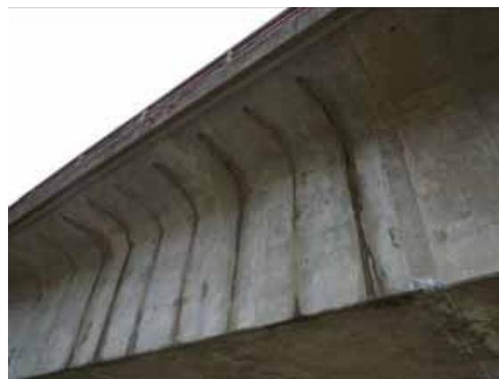
写真-4.1.9.8 上部構造の状況
