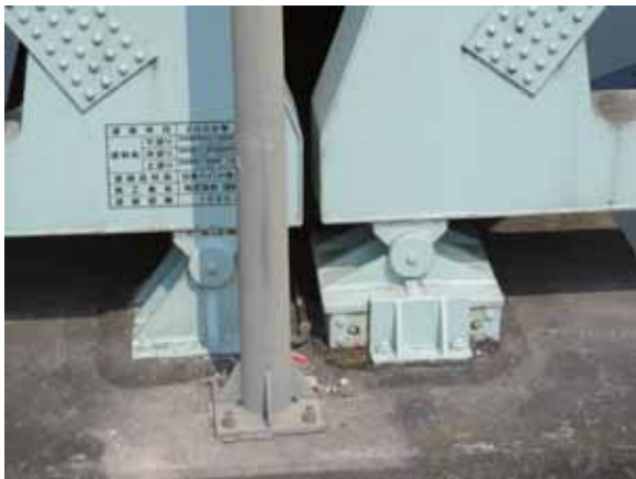
写真-4.4.13.10 左岸側より1脚目の支承
