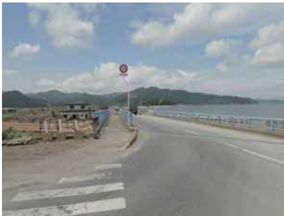
写真-4.2.5.1 富士川橋(右岸側より)
