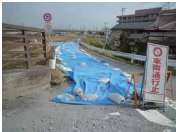
写真-4. 2. 10. 2 右岸(江合橋 A1 下流側)の 堤体状況：堤体上の道路は通行止め
