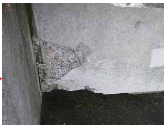
写真-4. 1. 20. 5 水門堰柱P1 支点主桁端部の損傷状況(上流側より撮影)
