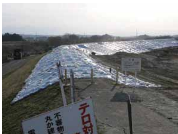
写真-4.2.11.3 右岸(A1 下流側)の堤体 状況：堤体上の道路は通行止めの状況
