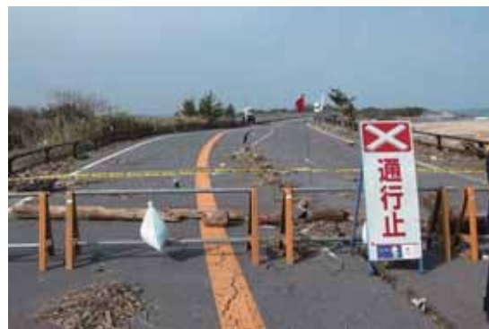
写真-4.3.2.6 南側橋梁アプローチ部の状況
