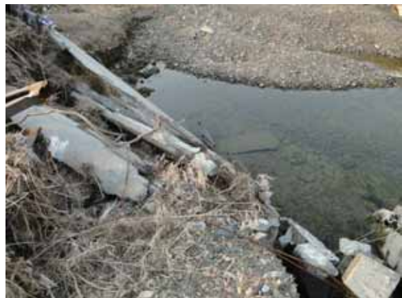
写真-4.2.1.3 パイルベント橋脚の損傷状況
