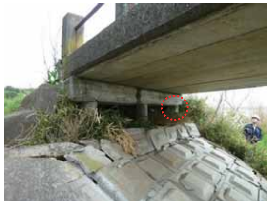
写真-4. 4. 14. 5 左岸側橋台部
