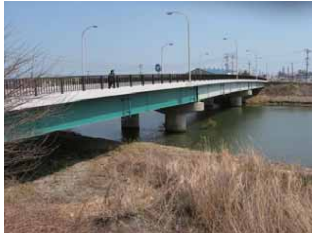
写真-4.3.6.1 芳川橋(東側より)
