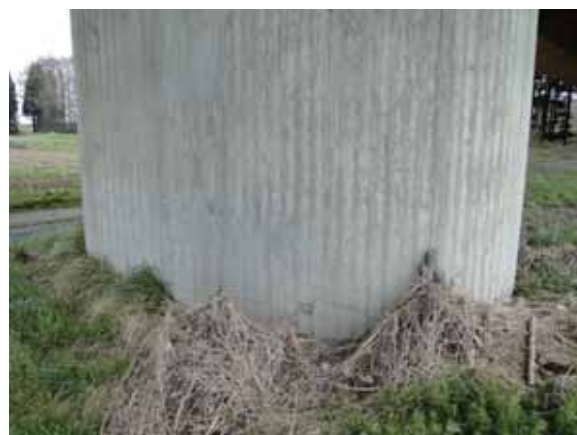
写真-4.1.14.3 江刺側から 1 基目の橋脚のひび割れ
