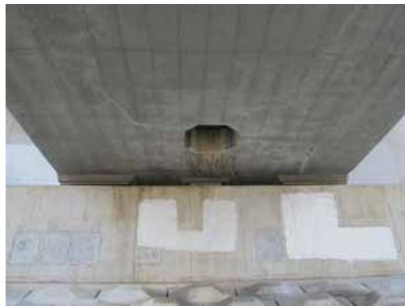
写真-4. 4. 29. 8 A1 橋台側箱桁下面の状況
