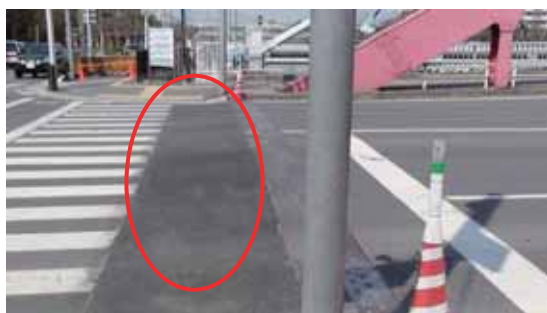
写真-4.5.8.2 右岸側橋台背面(復旧後)
