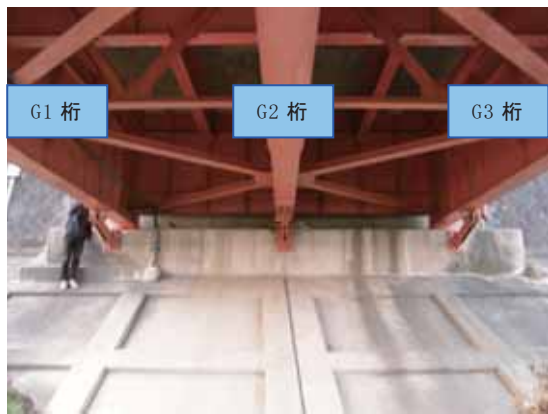
写真-4.3.17.2 A2 橋台
