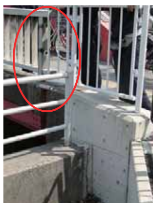
写真-4.5.8.3 橋梁側高欄と橋台背面側高欄の衝突
