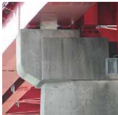
(b) 河川内 P3 橋脚
