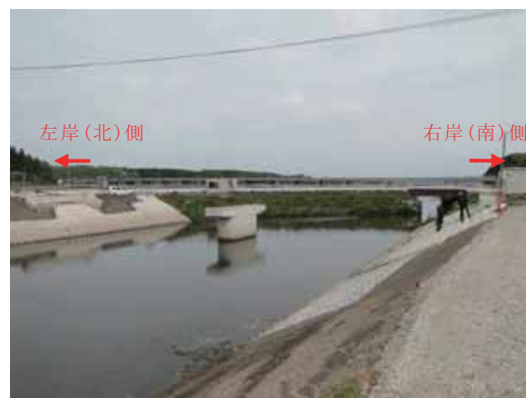
写真-4.4.10.1 新中丸橋(上流側より)
