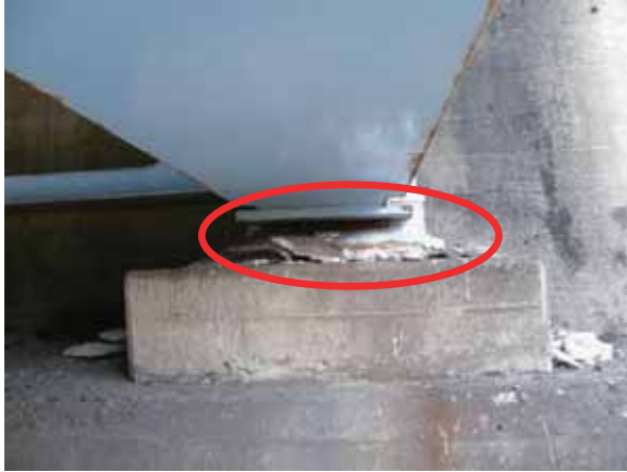
写真-4.4.5.16 A1橋台下流側支承部前面 の状況
