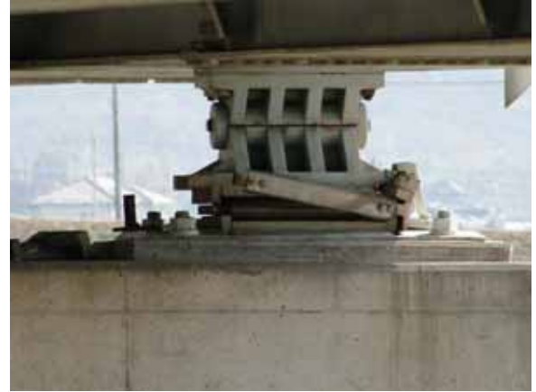
(b) 下流側の桁を支持する支承
