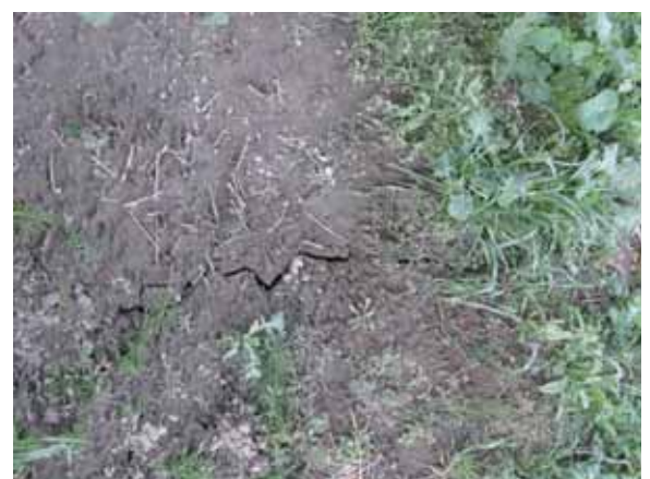
写真-4.4.28.7 高水敷での地盤のひび割れ
