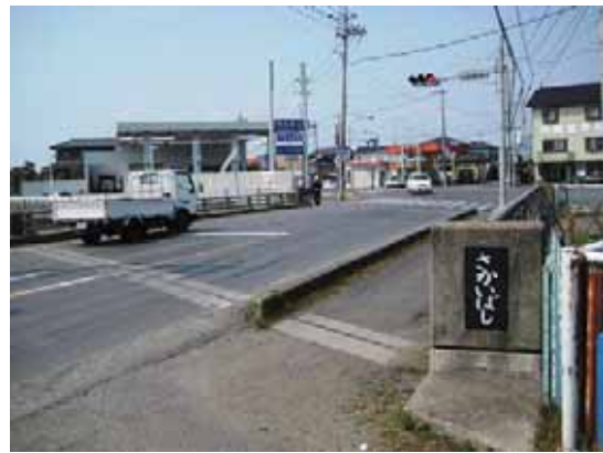
写真-4.4.18.3 橋梁の状況(東南側より)
