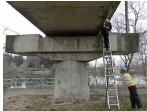
写真-4.1.9.3 中間部の橋脚における桁かかり長の拡幅等を確認
