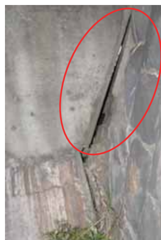
写真-4. 3. 17. 11 橋台躯体部と背面擁壁の隙間 (A2 橋台)
