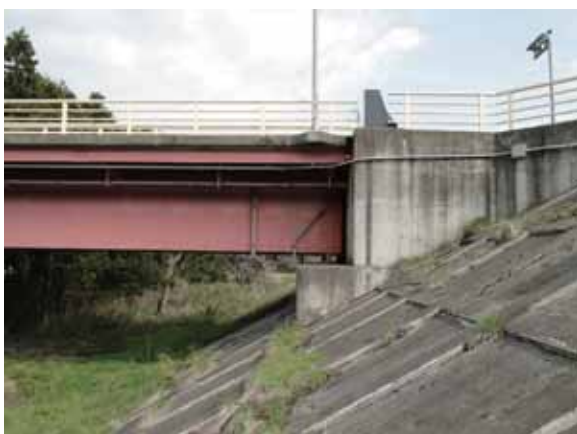
写真-4.1.14.2 江刺側の橋台上の可動支承のローラーカバーのはずれ
