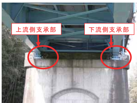
写真-4.4.5.2 P6 橋脚 (P7 橋脚側より)
