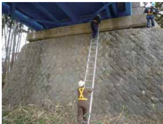
写真-4.1.8.3 右岸側 A1 橋台
