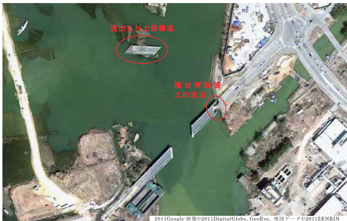
写真-4.2.6.1 橋の流出状況
