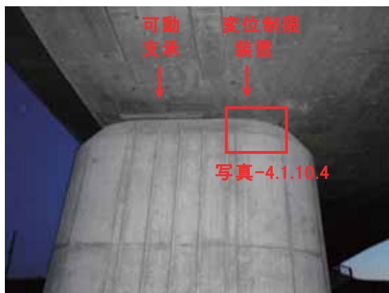
写真-4.1.10.2 P7 橋脚の柱頭部
