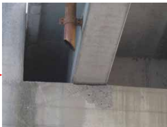
写真-4. 1. 19. 12 水門堰柱P3 の橋座の損傷状況 (G1 桁部のみ剥落)
