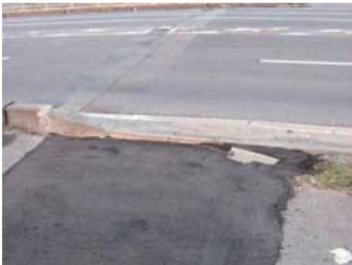
写真-4.3.4.2 左岸(東)側橋台背面歩道部の補修状況
