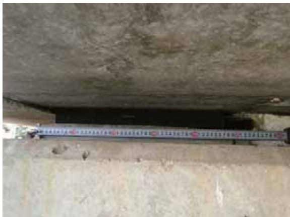
(a) ゴム支承の状況 (変形なし)
