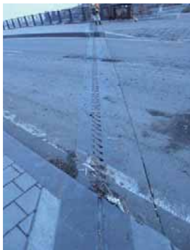
写真-4.1.1.2 桁端部の状況(段差等なし)
