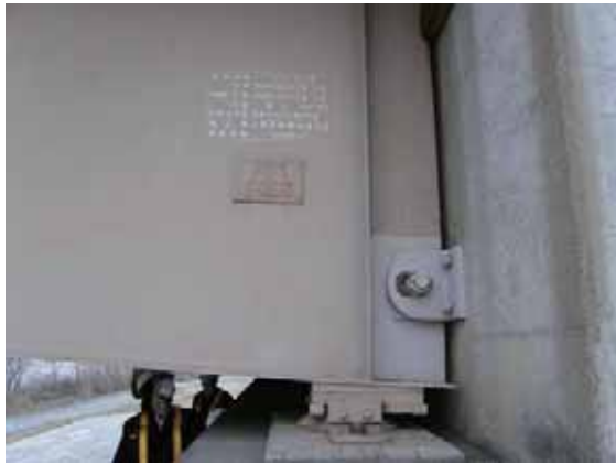
写真-4.2.13.14 A2 橋台側桁端部
