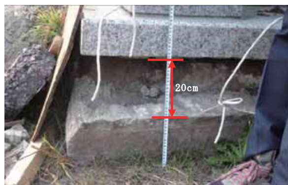
写真-4.4.32.5 橋台背面部の段差 (香取市側)
