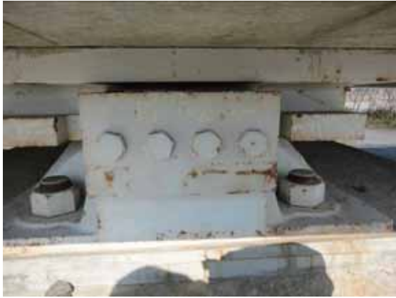
写真-4. 4. 3. 16 P1 橋脚の支承：損傷は確認されず
