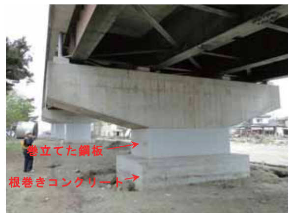
写真-4.2.7.10 鋼板巻立て補強されたRC橋脚の状況
