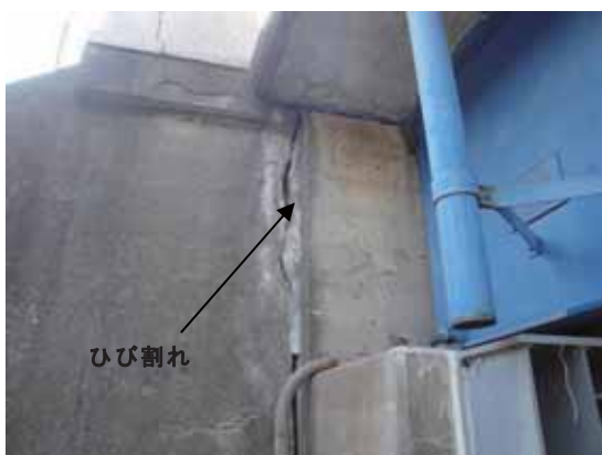
写真-4.4.9.3 橋台(右岸側)
