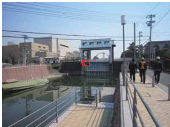
写真-4.5.10.6 境川東水門全景(上流側)
