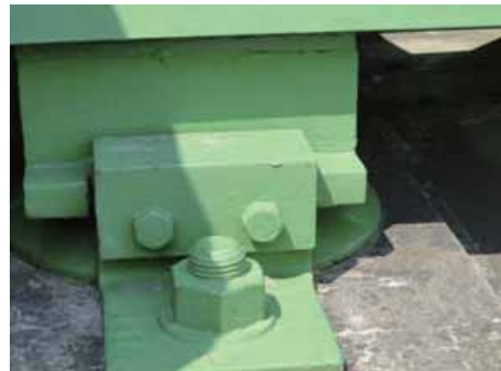
写真-4.5.9.4 固定支承(右岸側)
