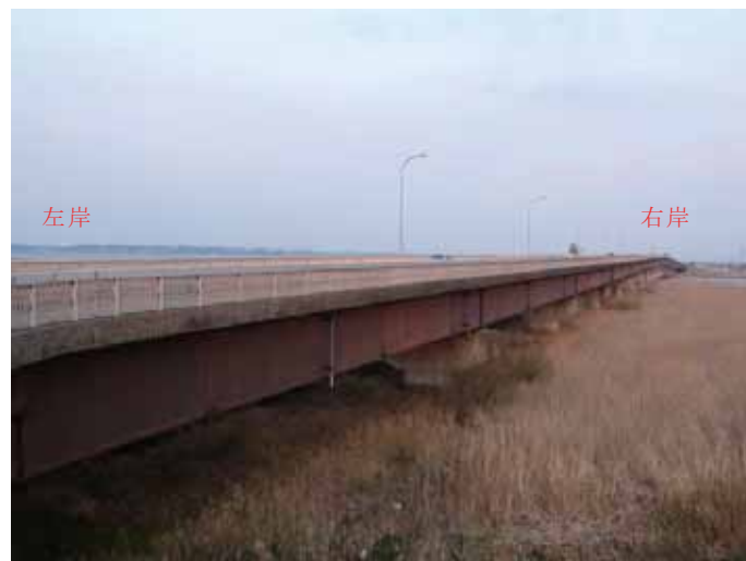
写真-4.4.31.1 稲敷大橋(左岸側より)
