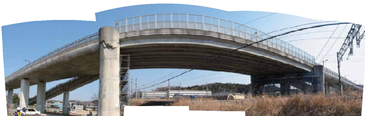
写真-4.3.8.1 植田跨線橋の跨線部(南側より)
