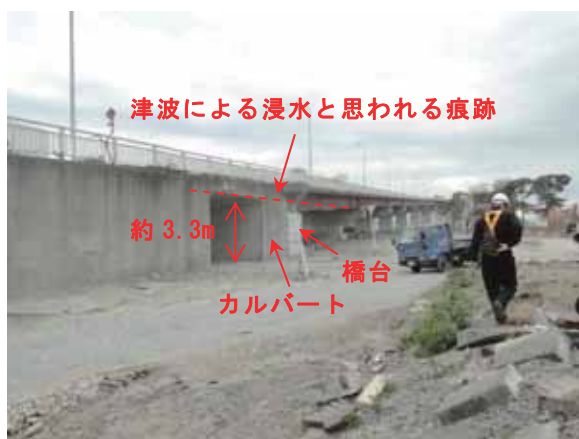
写真-4.2.7.3 左岸側橋台周辺の状況
