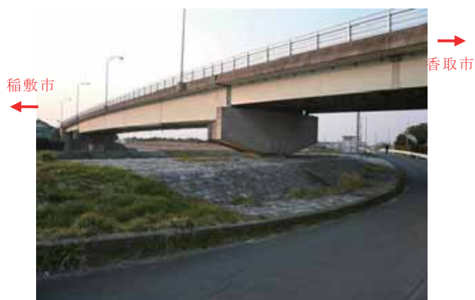
写真-4.5.11.1 横利根大橋(香取市側より)
