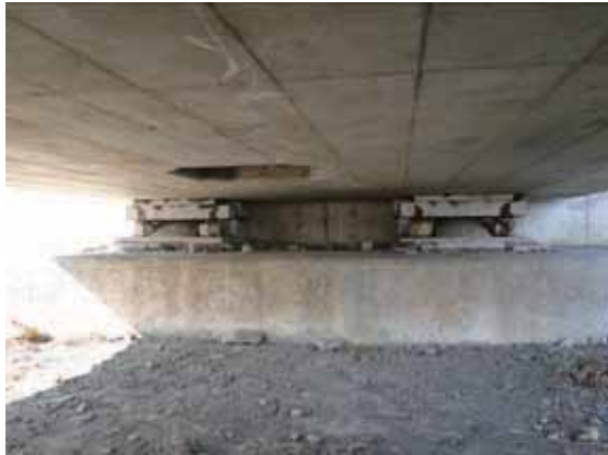
写真-4.4.3.10 A1 橋台支承の状況
