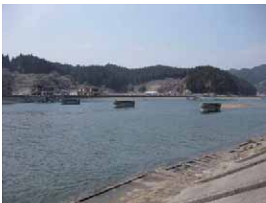
写真-4.1.2.1 上部構造が流出した姉齒橋
