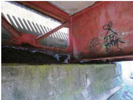
写真-4. 4. 23. 8 支承部の状況(右岸側)
