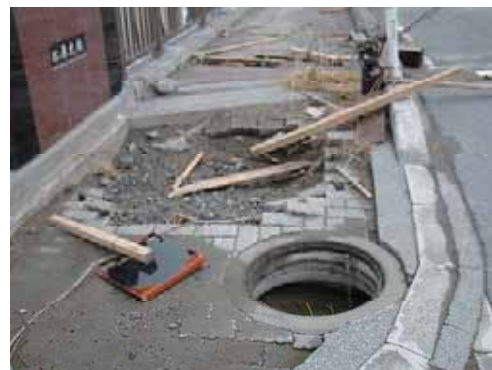
写真-4.1.5.3 橋台背面の状況
