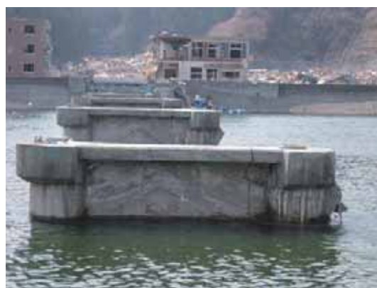
写真-4.1.2.3 下部構造のひび割れ
