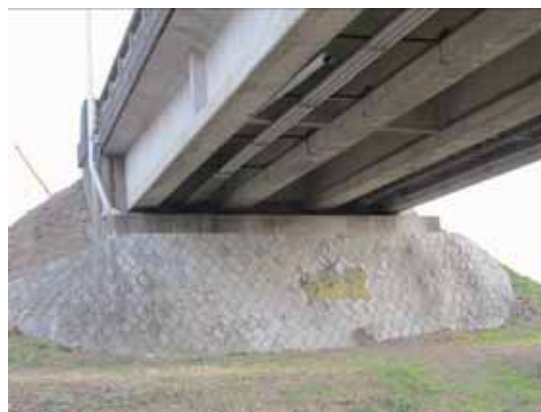
写真-4.4.11.2 橋台部の状況(左岸側)
