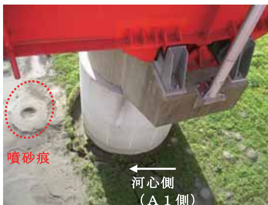
写真-4.5.1.11 P7 橋脚基部の状況 (下流側より)
