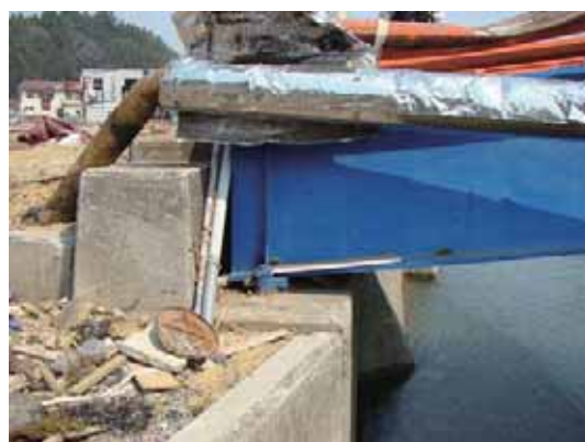
写真-4.2.2.3 支承部の状況
