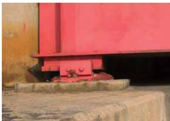
写真-4.3.1.4 北側橋台部の可動支承
