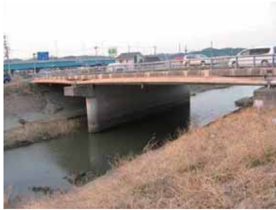
写真-4.3.4.1 矢田川橋(東側より)
