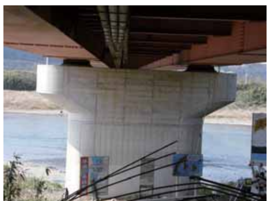
写真-4.4.6.16 P1 橋脚の状況
