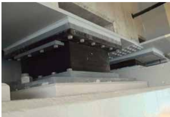
写真-4. 3. 11. 4 橋台部の支承(機能分離)
