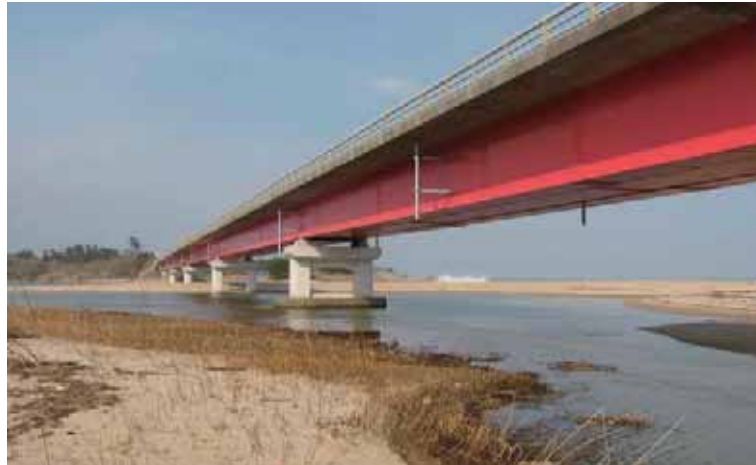
写真-4.3.2.1 磐城舞子橋(南側より)
