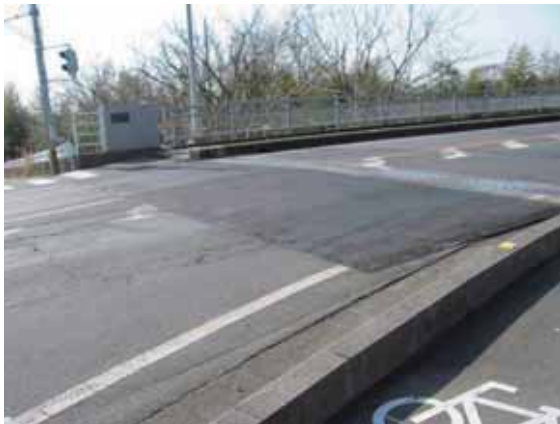
写真-4.3.10.4 橋台背面の段差修復状況
