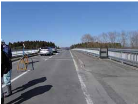
写真-4.1.12.14 A2 橋台付近の状況
