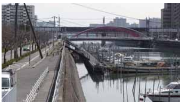
写真-4.5.9.5 左岸全景(今川橋～境川中央歩道橋間)
