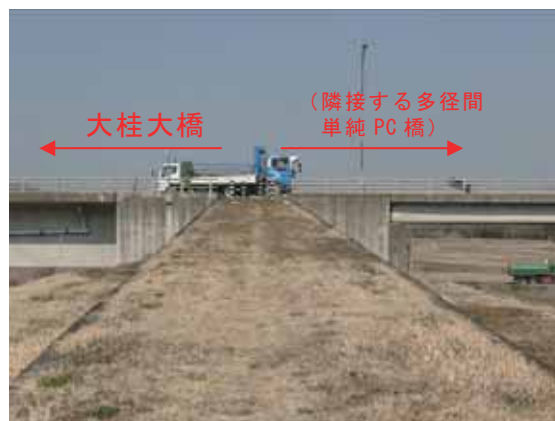
写真-4.4.3.3 左岸(A2)橋台側の盛土
