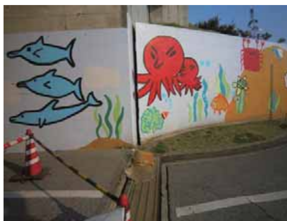
(b) 橋台躯体とそで擁壁との間に生じた隙間
