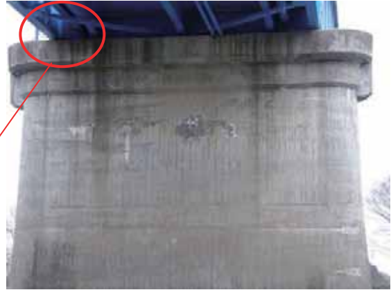
写真-4.1.8.5 P1 橋脚
