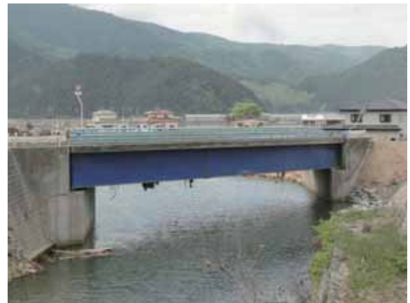
写真-4.2.5.2 富士川橋(下流側より)
