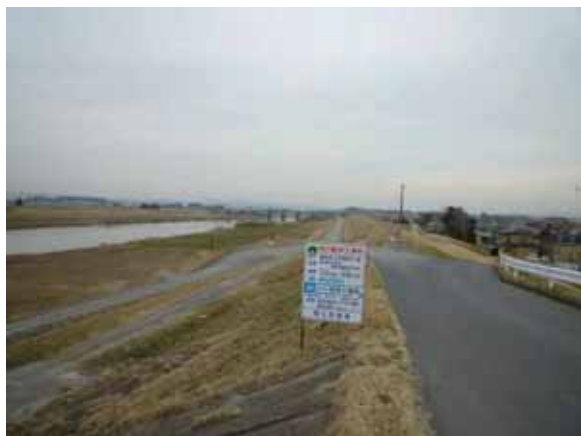
写真-4.2.12.2 右岸側(A1)堤体の状況
