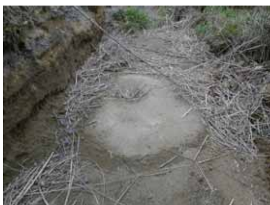
写真-4. 4. 14. 23 噴砂の状況 (東水神橋から約 200m 離れた地点)
