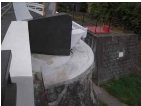
写真-4.3.15.4 橋台背面のブロックの修復状況 (A1 側)
