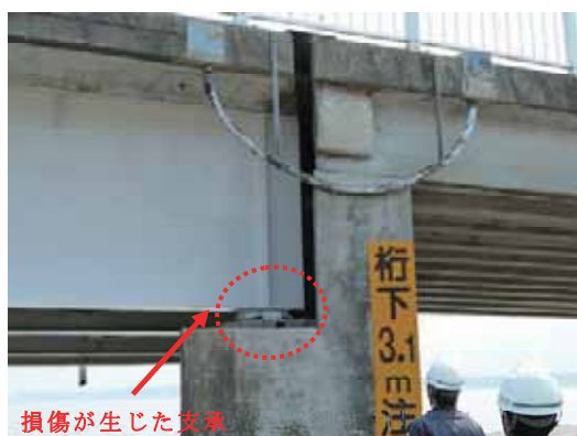
写真-4.4.30.4 P29 橋脚支承部付近
