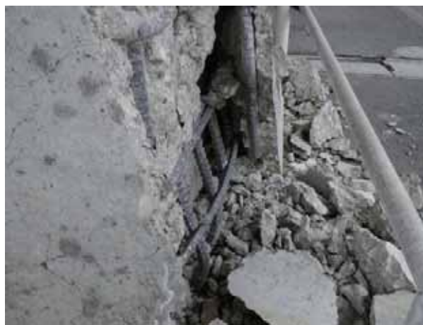
写真-4.2.19.3 4月7日の余震後のP2橋脚の損傷(資料提供:宮城県)
