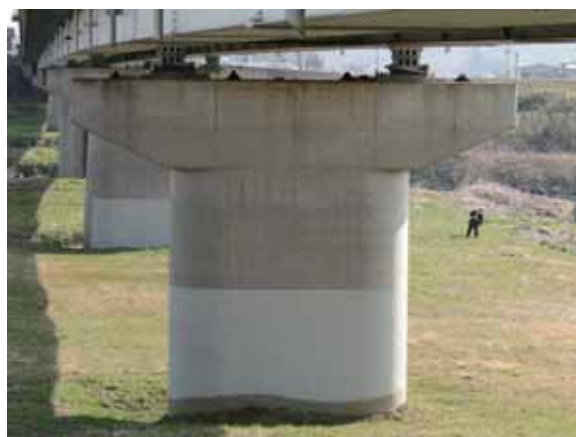
写真-4.4.7.11 P5 橋脚
