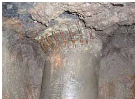
(a) A2 橋台下流側の杭の状況
