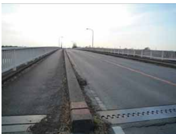
写真-4.4.27.2 橋面の状況
