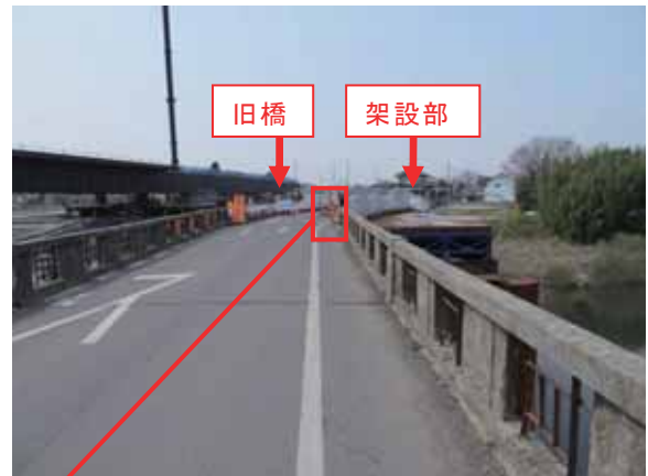
写真-4.4.26.13 旧橋～右岸側架設部
