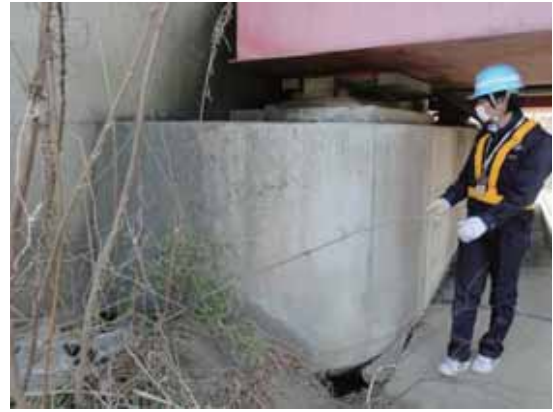
写真-4.4.6.3 A1 橋台前面の状況
