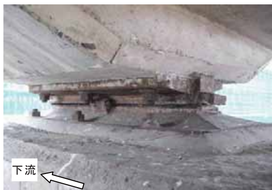
(a) P1 固定支承、ストップ破断
