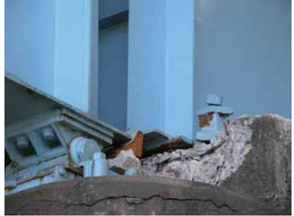
写真-4.4.5.7 下流側支承部の状況 (側面より)
