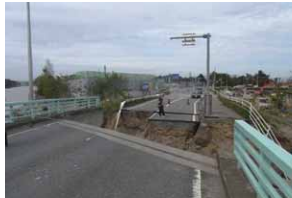
写真-4.2.6.6 左岸側橋台背面盛土の流出状況(橋面より)
