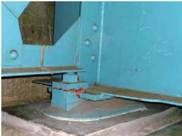
写真-4.3.15.8 支承部の状況 (A1 側 G1 桁)
