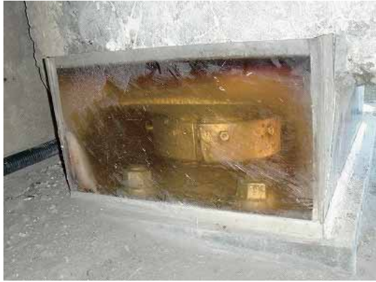
写真-4.2.14.6 支承の状況
