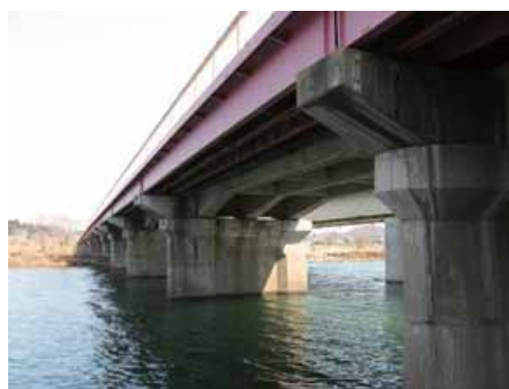
写真-4.3.12.2 旧鮫川橋(右岸(南)上流 側より)
