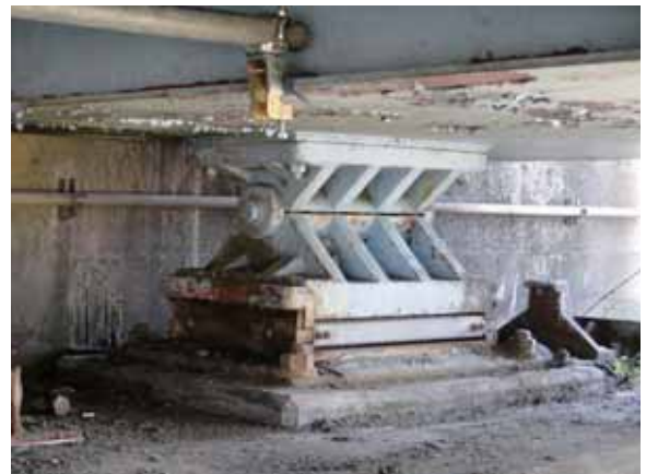
(b) 下流側の桁を支持する支承
