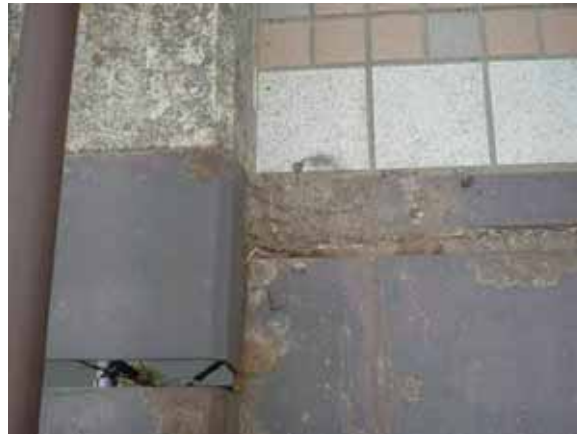
写真-4. 2. 13. 28 P3 伸縮装置路肩部
