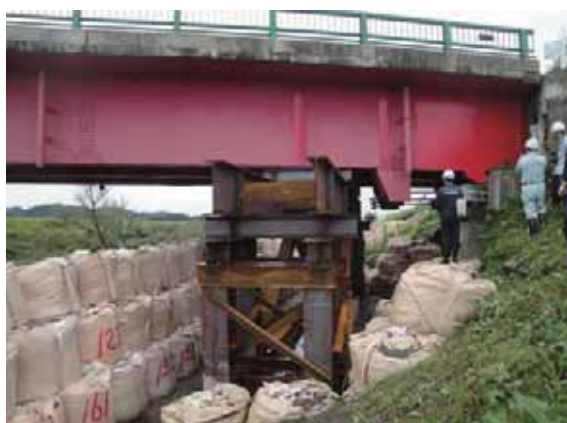
(a) A1 橋台側
