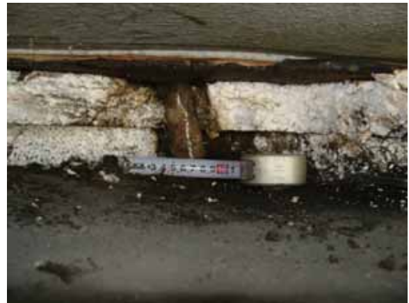
(b) アンカーバーの変形(30mm)
