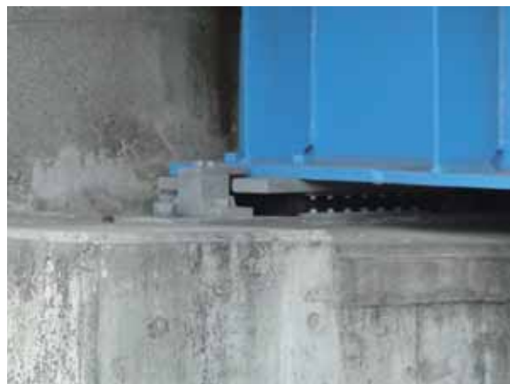
写真-4.5.10.7 支承部の状況
