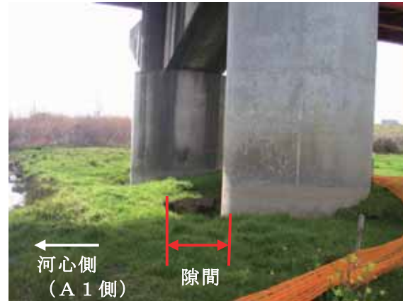
写真-4.5.1.9 P6 橋脚基部の状況 (手前：側道橋、奥：神崎大橋)
