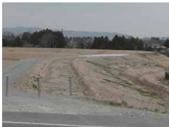
写真-4. 2. 13. 3 左岸側 (A2) 堤体の状況
