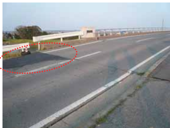
写真-4.5.11.2 稲敷市側橋台部の段差補修
