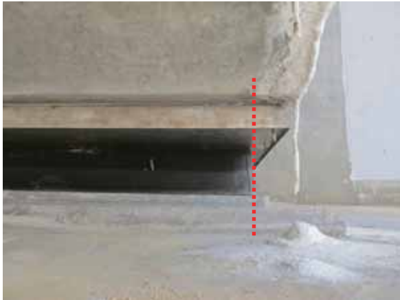
写真-4. 4. 29. 6 A1 橋台すべりゴム支承の 状況
