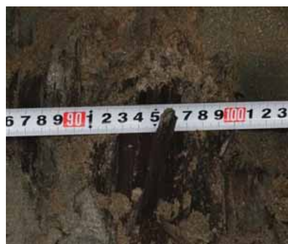
(d) 木杭の杭径(約 10cm)
