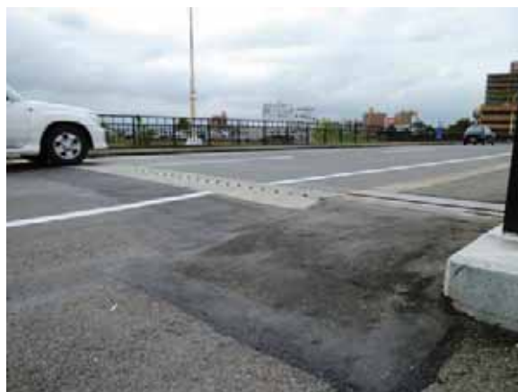
写真-4.3.15.3 橋台背面段差の修復状況 (A2 側)
