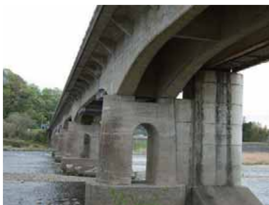
写真-4.6.1.1 新那珂橋(渡河部)
