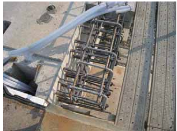
写真-4.1.17.10 地覆鉄筋
