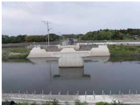
写真-4. 4. 10. 5 左岸側橋台部
