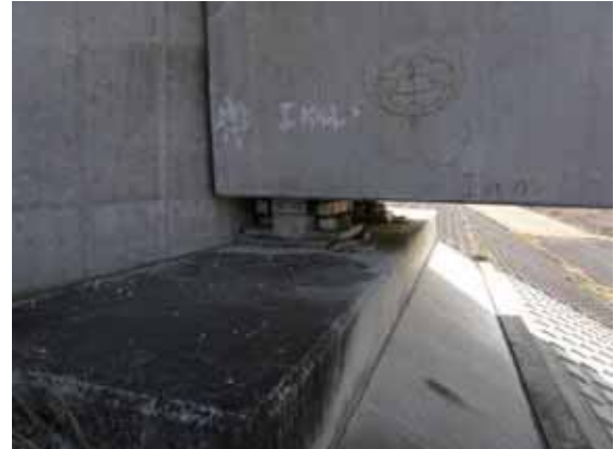
写真-4.4.3.9 A2 橋台側桁端部：ひび割れ確認されず
