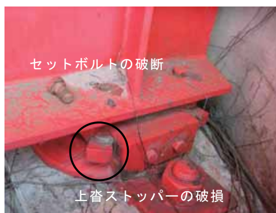
写真-4.3.1.3 南側橋台部の固定支承
