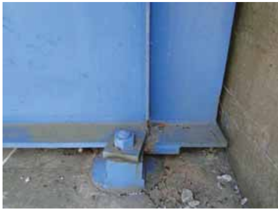
写真-4.4.9.5 支承部(右岸側橋台)
