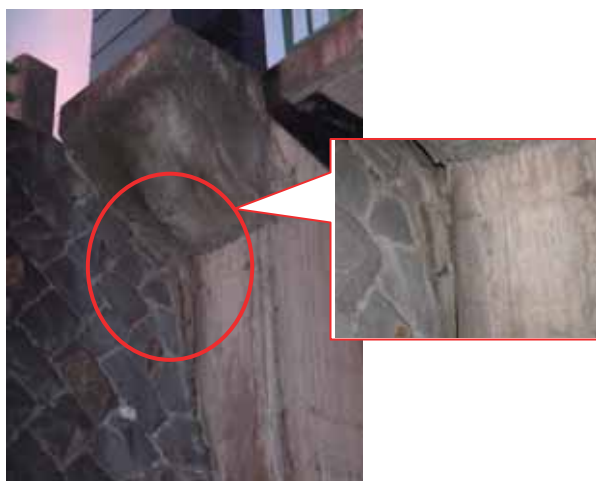
写真-4. 3. 17. 11 橋台躯体部と背面擁壁の隙間 (A2 橋台)
