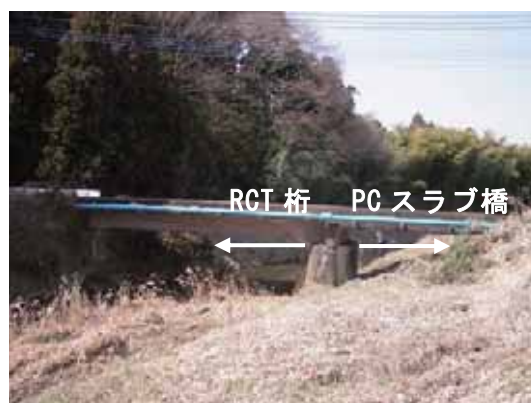
写真-4.4.4.1 鷹匠橋(下流側より、手前は水道管)
