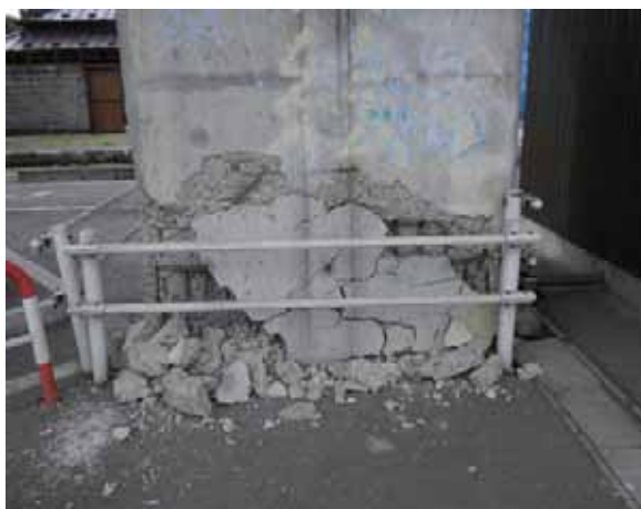
写真-4.2.19.3 4月7日の余震後のP2橋脚の損傷(資料提供:宮城県)
