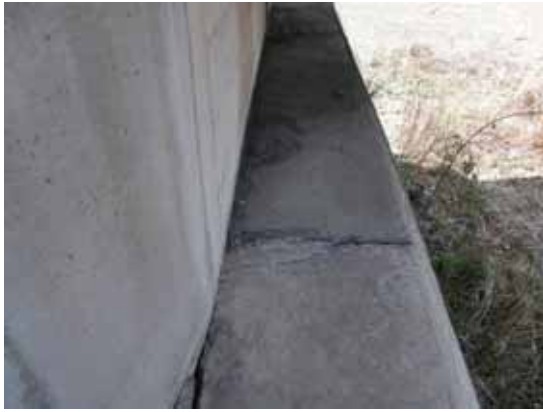
写真-4.4.6.2 A1 橋台橋座部
