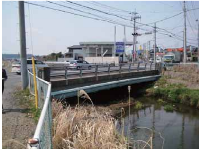
写真-4.4.18.1 境橋(東南側より)
