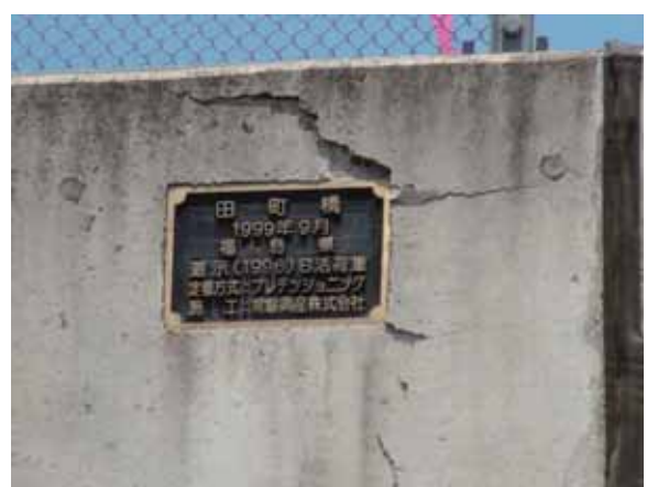
写真-4.3.13.7 防護壁コンクリートの損傷(福島空港 IC 側橋台上り線側)
