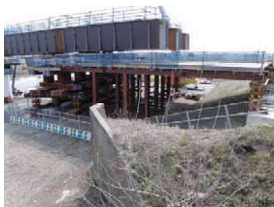
写真-4. 4. 26. 5 新橋の架設状況
