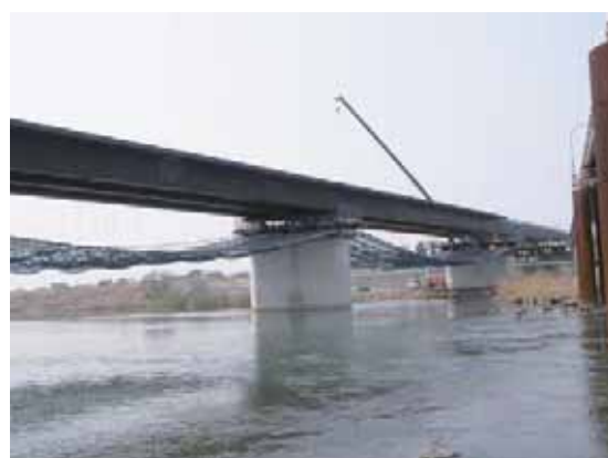
写真-4. 4. 26. 4 下流側に建設中の新橋
