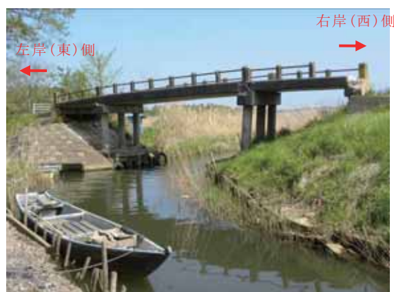
写真-4.4.14.1 東水神橋(上流側より)
