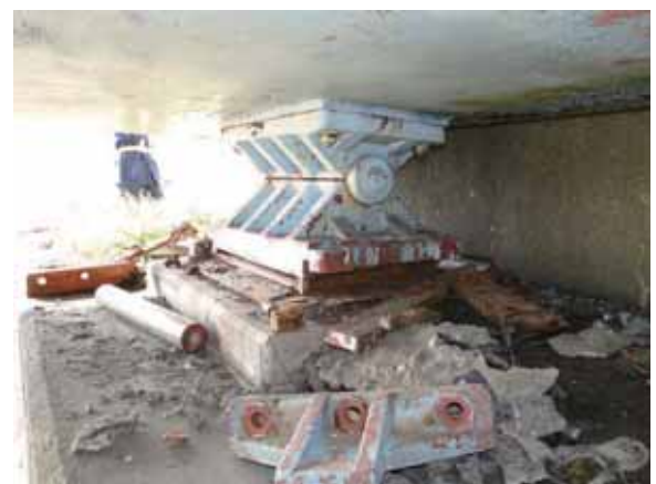
(b) 下流側の桁を支持する支承
