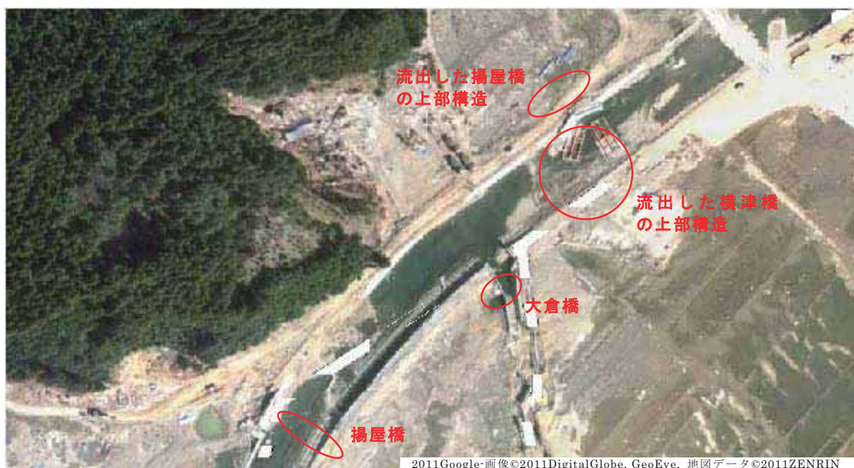
写真-4.2.4.1 橋梁の流出状況
