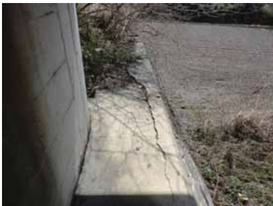
写真-4.4.6.4 A1 橋台前面のブロック 積天端
