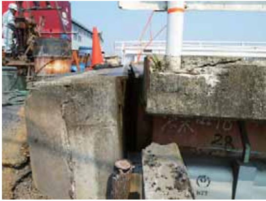
写真-4. 4. 23. 4 桁端部の状況(右岸側)
