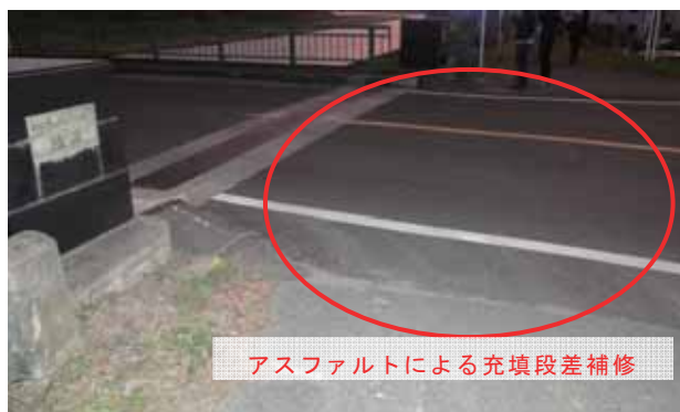
写真-4. 3. 17. 12 橋台背面アプローチ部の沈下の痕跡 (A2 橋台)
