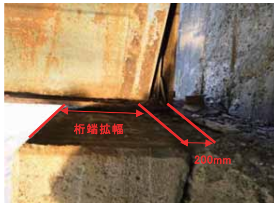
写真-4. 2. 11. 26 桁かかり状況 (写真-4. 2. 11. 25 の拡大)
