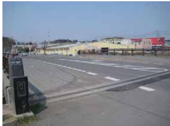
写真-4.4.19.3 段差補正後の様子 (左岸側橋台部)
