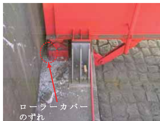
写真-4.5.1.5 A1 橋台支承部
