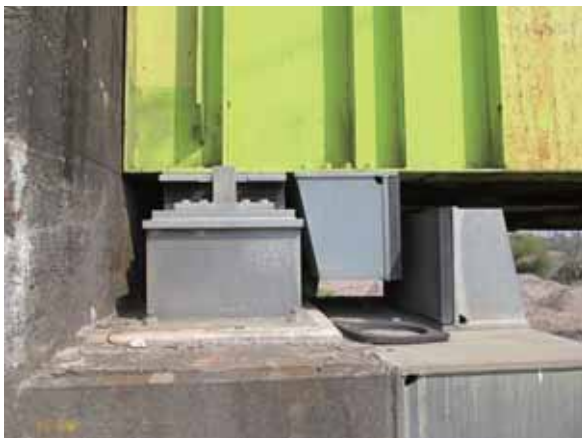
写真-4.4.28.4 A2 橋台支承部側面の状況
