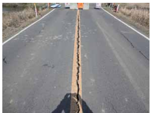
写真-4.4.5.27 A2 橋台アプローチ部の 状況
