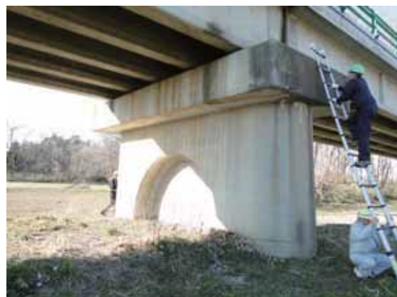
写真-4.1.13.5 P3 橋脚躯体
