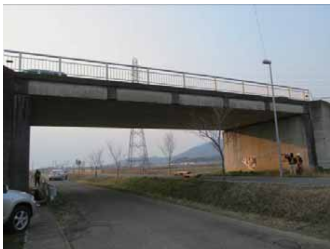
写真-4.4.25.1 田土部陸橋
