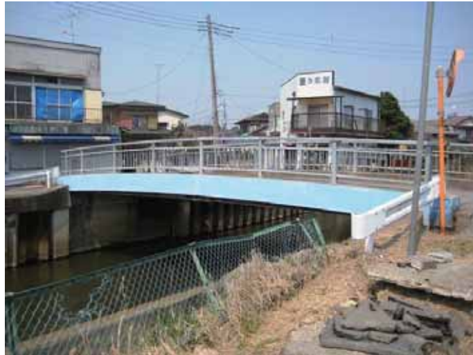
写真-4.4.21.1 蓬莱橋(左岸側より)
