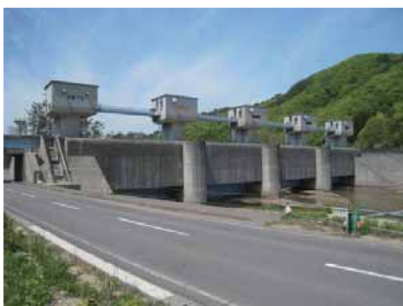
写真-4. 1. 19. 13 水門の状況 (下流右岸側より)
