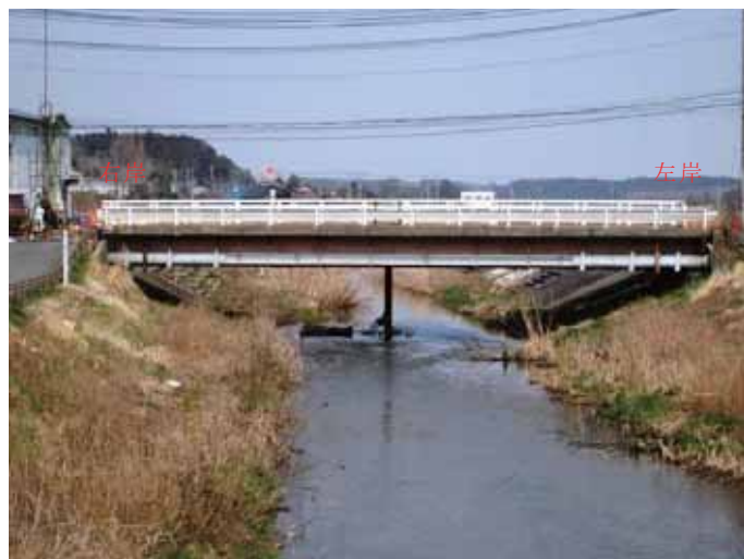
写真-4.4.23.1 富士橋(下流側より)
