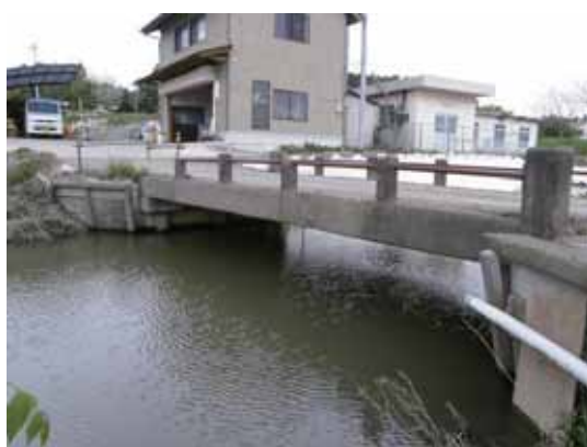
写真-4. 4. 14. 25 単径間コンクリート橋(東 水神橋から約 100m 離れた地点)
