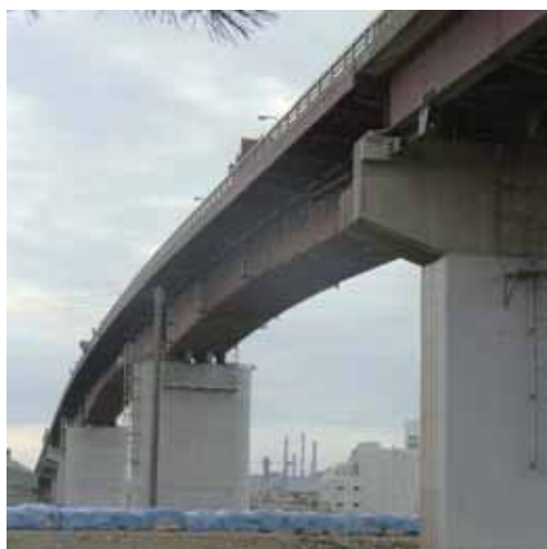
写真-4.2.7.1 日和大橋(渡河部)
