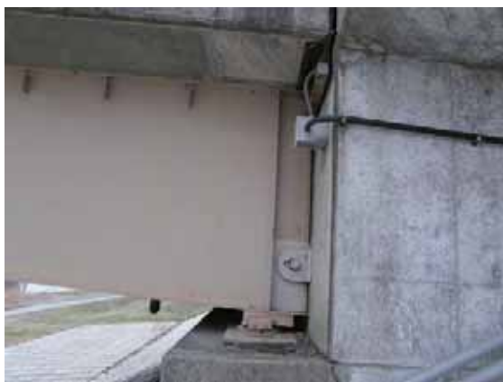
写真-4.2.13.8 A1 橋台側桁端部
