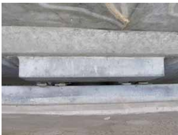
写真-4.4.29.5 A1 橋台直角方向固定装置
