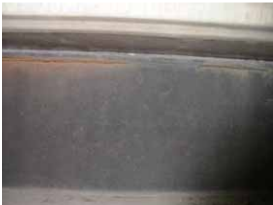
写真-4.4.6.6 ゴム支承背面の状況
