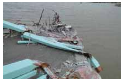
写真-4.2.6.6 左岸側橋台背面盛土の流出状況(橋面より)
