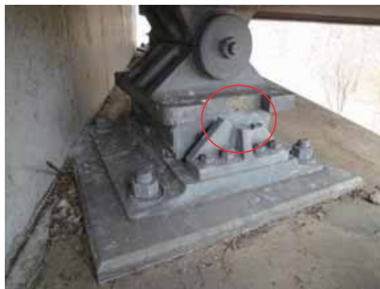
写真-4.1.7.3 A2 橋台上流側(鈍角側)の鋼製支承
