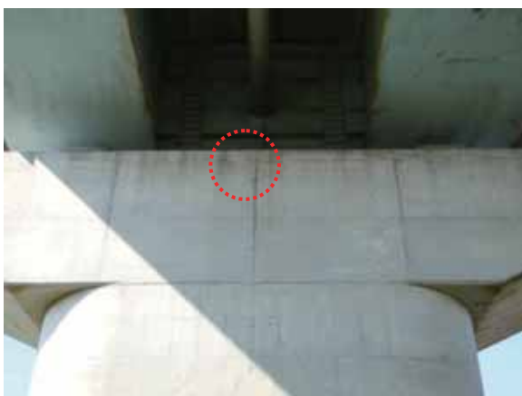
写真-4.4.7.14 P5 橋脚の横梁部中央の縦方向ひび割れ
