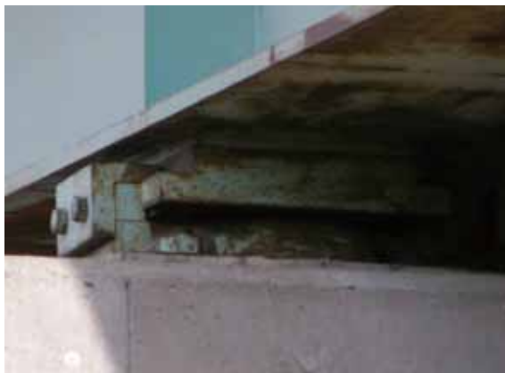
写真-4. 2. 10. 16 P1 橋脚 G1 桁支承
