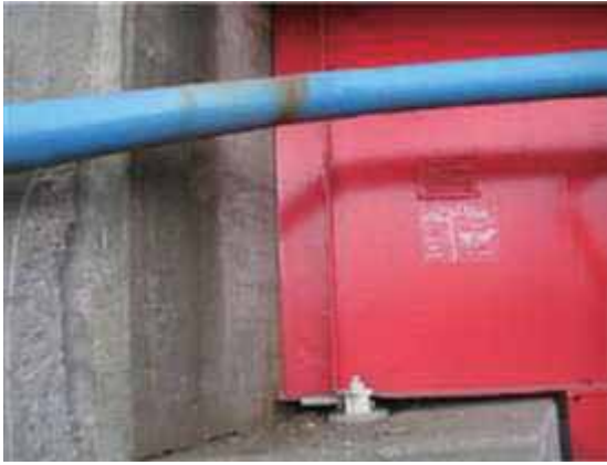
写真-4.2.16.2 A1 橋台部 G3 主桁遊間異常 (0mm) (資料提供：宮城県)
