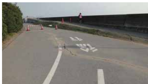
(c) 左岸側橋台付近の地盤の状況
