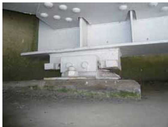
写真-4.4.30.7 支承の状況 (A1 橋台)
