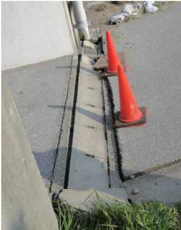
(c) 橋台周辺地盤の沈下により生じた、橋台側面の段差((a)のコーン設置位置)
