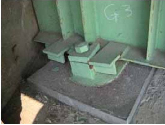
写真-4.4.17.9 右岸側橋台下流側支承部
