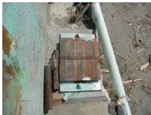
写真-4.1.2.4 右岸側橋台支承の状況
