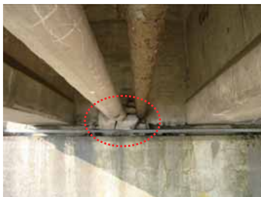
写真-4.4.32.8 橋台端横桁(潮来市側)
