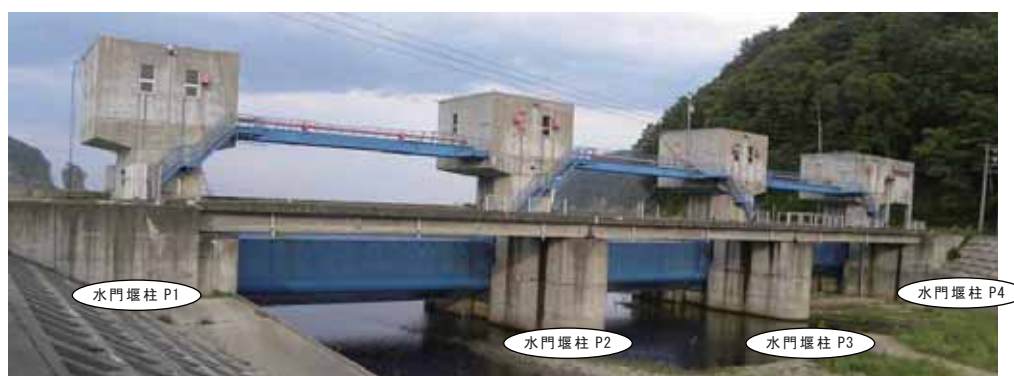
写真-4.1.20.1 田代川水門管理橋
