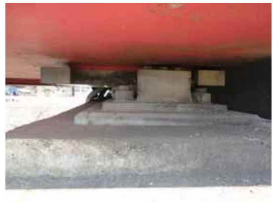
写真-4.4.6.7 ゴム支承側面の状況
