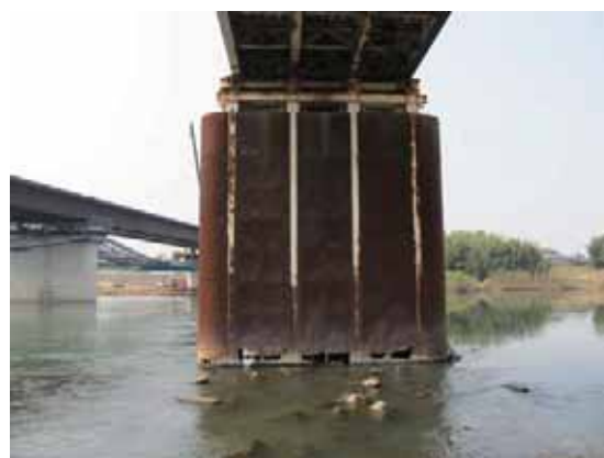
写真-4. 4. 26. 2 中央径間付近の鋼製橋脚
