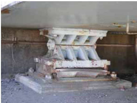
(a) 上流側の桁を支持する支承
