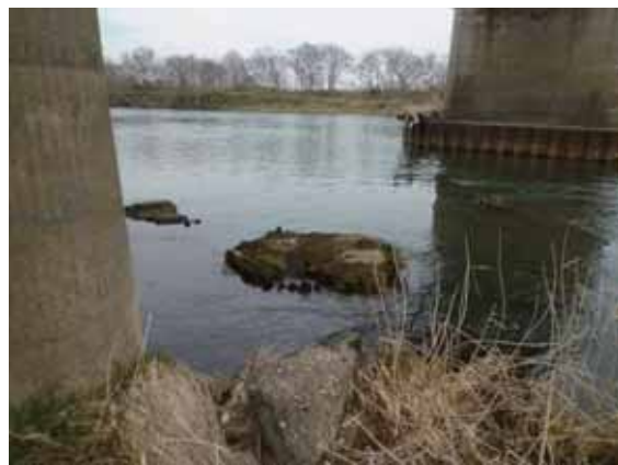
写真-4.1.8.7 旧橋基礎の跡
