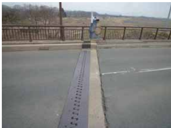
写真-4.1.7.2 A2 橋台上の路面状況
