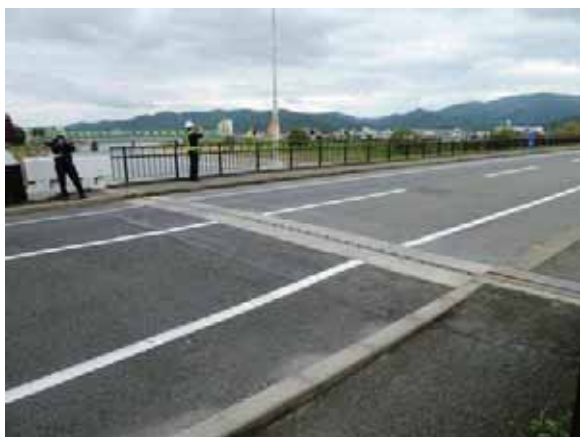
写真-4.3.15.2 橋台背面段差の修復状況 (A1 側)
