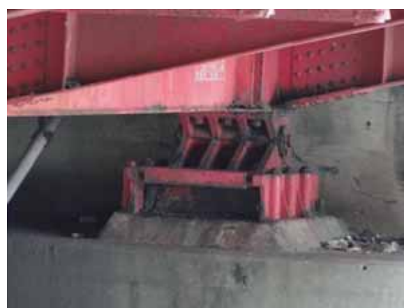
写真-4.5.8.6 支承部の状況
