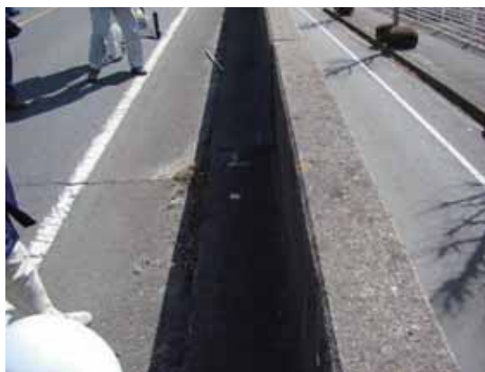
写真-4.4.1.2 取付盛土部擁壁の変状
