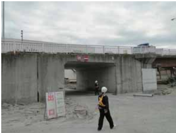
写真-4.2.7.5 左岸側橋台と橋台背面のカルバートの状況(上流側より)
