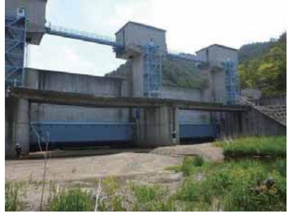
写真-4.1.19.2 落橋を免れた2径間(上流 側より)
