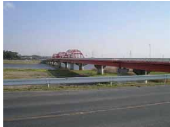
写真-4.5.1.2 神崎大橋側道橋 (左岸(稲敷市)側より)
