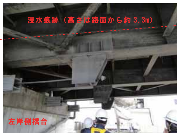
写真-4.2.7.4 左岸側橋台周辺の状況
