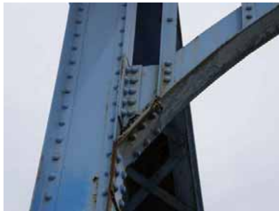
写真-4.1.8.8 ランガートラス接合部の状況
