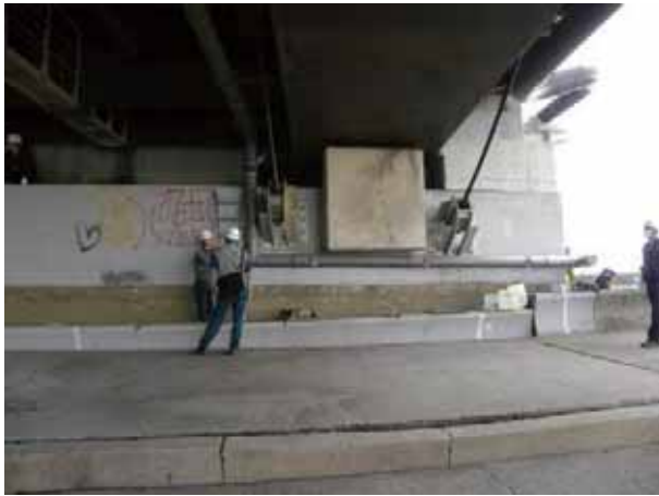
(e) 橋台壁および前面護岸の状況
