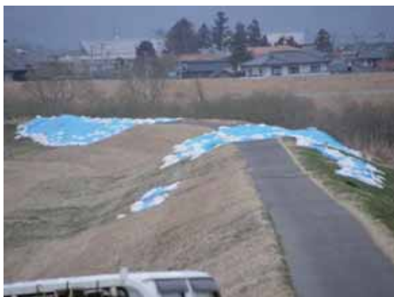
写真-4. 2. 13. 2 右岸側 (A1) 堤体の状況
