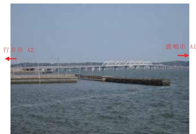
写真-4.4.30.1 北浦大橋(行方市側より)
