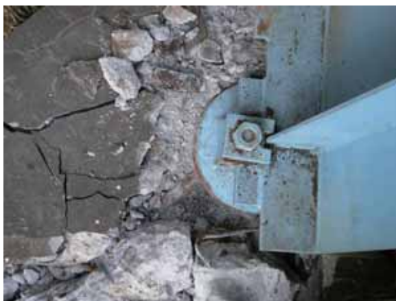
写真-4.4.5.4 上流側支承部の状況 (上面より)
