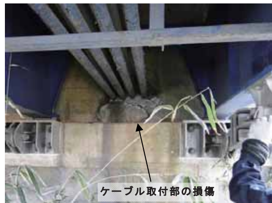
写真-4.4.9.8 配管ケーブル取付部(右岸橋台)
