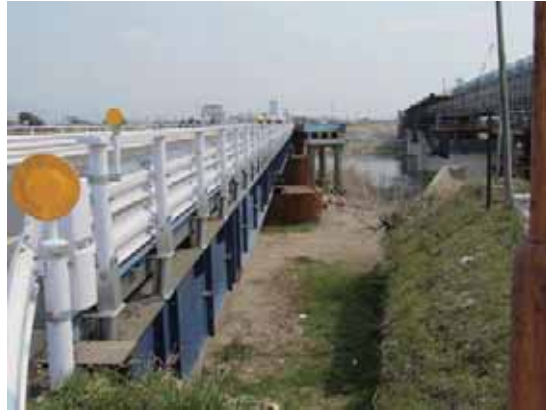
写真-4. 4. 26. 7 撤去部分に接続する仮設橋
