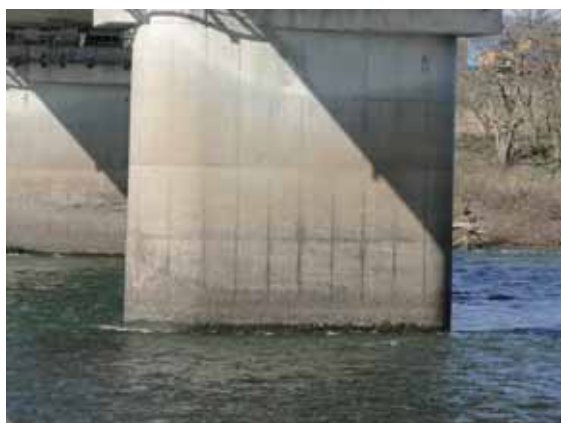
写真 4. 1. 12. 8 低水域の橋脚の状況
