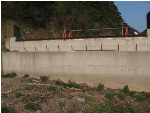
写真-4. 1. 18. 3 A1 橋台のアンカーバー の状態
