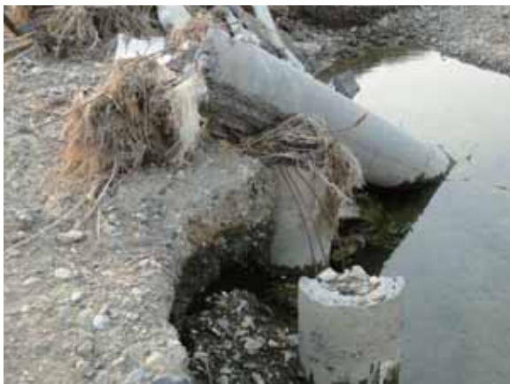
写真-4.2.1.3 パイルベント橋脚の損傷状況
