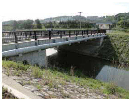
写真-4.2.15.1 南沢川橋
