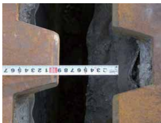
写真-4.2.11.30 橋軸方向遊間 (写真-4.2.11.28 の拡大)
