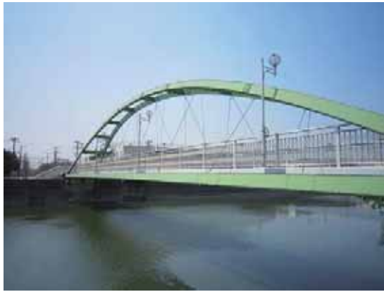
写真-4.5.9.1 境川中央歩道橋
