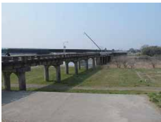
写真-4. 4. 26. 1 石下橋(左岸側より)
