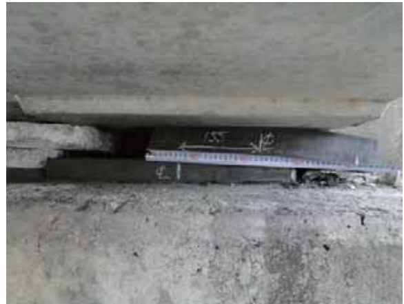
(b) ゴム支承の側方への移動(155mm) (G4 主桁)
