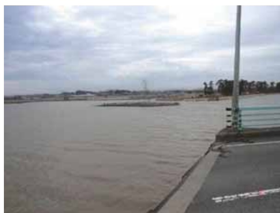
写真-4.2.6.3 流出した上部構造の遠景
