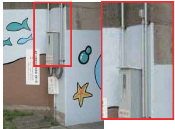
(m) 上流側の橋台と擁壁の接合部
