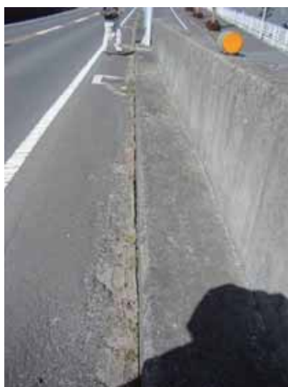
写真-4.4.1.2 取付盛土部擁壁の変状
