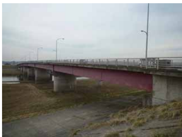
写真-4.2.12.1 野田橋(左岸 A2 側より)
