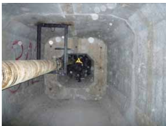
写真-4. 1. 11. 8 桁内部の状況
