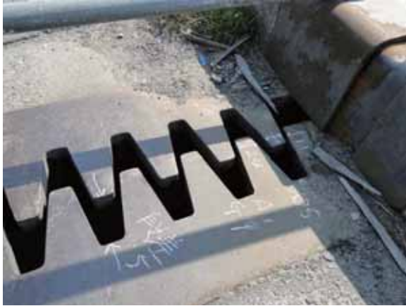
写真-4.4.7.2 A1 橋台上の伸縮装置の状況
