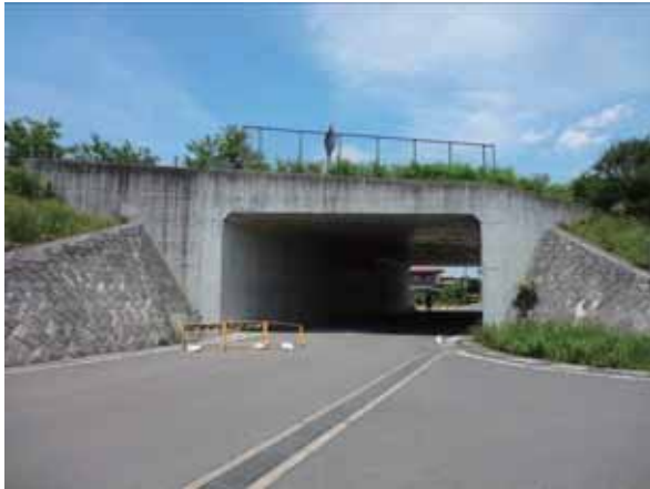
写真-4.3.13.8 矢吹 IC 側にある カルバート
