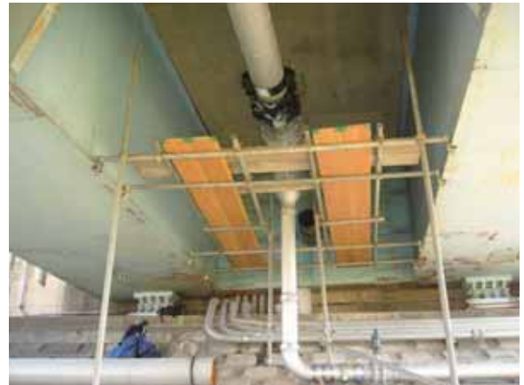
写真-4.4.7.4 A1 橋台の状況
