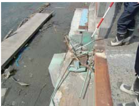
写真-4.1.2.4 右岸側橋台支承の状況
