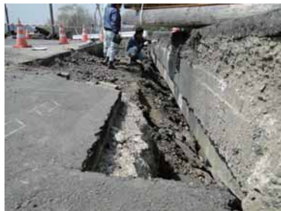
写真-4.4.8.2 橋台背面の沈下
