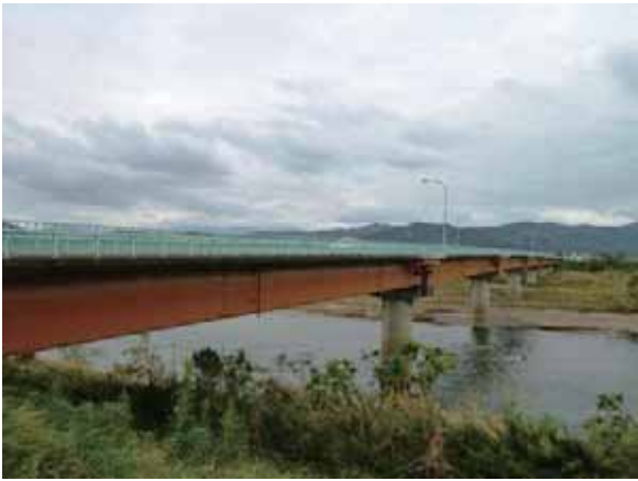
(a) A1 上流側より
