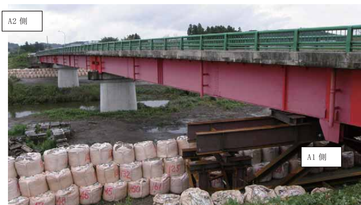
写真-4.2.16.1 西川橋(平成 24 年 10 月撮影)
