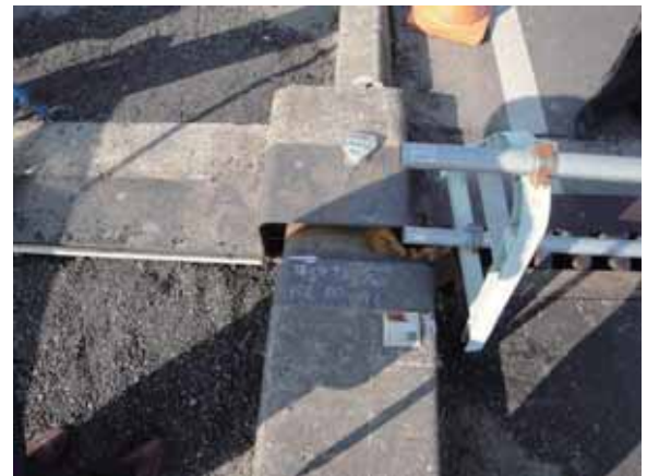
写真-4.4.7.16 A2 橋台上の伸縮装置の状況
