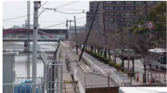
写真-4.5.9.10 右岸全景(今川橋～境川中 央歩道橋間)
