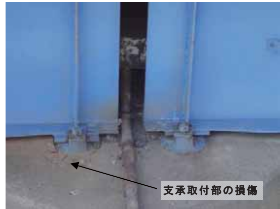
写真-4.4.9.6 橋脚上の支承取付部
