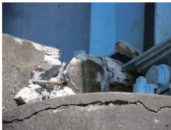
写真-4.4.5.5 上流側支承部の状況 (側面より)
