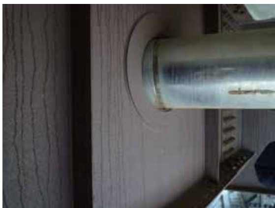
写真-4.1.7.6 A2 橋台上単横桁部の添架管
