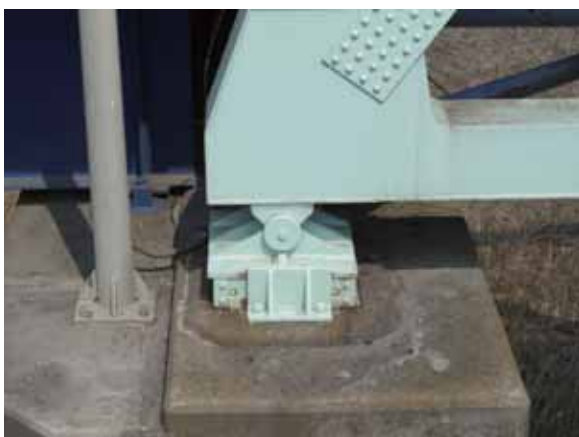
写真-4.4.13.12 左岸側より3脚目の支承
