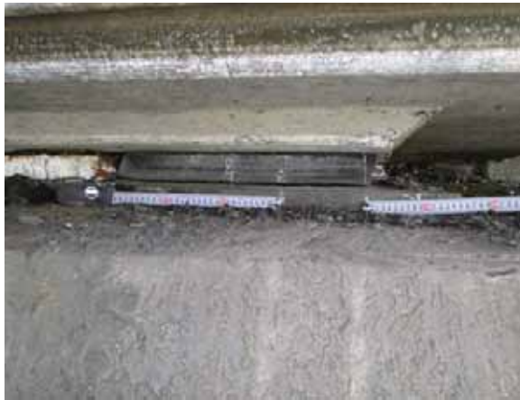
(a) ゴム支承の側方への移動(90mm)
