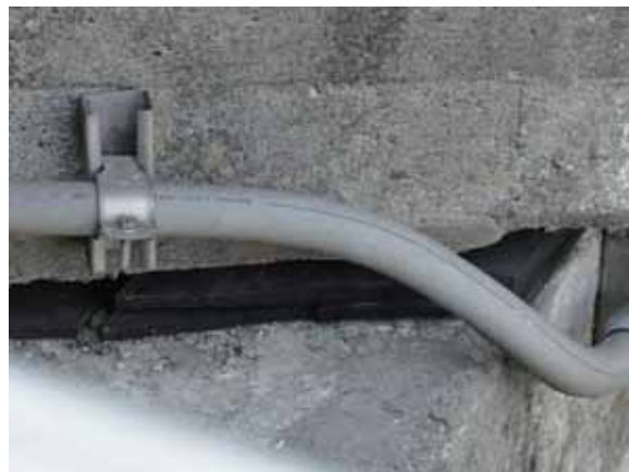
写真-4.5.10.3 支承部(右岸側)
