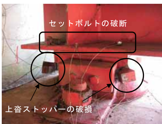
写真-4.3.1.2 南側橋台部の固定支承
