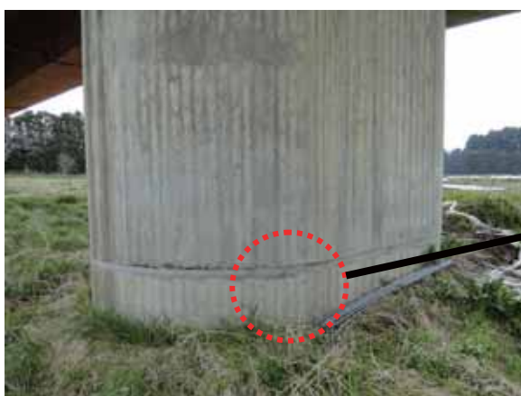
写真-4.1.14.4 江刺側から2基目の橋脚の損傷
