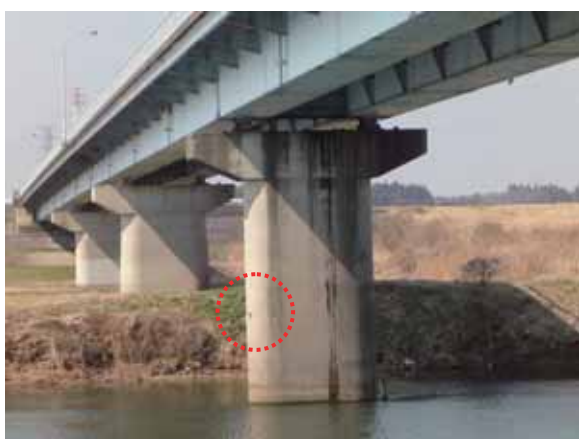
(a) P2 橋脚側より撮影
