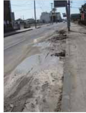
写真-4.3.8.22 東側橋台部近隣の状況
