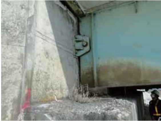
写真-4.2.10.18 A2 橋台の状況
