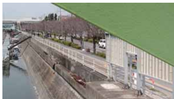
写真-4.5.9.6 左岸全景(境川中央歩道橋～境川橋間)
