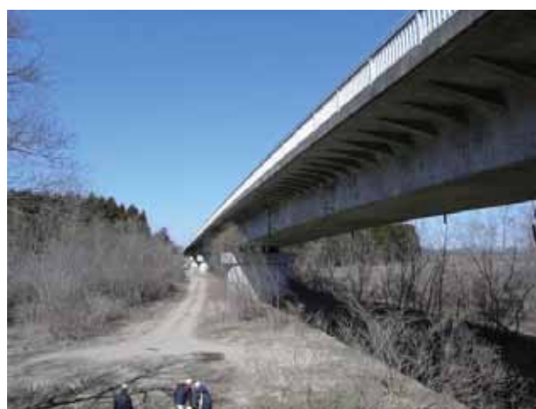
写真-4.1.12.1 江崎大橋
