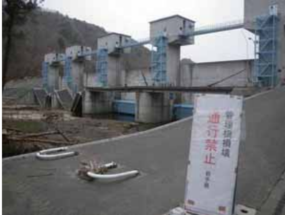
写真-4.1.19.1 普代水門管理橋(上流 右岸側より)
