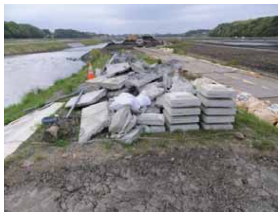
写真-4. 4. 10. 7 撤去された護岸ブロック
