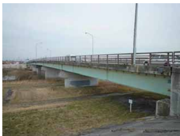
写真-4.2.10.1 江合橋(右岸 A1 側より)
