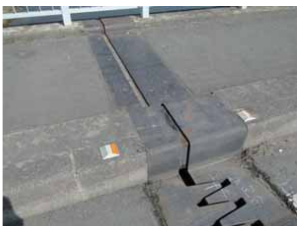
写真-4.4.7.7 P3 橋脚上の伸縮装置の状況
