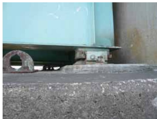
写真-4.5.11.5 稲敷市側橋台部の支承
