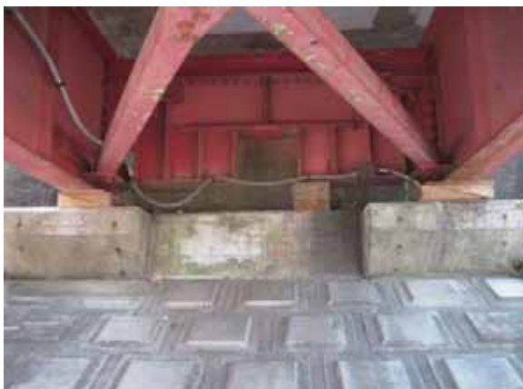
写真-4.2.18.14 A2 橋台の状況 (資料提供：仙台市)
