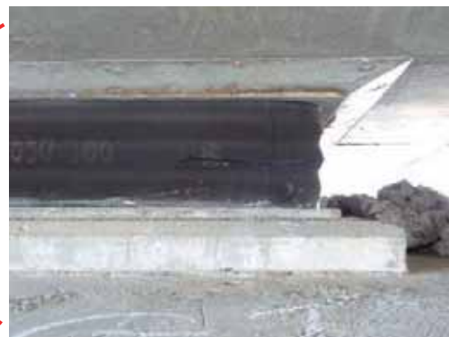
写真-4.3.14.14 P5橋脚上のゴム支承の亀裂(写真提供：福島県)
