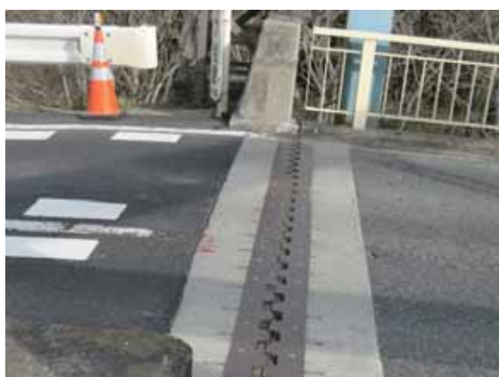
写真-4.1.16.2 右岸側取付け部：橋台背面の段差は補修済
