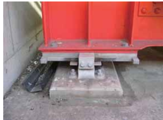
写真-4.5.1.24 側道橋 A2 橋台支承部
