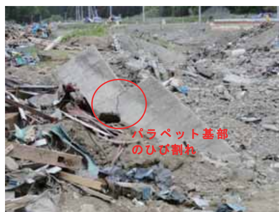
写真-4.2.3.5 下流側から見た右岸側橋台
