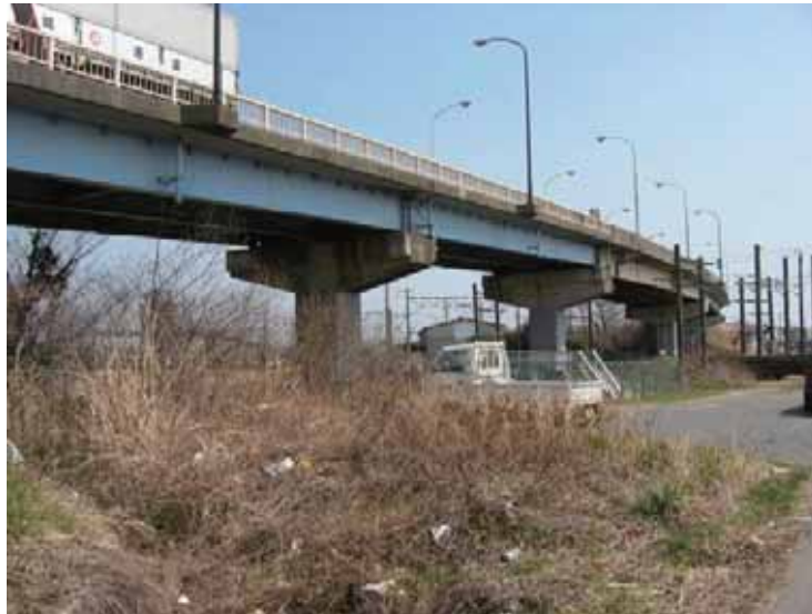
写真-4.3.7.1 泉跨線橋(グレーの桁が跨線部)
