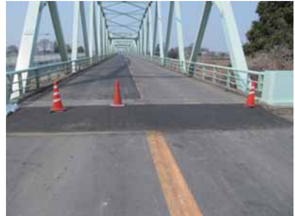
写真-4. 4. 13. 3 左岸側橋台段差の補修状況
