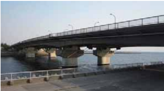
(a) 上流・右岸側(A2 橋台側)より
