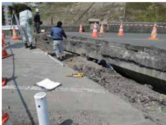
写真-4.4.8.2 橋台背面の沈下
