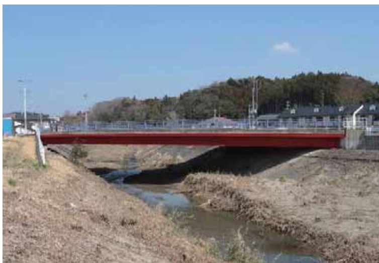
写真-4.3.9.1 渋川橋(南側より)
