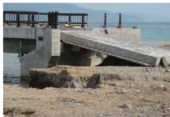
(b) 踏掛版の状況(右岸側)
