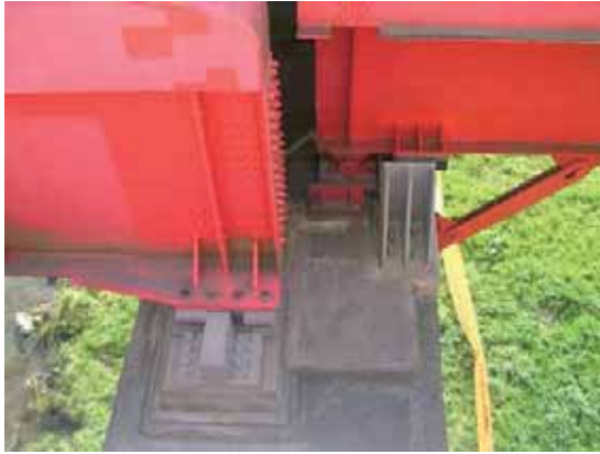
写真-4.5.1.8 P6 橋脚支承部の状況 (下流側より)
