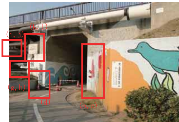
(a) A1橋台全景(河口側より撮影)
