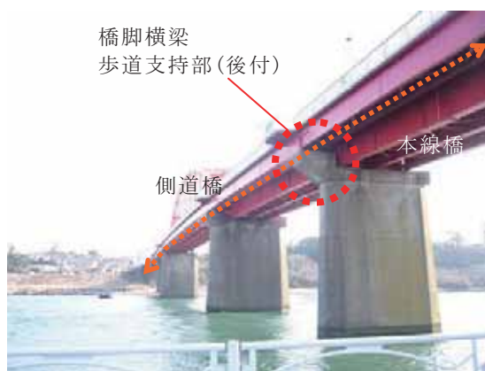
写真-4.4.12.1 海門橋側道橋(渡河部)
