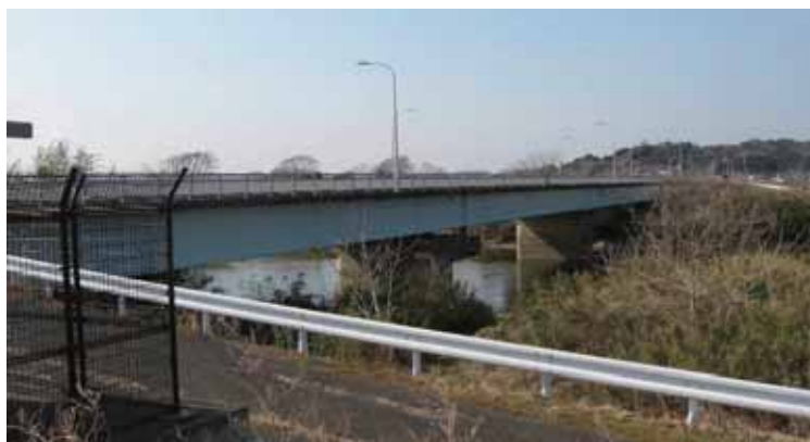
写真-4.3.10.1 江栗大橋(左岸上流側より)
