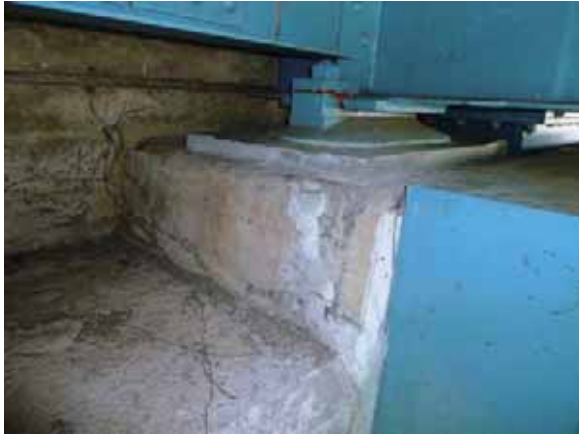
写真-4.3.15.6 沓座コンクリートの修復状況 (A1 橋台)
