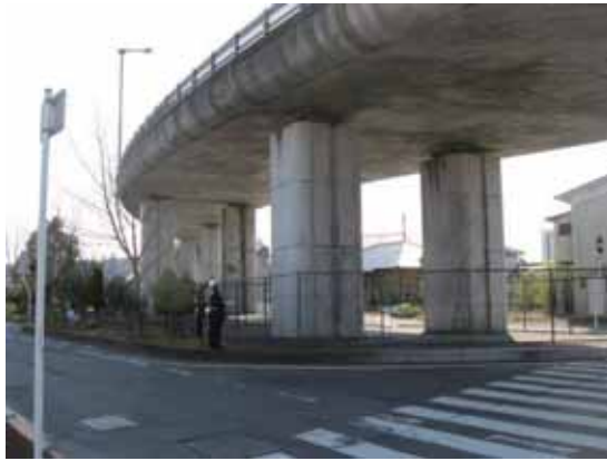
写真-4.3.8.2 西側取付部
