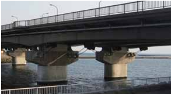
(b) 拡大写真(橋脚)
