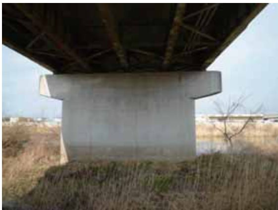
写真-4. 2. 10. 14 P2 橋脚 (A1 側から撮影)
