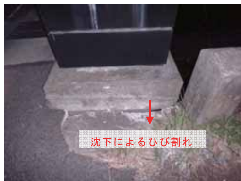
写真-4. 3. 17. 12 橋台背面アプローチ部の沈下の痕跡 (A2 橋台)
