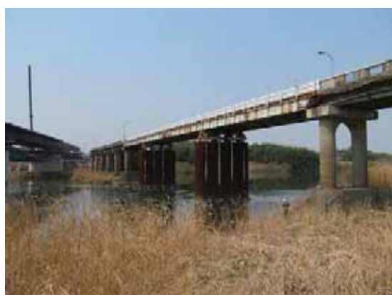
写真-4. 4. 26. 3 中央径間付近鋼鈹桁部
