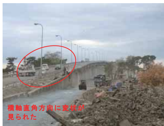
写真-4.2.7.2 日和大橋(左岸側)
