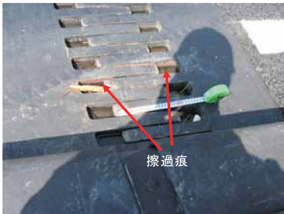
写真-4.3.11.2 フィンガージョイントの擦過痕
