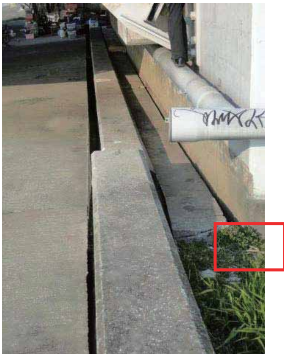
(g) 橋台前面・側面と周辺地盤の間に生じた隙間
