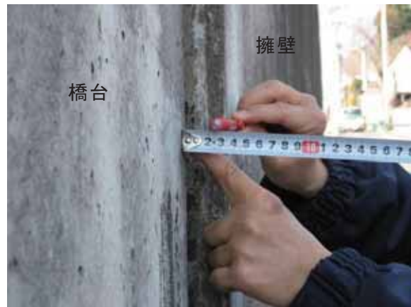
写真-4. 3. 8. 18 西側橋台と擁壁の相対変位
