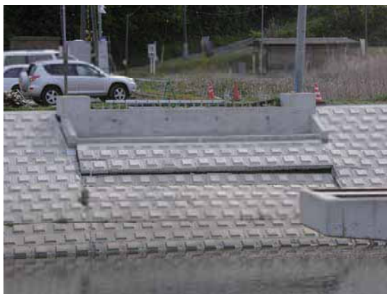
写真-4. 4. 10. 2 右岸側橋台部
