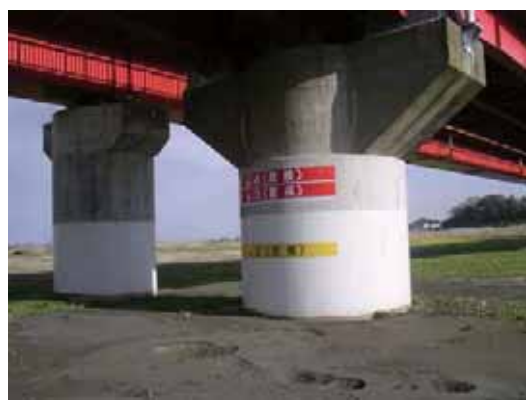
写真-4.5.1.14 P8 橋脚基部の状況
