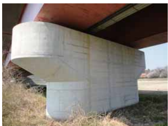
写真-4.4.6.18 P4 橋脚の状況：躯体に特段の損傷なし
