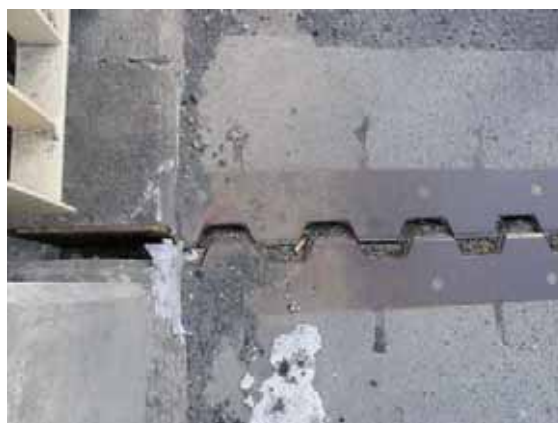
写真-4.1.16.4 伸縮装置の水平ずれ(約 2cm)
