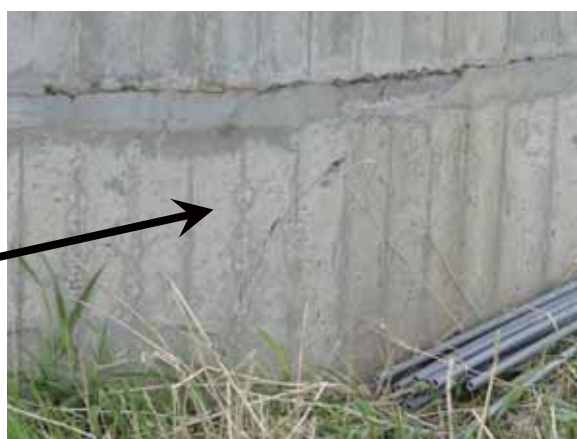
写真-4.1.14.4 江刺側から2基目の橋脚の損傷
