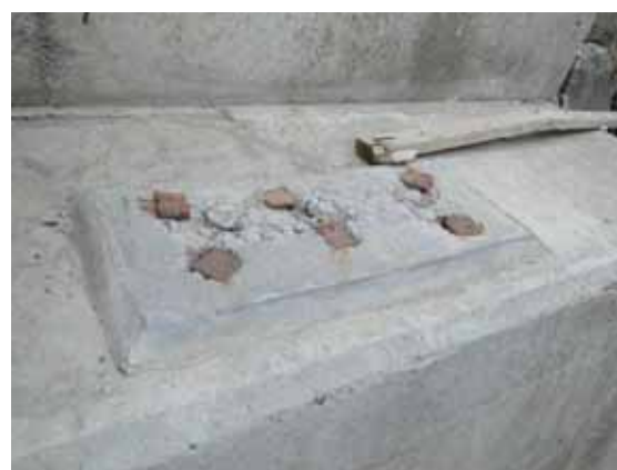
写真-4.2.3.7 左岸側橋台の沓座
