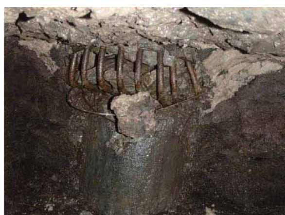
(b) A1 橋台上流側
