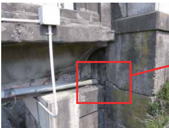
写真-4. 4. 26. 8 左岸側橋台側面の状況
