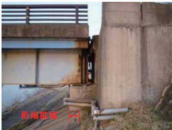
写真-4. 2. 11. 23 A2 橋台(左岸側)の状況
