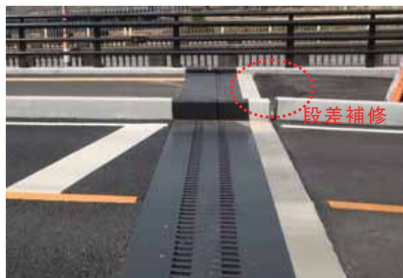
写真-4. 3. 11. 7 左岸側橋台背面の段差修復状況
