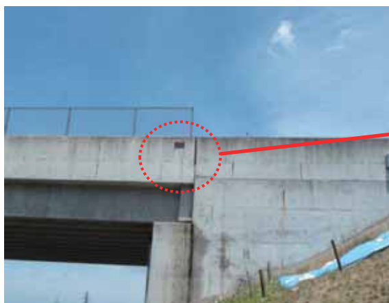
写真-4.3.13.7 防護壁コンクリートの損傷(福島空港 IC 側橋台上り線側)
