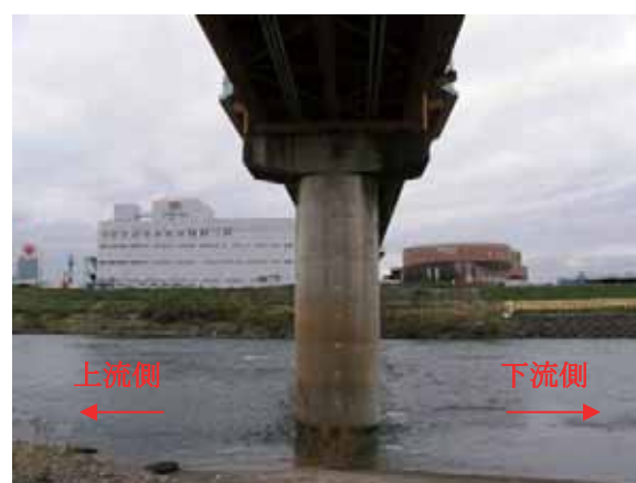
写真-4. 3. 16. 4 P2 橋脚の状況 (A2 側より)
