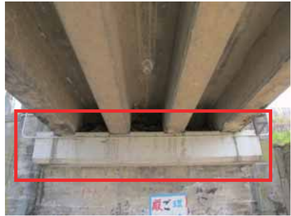
写真-4.4.26.11 左岸側橋台の縁端拡幅部
