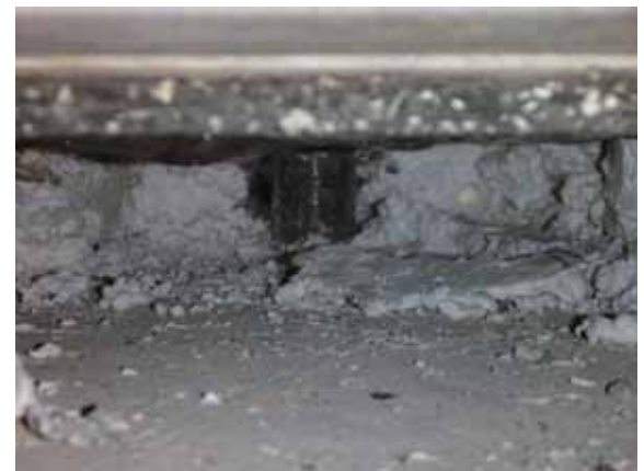
(b) アンカーバーの状況 (変形なし)
