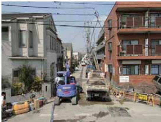
写真-4.5.7.6 電柱の傾斜
