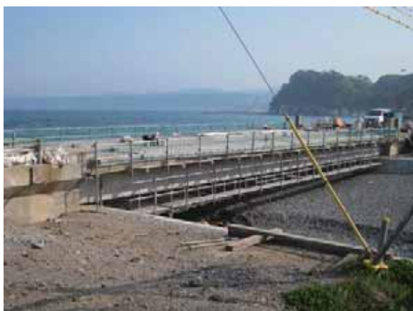
写真-4.1.17.5 復旧工事の状況
