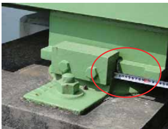
写真-4.5.9.3 可動支承(左岸側)
