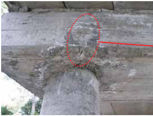
写真-4. 4. 14. 10 左岸側橋脚梁部のひび割れ
