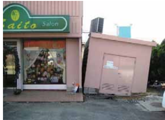
写真-4. 4. 23. 7 右岸側橋台周辺の状況
