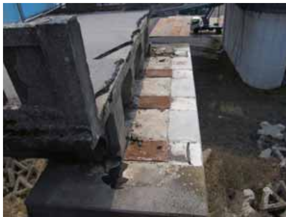
写真-4.4.26.12 桁断面と橋座面
