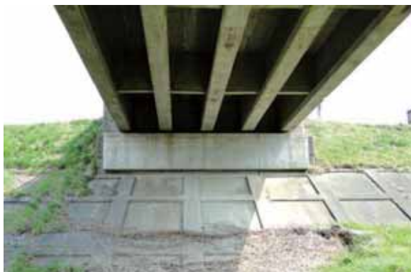
写真-4.1.15.2 左岸側の橋台上の横桁のかぶりコンクリートの剥落
