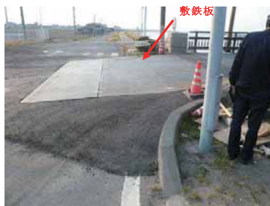
写真-4.4.32.4 橋台周辺の状況 (潮来市側)
