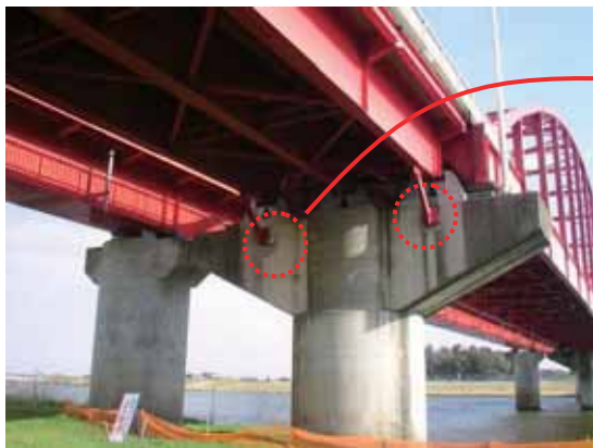
写真-4.5.1.10 P6 橋脚の落橋防止構造の損傷
