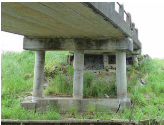
写真-4. 4. 14. 11 右岸側橋脚
