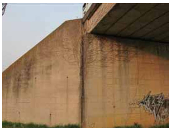
写真-4.4.25.2 左岸側橋台と擁壁の状況
