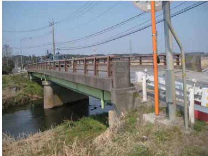
写真-4.4.17.1 鹿行橋(銚田市側より)
