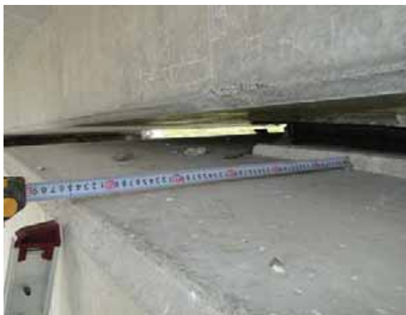
(a) ゴム支承の状況(異常なし、G4 主桁)
