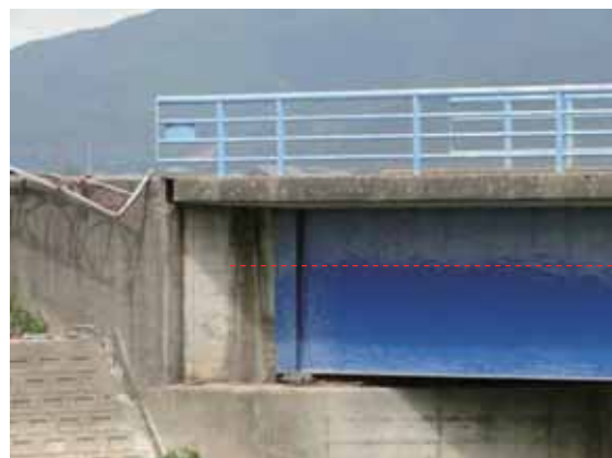
写真-4.2.5.4 左岸側橋台付近の主桁側面 (上流側より)
