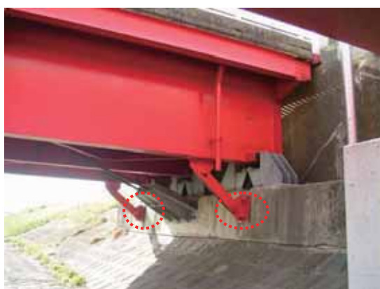
写真-4.5.1.15 A2 橋台部の状況
