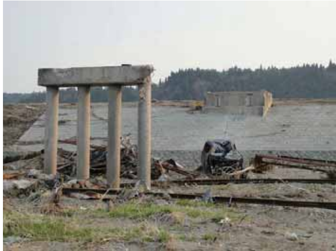
写真-4.2.1.2 右岸側の橋台とその隣の橋脚の状況
