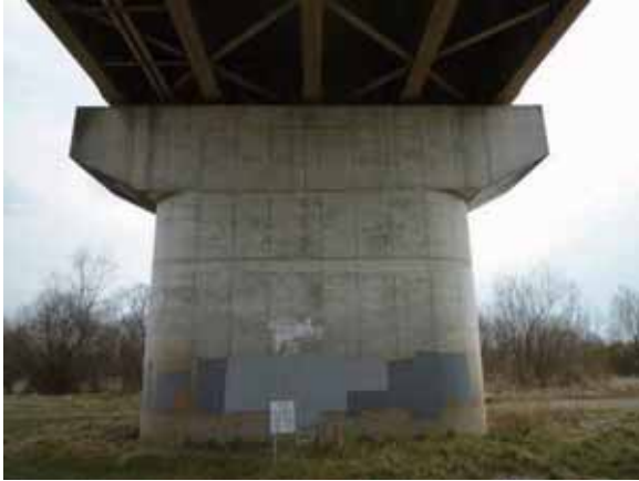
写真-4. 2. 13. 26 P1 橋脚
