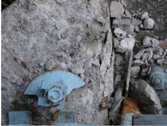
写真-4.4.5.6 下流側支承部の状況 (上面より)
