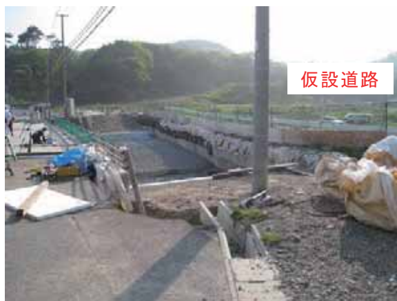
写真-4.1.17.6 盛土構築による応急的な 通行機能の確保
