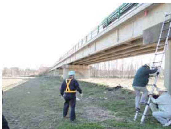
写真-4.1.13.1 金ヶ崎橋
