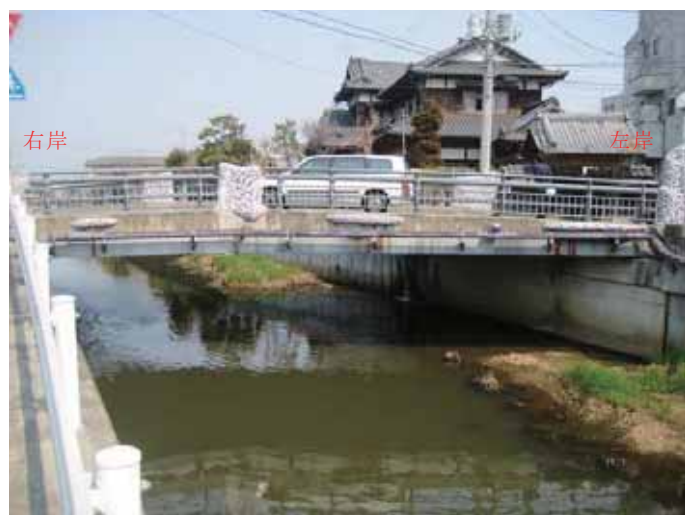
写真-4.4.22.1 鉾田橋(下流側より)
