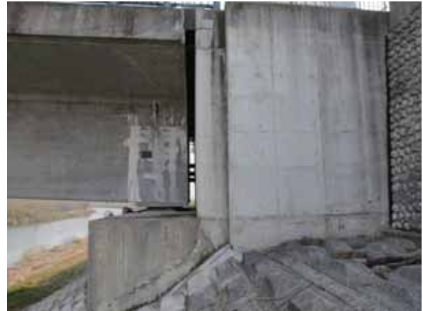
写真-4. 4. 29. 7 A1 橋台上桁端部の状況
