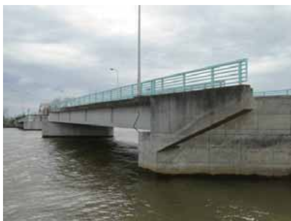
写真-4.2.6.2 定川大橋
