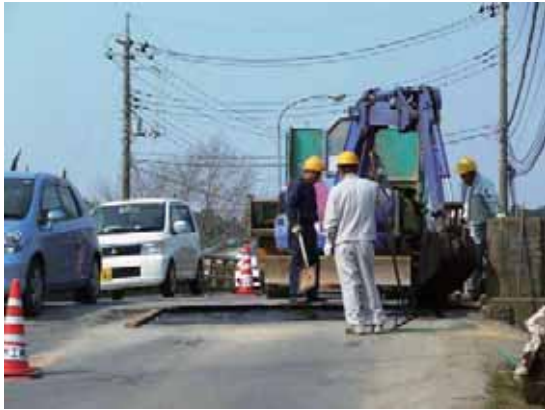
写真-4.4.17.3 段差復旧工事の様子
