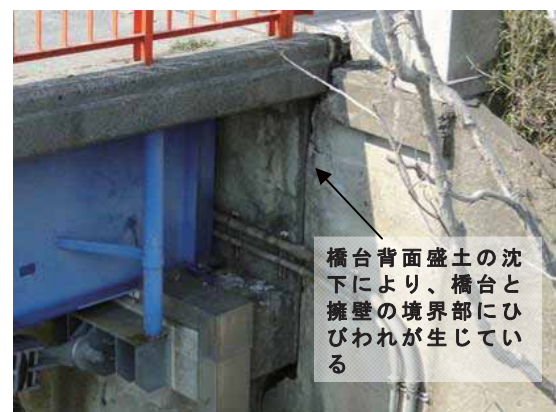
写真-4.4.9.4 橋台(左岸側)
