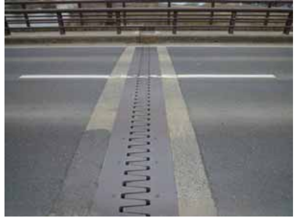
写真-4. 2. 13. 27 P3 かけ違い部伸縮装置
