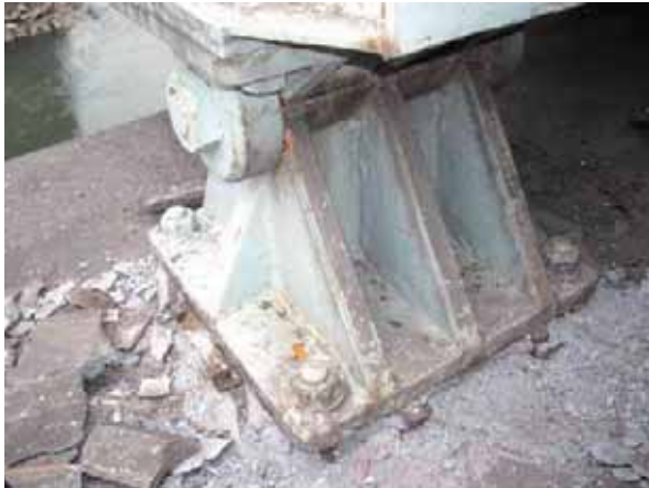
(a) P10 固定支承、コンクリートの剥離 (b) P10 可動支承、カバースプレートの破損 写真-4. 4. 15. 3 トラス部の支承 (P10橋脚上の可動支承はP9橋脚側に配置されている)
