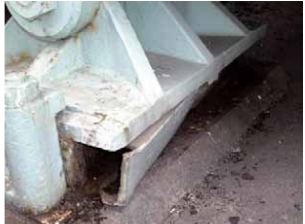
(a) P10 固定支承、コンクリートの剥離 (b) P10 可動支承、カバースプレートの破損 写真-4. 4. 15. 3 トラス部の支承 (P10橋脚上の可動支承はP9橋脚側に配置されている)
