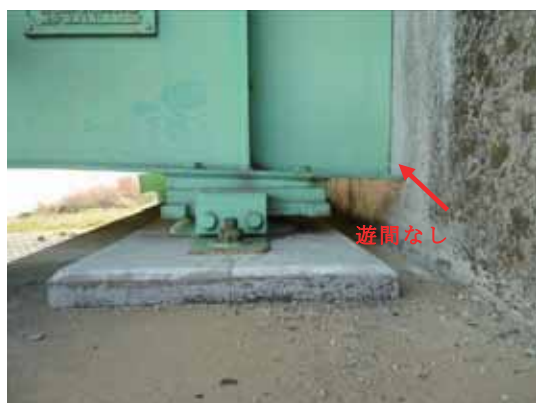
写真-4.4.32.12 側道橋橋台支承部 の状況(潮来市側)
