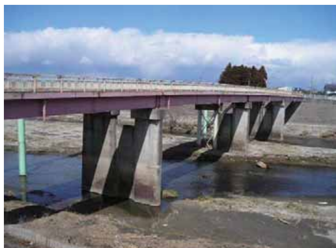
写真-4.2.18.1 田子大橋(奥が道路橋、手前は側道橋)(資料提供 : 仙台市)
