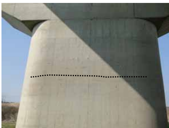
(c) P3 橋脚側の面
