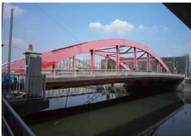
写真-4.5.8.1 今川橋(下流側より)
