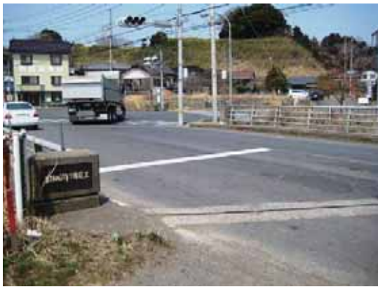
写真-4.4.18.2 橋梁の状況(東南側より)
