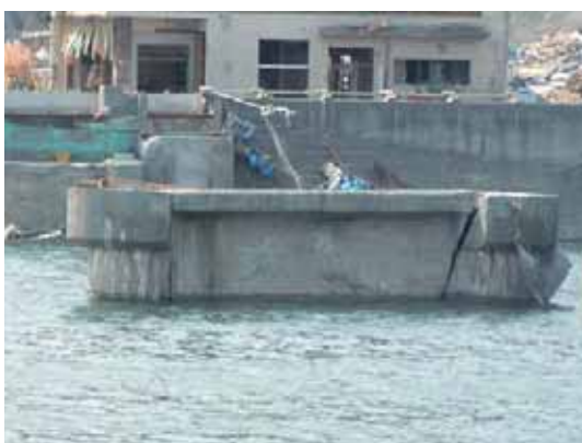
写真-4.1.2.3 下部構造のひび割れ
