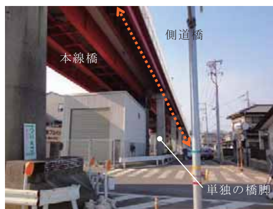
写真-4.4.12.2 海門橋側道橋(左岸側 陸上部)
