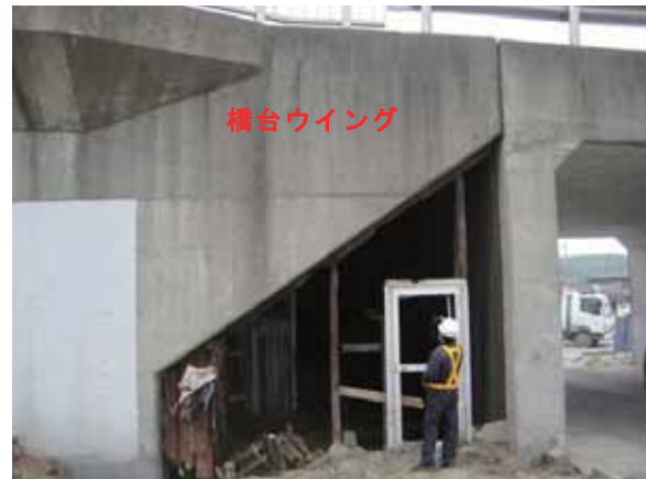
写真-4.2.7.6 左岸側橋台と橋台背面のカルバートの状況(下流側より)
