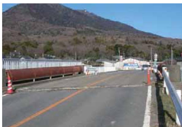
写真-4.4.16.2 橋面の状況
