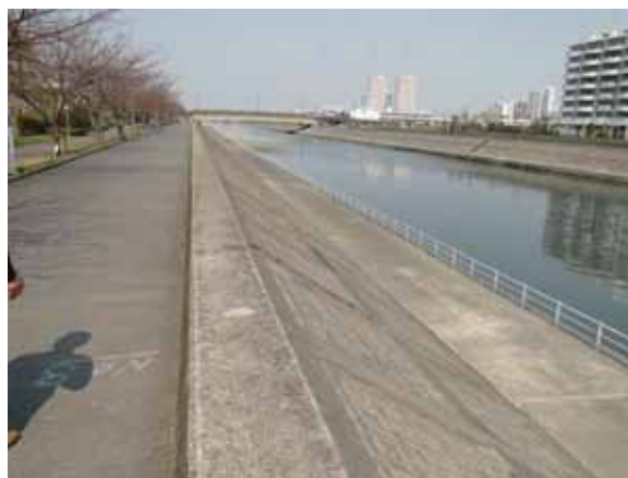
写真-4.5.5.5 明海橋～高洲橋間の護岸の状況
