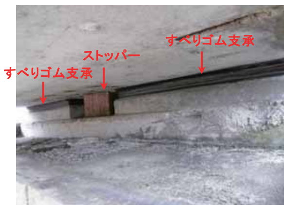
写真-4.1.9.6 橋脚上のすべりゴム支承及び鋼製ストッパー
