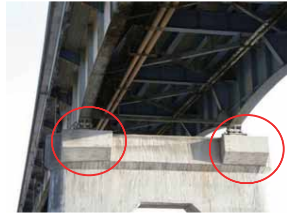
写真-4.2.11.2 縁端拡幅の状況
