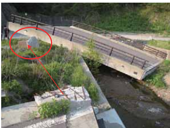
写真-4. 1. 18. 5 親柱の移動
