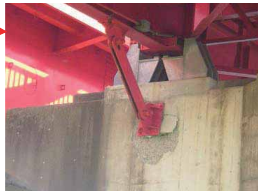
写真-4.5.1.10 P6 橋脚の落橋防止構造の損傷
