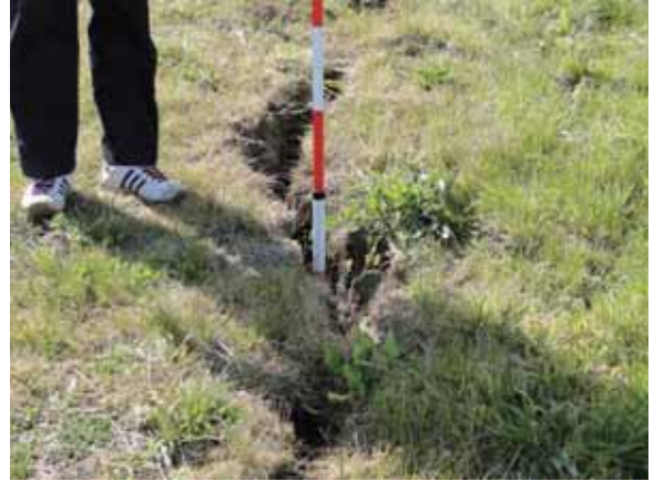
写真-4.4.7.12 P5 橋脚周辺の地面の割れ
