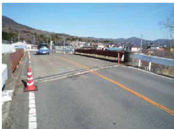
写真-4.4.16.1 筑波跨線橋
