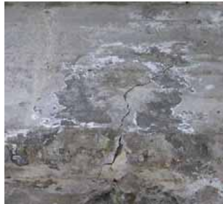
写真-4. 4. 14. 10 左岸側橋脚梁部のひび割れ
