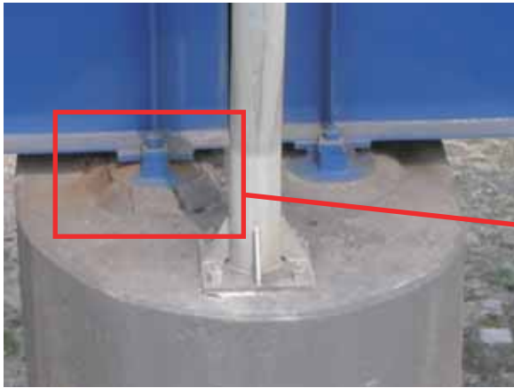
写真-4.4.13.14 左岸側より5脚目の 支承
