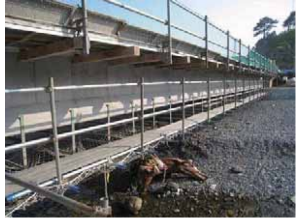
写真-4.1.17.8 新たに架設されている 上部構造の建設状況(側面)
