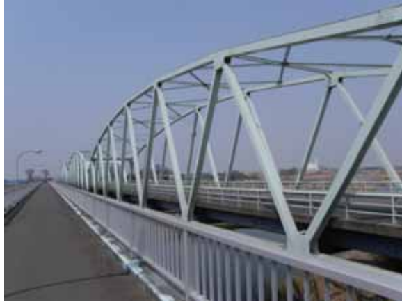
写真-4.4.13.1 栄橋(左岸側より)
