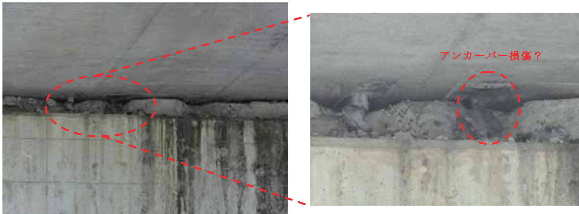
写真-4.3.14.11 A2 橋台部支承部の状況
