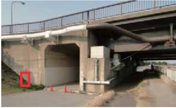
(a) A2 橋台全景(河口側より撮影)
