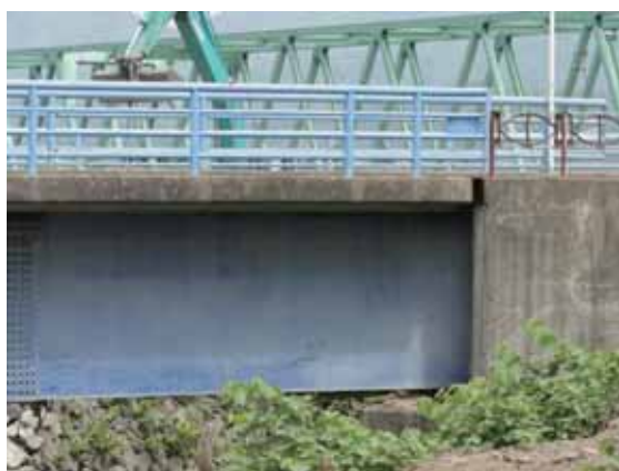
写真-4.2.5.5 右岸側橋台(上流側より)
