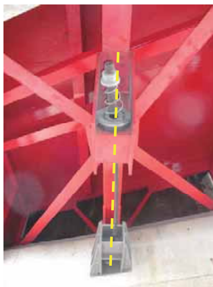
写真-4.2.16.12 橋台に取り付けられた落 橋防止ケーブルに生じた水平面内のたるみ
