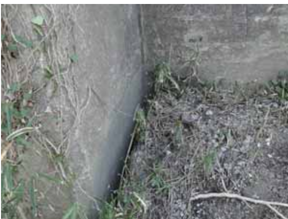
写真-4.4.5.26 A2 橋台側面の状況
