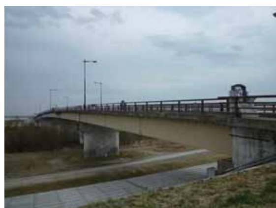
写真-4.2.13.1 木間塚大橋(右岸側より)
