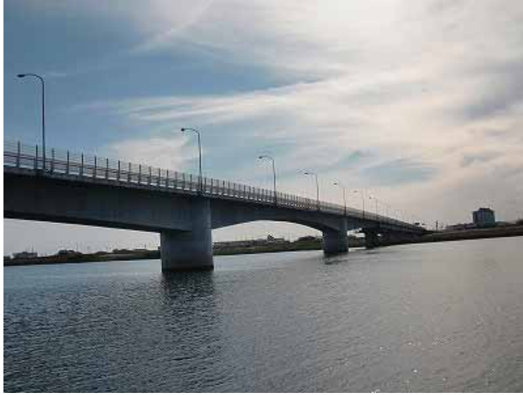
写真-4.2.14.1 関上大橋
