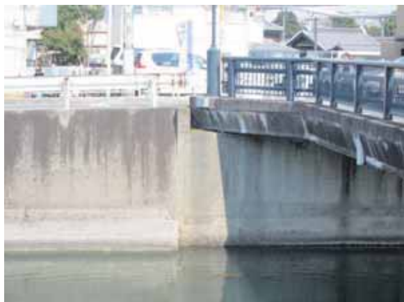
写真-4.5.10.2 橋梁取付護岸(左岸側) と橋台の取り付け部
