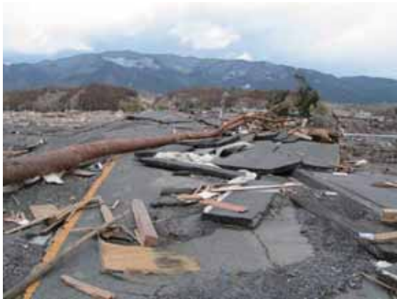
写真-4.1.3.2 堆積物と高欄の流出
