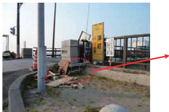
写真-4.4.32.5 橋台背面部の段差 (香取市側)
