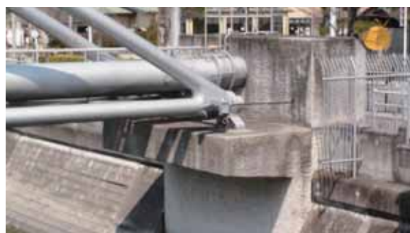
写真-4.5.8.10 左岸側橋台
