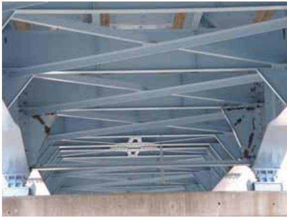
写真-4.4.5.18 P4 橋脚上の上部構造の 状況
