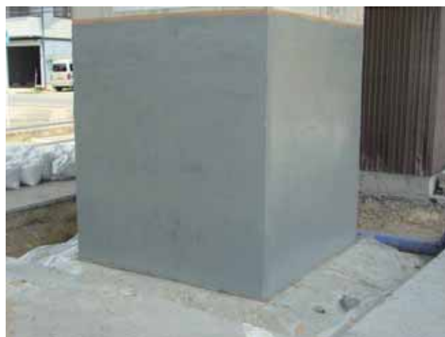
写真-4.2.19.12 P2橋脚の復旧状況(断面修復と炭素繊維シート巻立て) (資料提供:宮城県)
