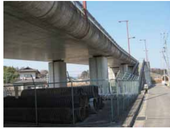
写真-4.3.8.3 東側取付部
