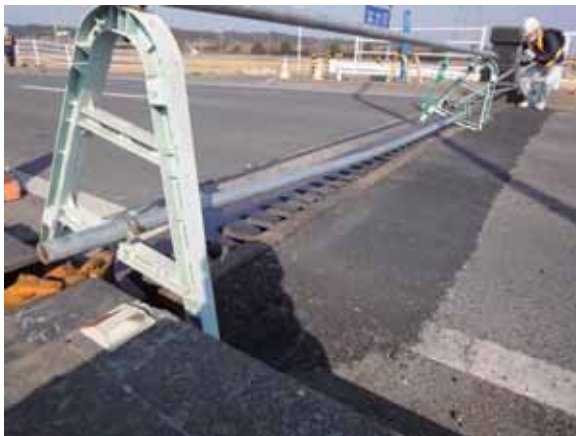
写真-4.4.7.16 A2 橋台上の伸縮装置の状況
