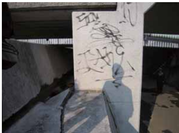
写真-4.5.3.3 護岸と橋台の間の状況
