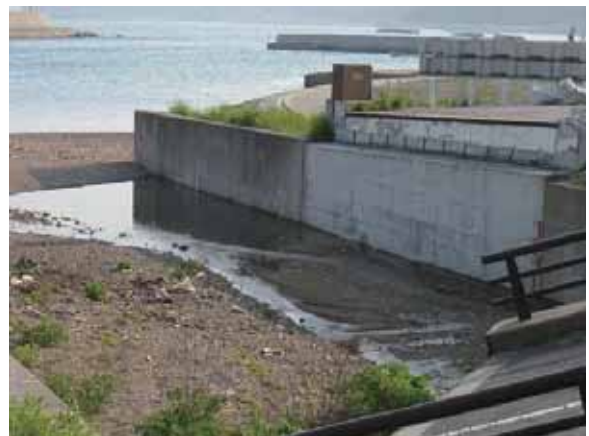
写真-4. 1. 18. 4 A2 橋台
