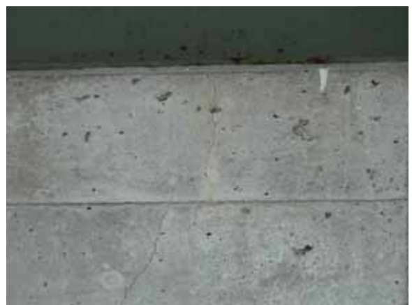
写真-4.4.7.14 P5 橋脚の横梁部中央の縦方向ひび割れ
