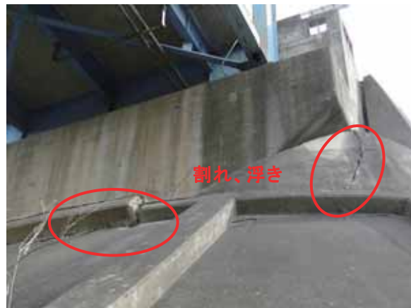
写真-4. 1. 16. 8 左岸橋台側面
