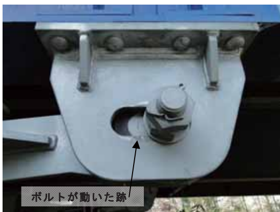
写真-4.4.9.7 落橋防止構造(右岸側橋台)
