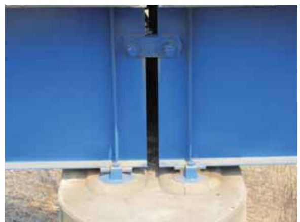
写真-4.4.13.13 左岸側より4脚目の支承
