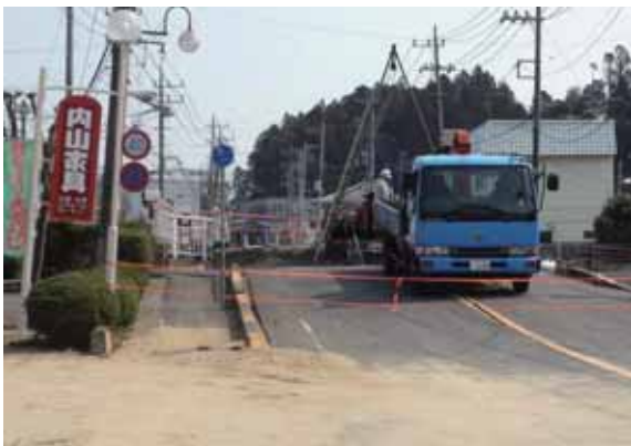
写真-4. 4. 23. 6 右岸側橋台周辺の状況
