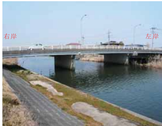
写真-4. 4. 20. 1 北浦橋(下流側より)
