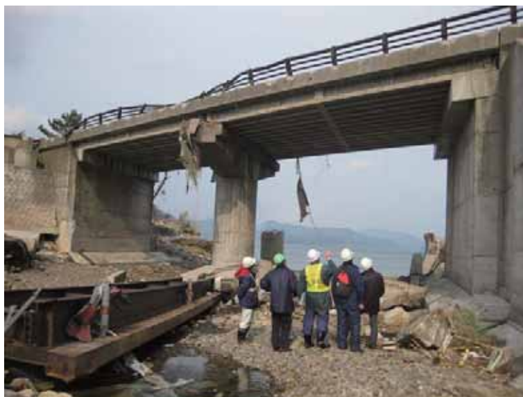
写真-1.1 調査状況
