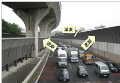
図-4.17 遮音壁による騒音の低減
