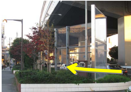
図-4.19 開口部の側方から伝搬する音
