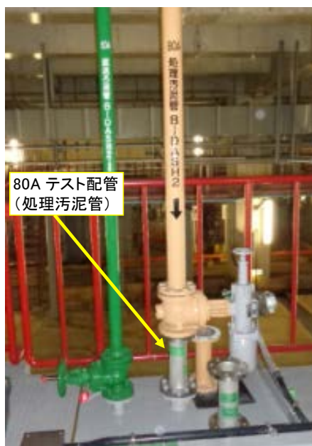
写真資 1-4 80A テスト配管設置状況
