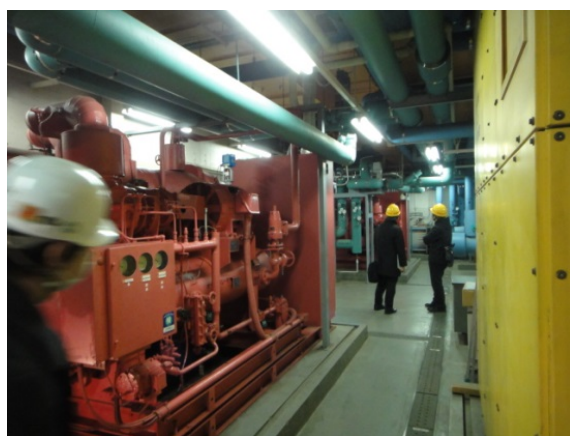
図4-3 機械室の調査（例）
