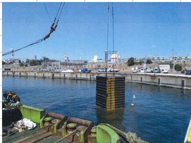
4/5撤去 コンテナ
