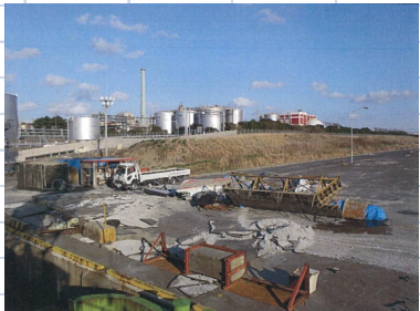
4/5撤去完了 陰悪物全景
