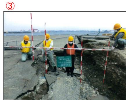
図-3.14.32(c) No.6 7号ふ頭地区先端護岸被災状況(図-3.14.31の③から撮影)
