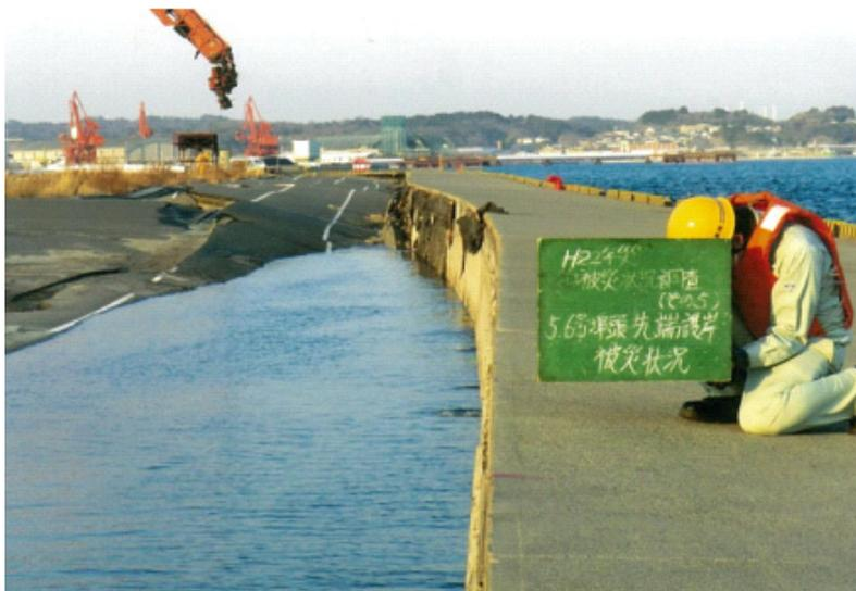
図-3.14.26(b) No.5 5・6号ふ頭地区先端護岸被災状況 (図-3.14.25 の②から撮影)
