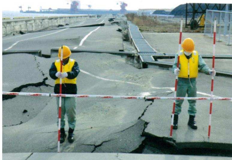
図-3.14.26(a) No.5 5・6号ふ頭地区先端護岸被災状況 (図-3.14.25の①から撮影)
