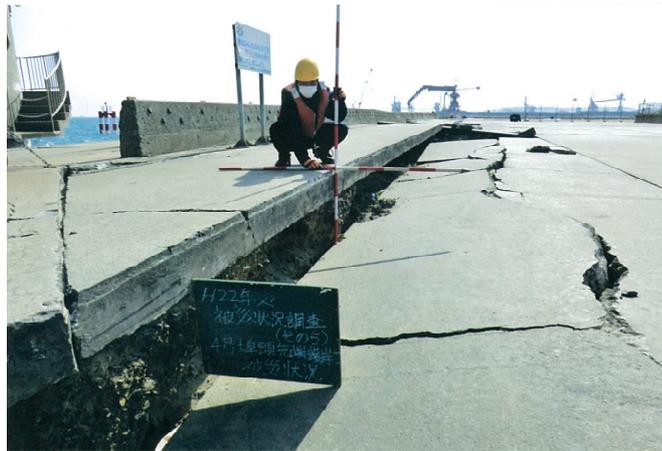
図-3.14.86(b) No.11 4号ふ頭地区\_先端護岸被災断面図 (-10m 岸壁側)
