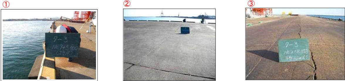
図-3.14.106 No.15 7号ふ頭地区-10m 岸壁沈下量、被災状況図
