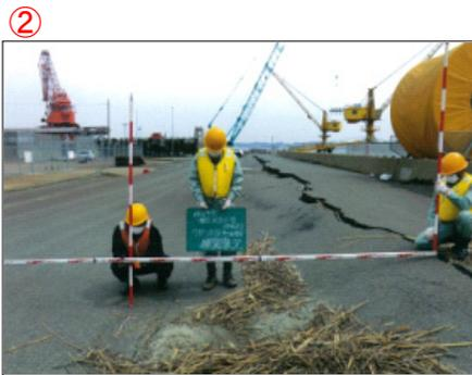
図-3.14.32(b) No.6 7号ふ頭地区先端護岸被災状況(図-3.14.31の②から撮影)
