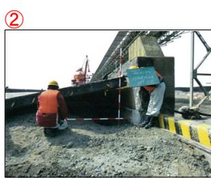
図-3.14.61(a) No.6 3号ふ頭地区\_-10m岸壁の沈下量, 被災状況図 (3-1, 3-2)
