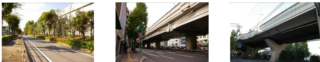
図 6 沿道住民の地先の遮音壁
