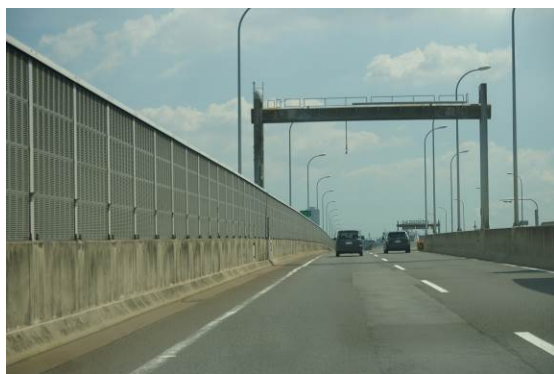
図 19 笠木等により遮音壁天端を 被覆修景した例
