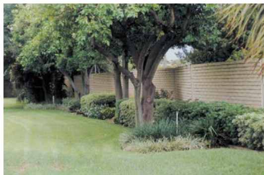
出典: KEEPING THE NOISE DOWN 2001 図 18 遮音壁背面にテクスチャー・パターンを 付与した例(アメリカ)
