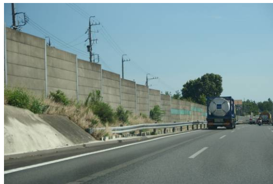
図 4 天端を直線化せずに段差をそのまま見せた例
