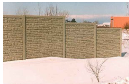
図 30 遮音壁端部を段差で擦り付けた例 (アメリカ)
