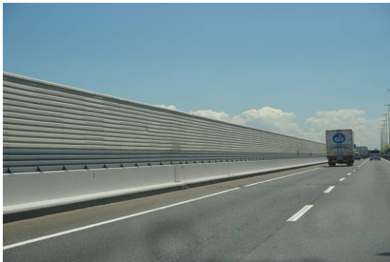
図 15 遮音壁をデザインの的に統一した例
