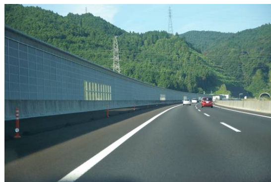
図 26 先端部を改良した例(吸音装置)
