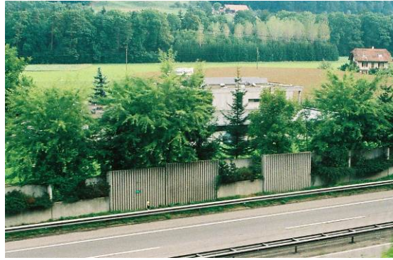
図 3 平面的な出入や凹凸がある遮音壁
