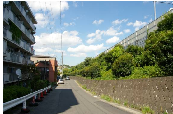
図 22 遮音壁背面に修景緑化を行った例
