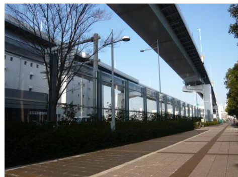
図 24 遮音壁に透光板を設置した例(2)
