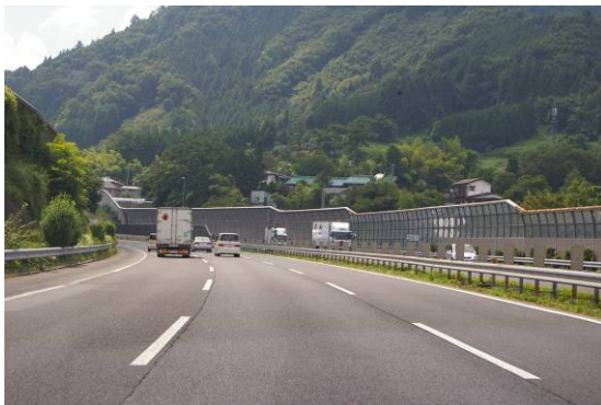
図 27 遮音壁の天端を滑らかにした例
