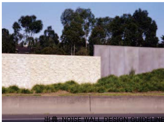
図 17 遮音壁の平面配置を工夫した例 (オーストラリア)
