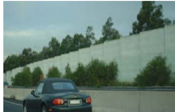
図 28 天端の段差とその間隔を等しくした例
