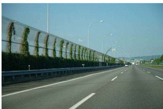
図 23 遮音壁に透光板を設置した例(1)
