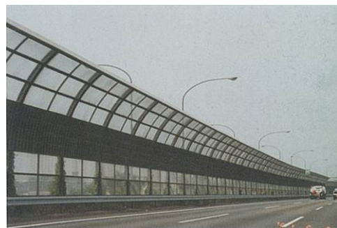
写真5.10.3 ドライバーの視点付近と上空に、透光板を用いて道路内・外部景観ともに圧迫感の少ない遮音壁。
