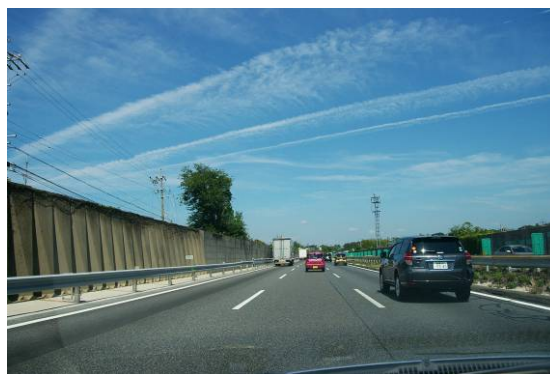
図 20 遮音壁前面にテクスチャー・パターンを 付与した例
