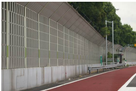
図 25 先端部を改良した例(分岐型)
