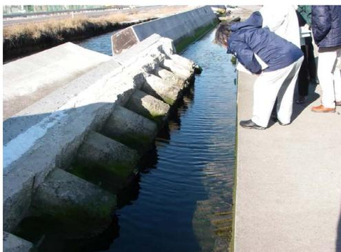
(1) 陸側に倒壊した堤体と地中に残留した止水矢板
