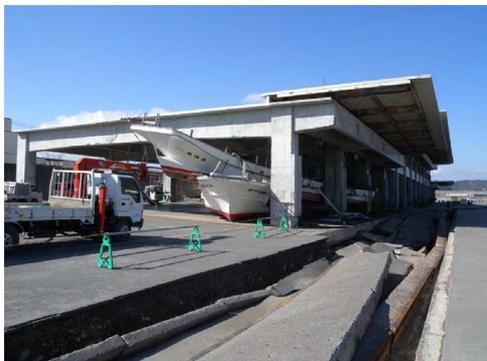
写真-3.3.5 エプロンの被害
