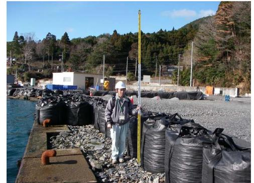
(2) 嵩上げされずに露出した一部の岸壁
