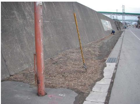
写真-3.3.2 胸壁陸側の小規模な洗掘跡 (地点2-b)
