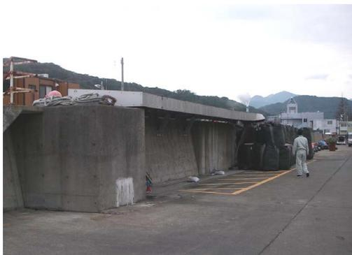
写真-3.4.3 応急措置として積み上げられた土嚢（奥側）と門扉の収納庫（手前）
