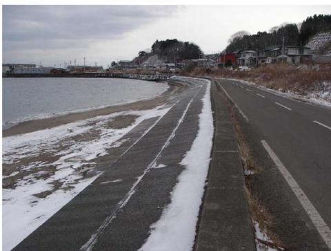
写真-3.2.6 被害のなかった階段式護岸（地点1-f）
