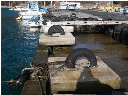
(2) 嵩上げされずに露出している一部の岸壁
