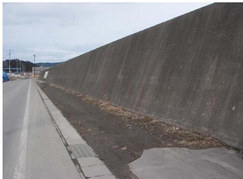
写真-3.3.6 胸壁陸側の小規模な洗掘跡（地点 2-e）
