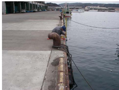
(1) 岸壁の天端高さの測定
