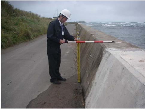
(4) 残留した護岸のパラペットの陸側形状の測定
