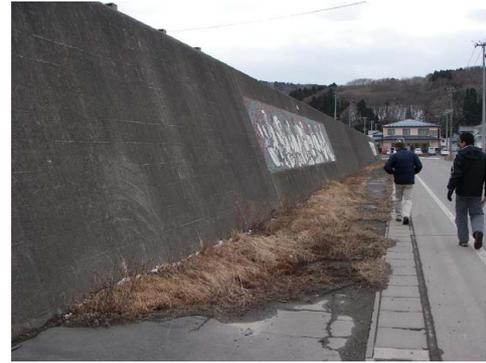
写真-3.3.3 胸壁陸側の小規模な洗掘跡 (地点2-c)
