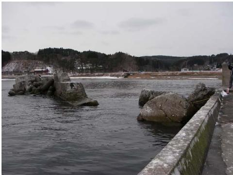
写真-3.2.4 被災した小規模な防波堤（地点1-d）
