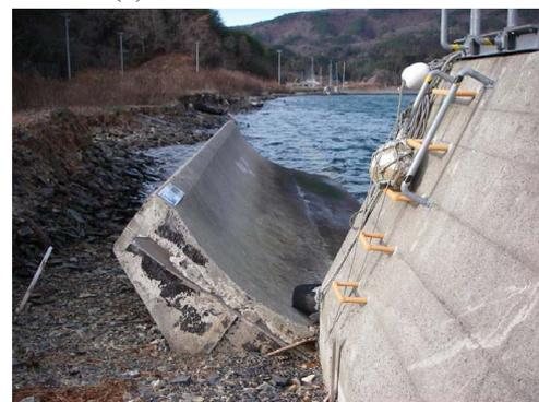
(2) 護岸に類似した構造の堤体が陸側に転倒した状況
