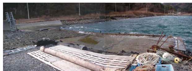
(3) 嵩上げされずに露出した岸壁 (測線 A-A')
