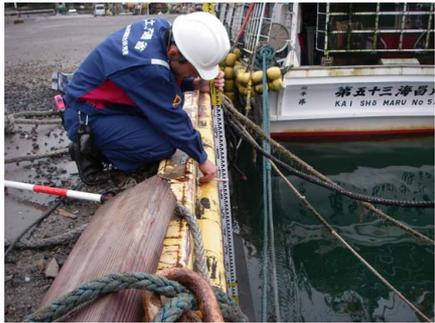
(2) 岸壁の天端高さの測定
