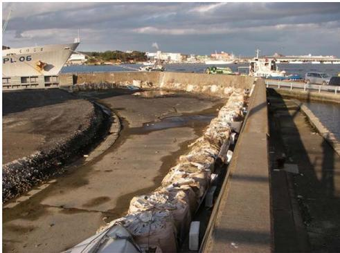
(1) 引波による胸壁堤体の海側への変位
