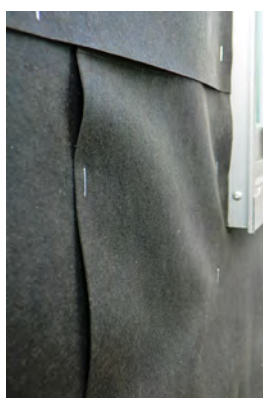
写真-4 雨により波打った防水紙
