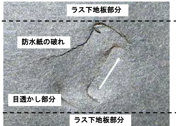
写真-2 ラス下地の目透かし部に打たれたハンマータッカーの痕
