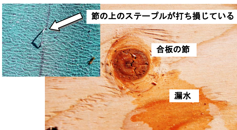
写真-4 合板の節にステープルを打ち損じ防水紙から漏水
