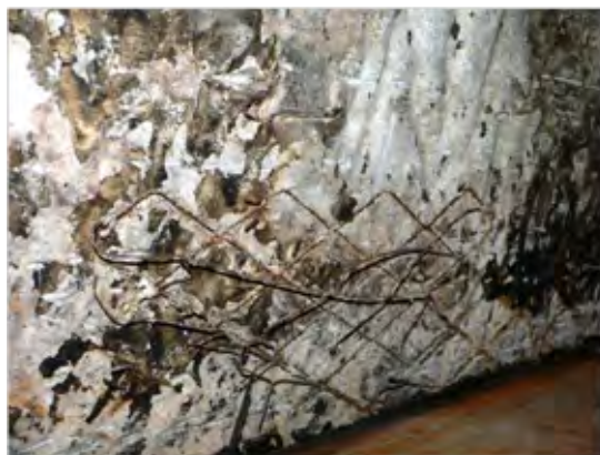
写真-7 モルタルに被覆されていない状態の平ラス
