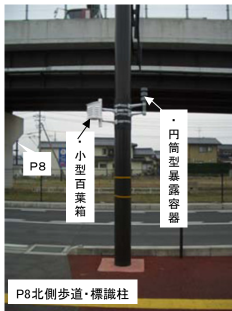
b) P8 橋脚北側標識柱の簡易化暴露架台
