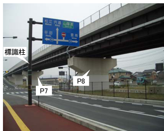
d) P8 橋脚北側の標識柱と東側 (P7 側) の状況
