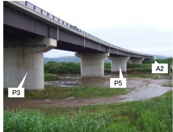
b) P3 橋脚～A2 橋台（左岸側）の状況
