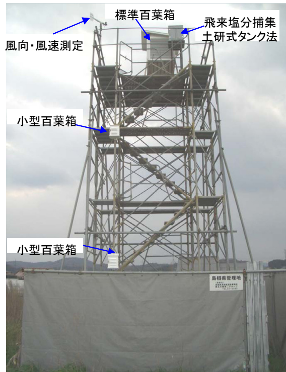
b) 仮設やぐら（大橋川右岸）からみた西側の状況 c) 仮設やぐらへの暴露架台の設置状況
