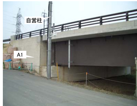
d) A1 橋台（右岸側）と自営柱の状況
