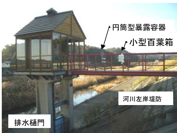
a) 排水樋門への簡易化暴露架台の設置状況
