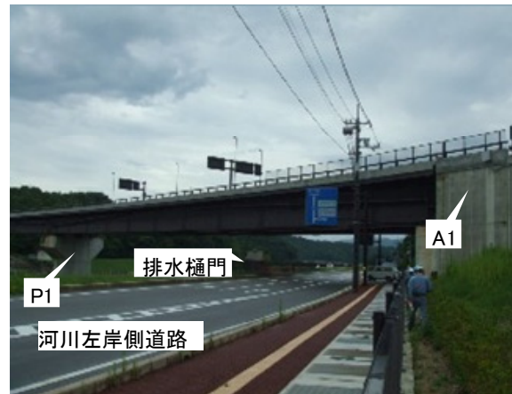
b) 左岸堤内・管理敷地側（北東）からみた状況
