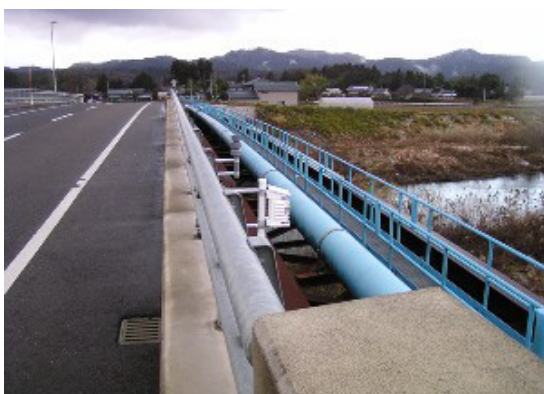
a) 高欄（北側）への暴露架台設置状況
