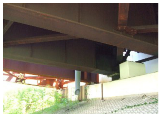
b) 右岸橋台側の試験片設置対象桁状況
