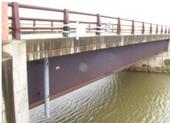
a) 北東側から見た高欄・暴露架台と桁の状況
