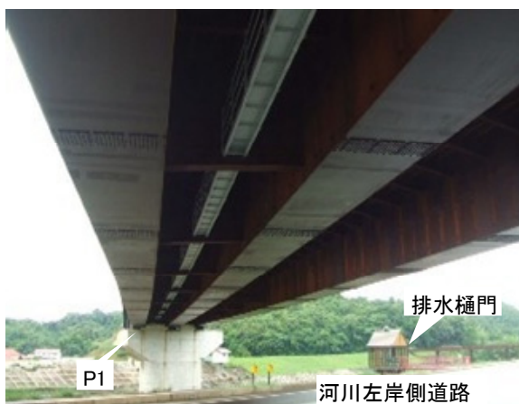
c) A1 橋台（北）から P1 橋脚（南）を見た状況
