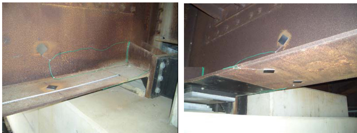
図 3.2.3 ワッペン試験片の既設橋の部材への設置状況の一例
