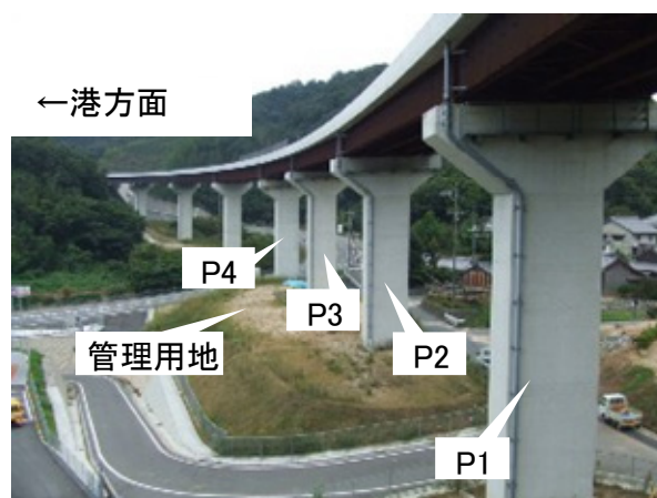
図 3.4.23 L 橋 A1 橋台（北側）から南側の遠景
