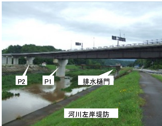
a) 左岸堤防・下流側（北東）から見た状況
