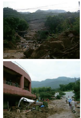
図Ⅱ②-2-4 土石流による被害状況
