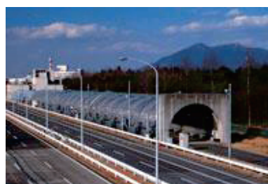
実大トンネル
