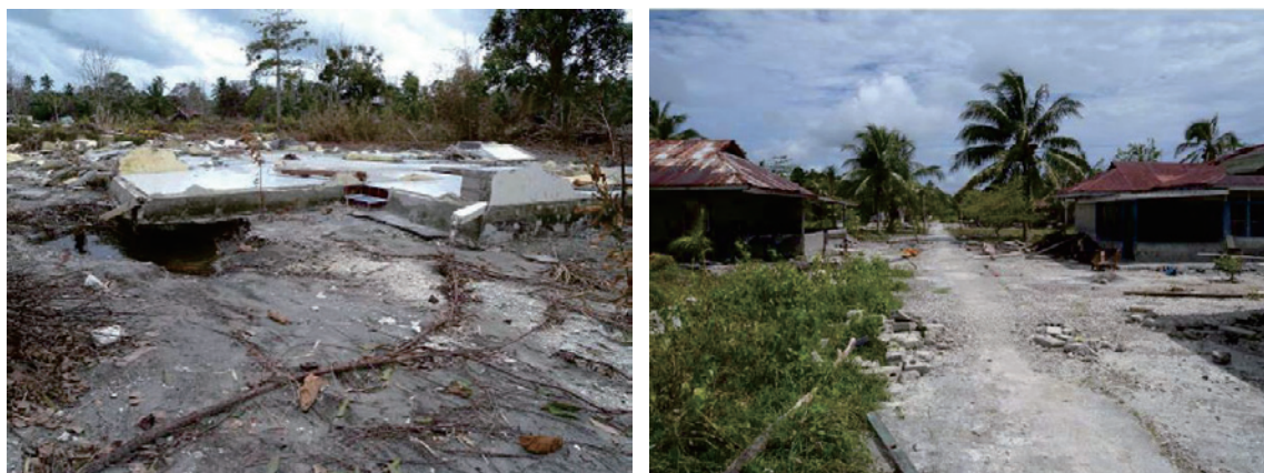
図Ⅱ②-2-5 津波による被害状況
