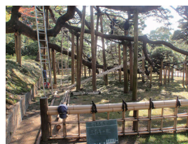
写真-7 剪定・枯れ枝除去状況 (都立浜離宮恩賜庭園提供)
