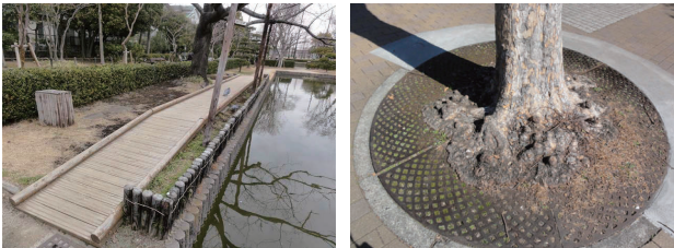
写真-14 踏圧防止板設置状況
