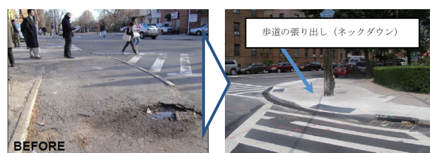
写真 2 横断距離の短縮 (上: 安全地帯の整備、下: 歩道の張り出し)
