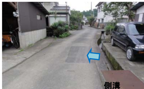
写真-3.1.13 側溝の上流側が溢れて住宅街浸水
