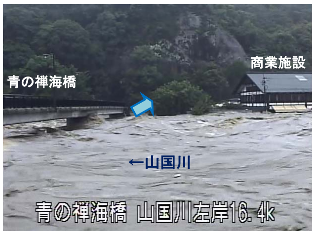
写真-3.2.5 下流側の堤防未整備区間における 7月3日洪水時の状況（CCTV映像）
