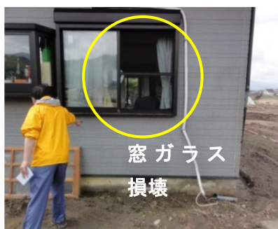
写真-3.1.20 家屋の窓ガラスの損壊
