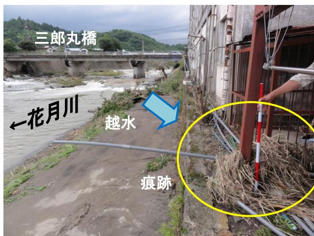
写真-3.1.1 左岸 0.4k 付近の漂流物
