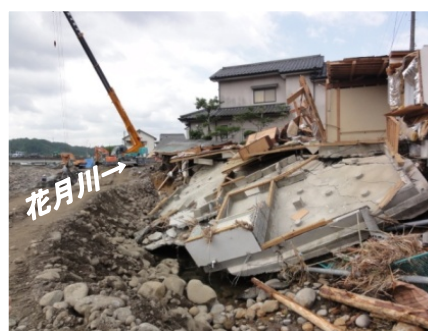
写真-3.1.15 決壊箇所付近の家屋倒壊
