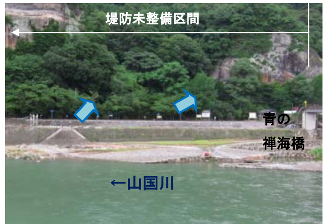
写真-3.2.6 下流側の堤防未整備区間における 平常時の状況
