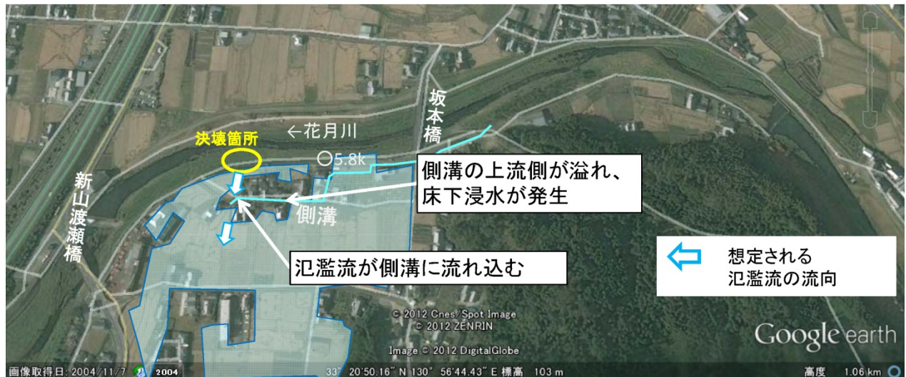
図-3.1.9 新山渡瀬橋上流～坂本橋（花月川左岸 5.6k～5.9k）における氾濫流の状況
