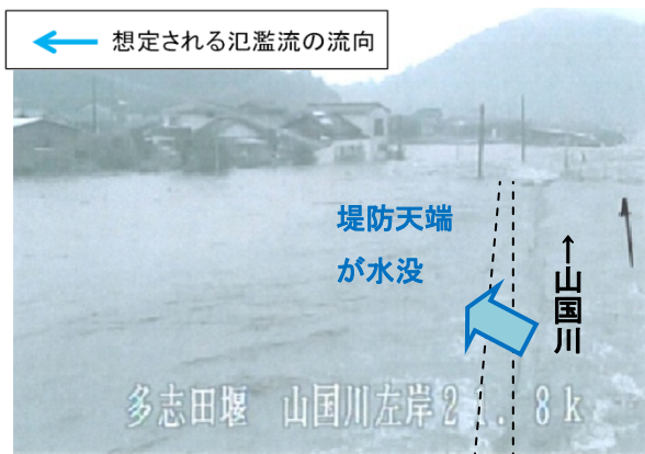
写真-3.2.10 左岸 21.8k の CCTV カメラ映像では、堤防天端が水没し堤内地一面が浸水
