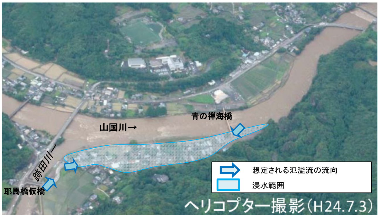
写真-3.2.4 下流側の堤防未整備区間における洪水時の状況※九州地方整備局より提供
