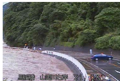
写真-6. 2. 2 7月3日山国川右岸 21.0k 付近の CCTV カメラ映像 (警察車両による通行止め)
