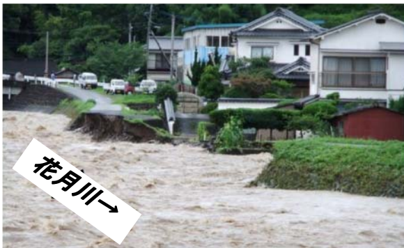
写真-3.1.11 左岸 5.7k 付近での堤防決壊時の状況 8)
