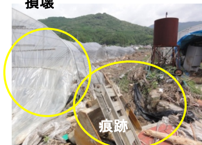
ビニールハウス 損壊
