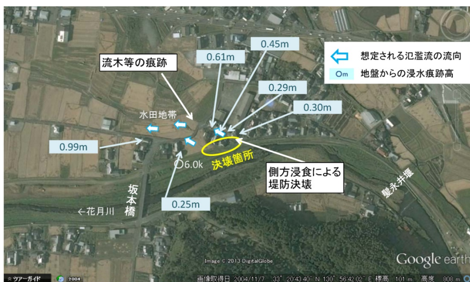
図-3.1.10 坂本橋～髪永井堰下流（花月川右岸 5.9k～6.1k）における氾濫流の状況
