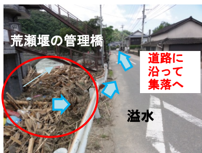
写真-3.2.1 荒瀬堰管理橋での流木等の堆積状況
