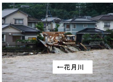
写真-3.1.14 右岸 6.1k 付近の堤防決壊状況 8)
