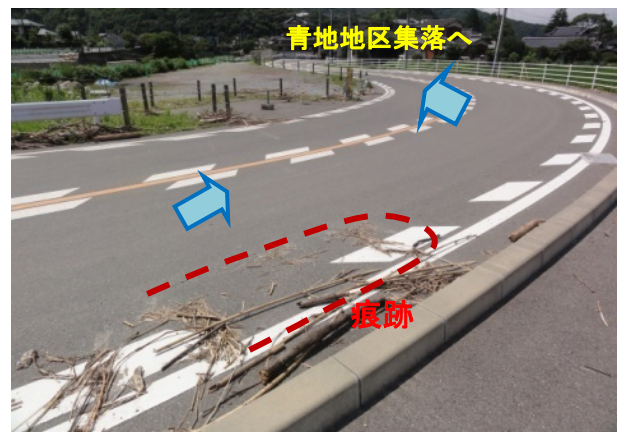
写真-3.2.8 耶馬橋仮橋の取付道路の痕跡状況
