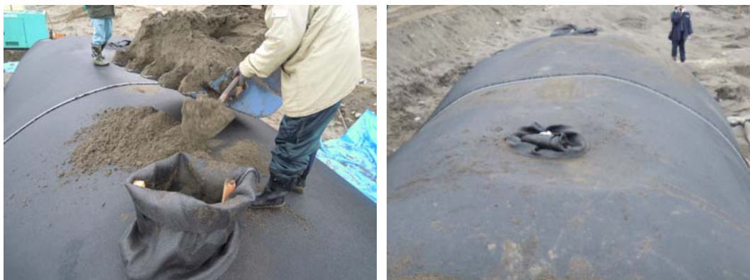
図Ⅱ-4.13.4.5 注入口の処理
