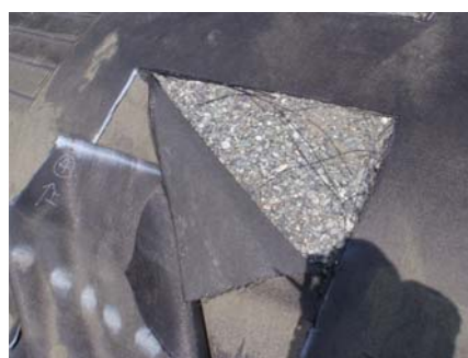
(b) 中詰材の充填状況
