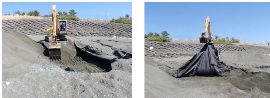
図Ⅱ-4.13.5.3 サンドバック解体撤去状況
