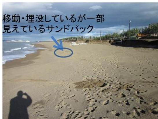
サンドバック移動・埋没しているが流失していない
