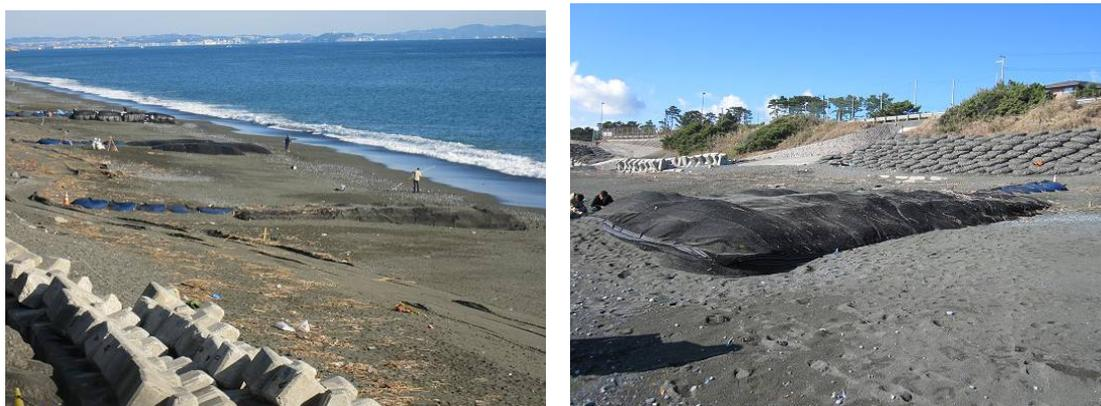
写真Ⅱ-3.18.1.1 サンドバック設置状況
