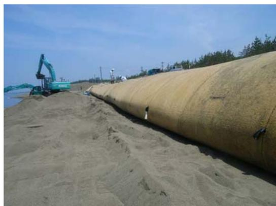
写真Ⅱ-3.2.1.8 浜崖後退抑止工の施工例
