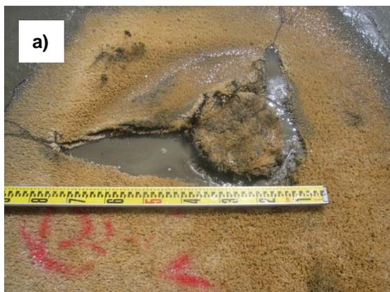
a) バケツ接触による損傷状況
