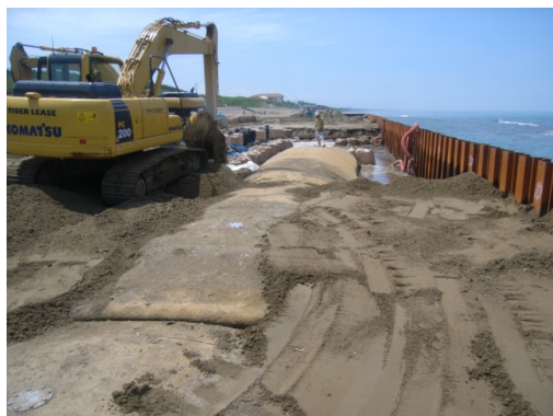
写真 I-4.4.5 監視員の配置
