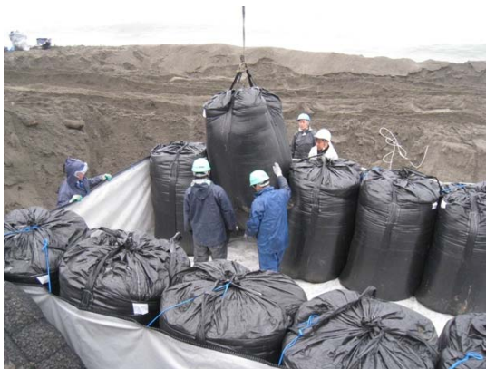
写真 I-4. 5. 25 中間部分の土嚢割り込み
