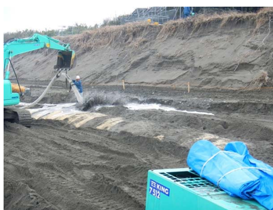
写真 I-4.5.16 埋め戻し部分の水締め
