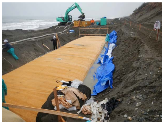
写真 I-4.5.8 法面保護シート敷設
