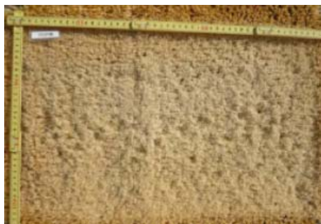
図 I-4.8.5 (3) 袋材の摩耗が進み強度低下が進んでいる状態 健全度B
