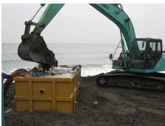
写真 I-4.5.9 中詰め材投入開始
