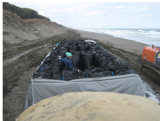
写真 I-4. 5. 26 外縁部の土嚢が設置された状態
