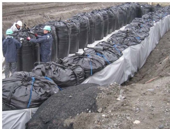
写真 I-4. 5. 24 外袋が結束ひもで立ち上がった状態
