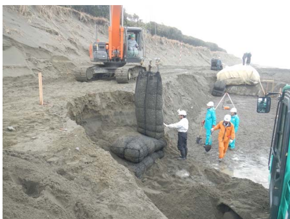
写真Ⅰ-4.5.2 小口処理設置
