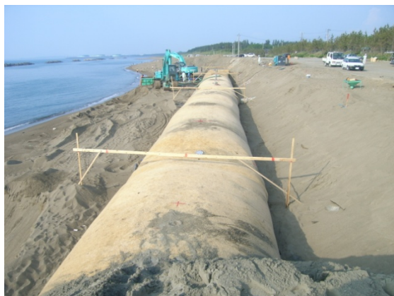
写真 I-4.5.17 丁張りによる高さ管理
