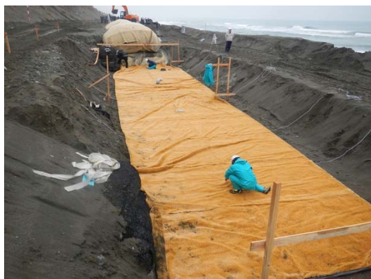
写真Ⅰ-4.5.3 袋材敷設
