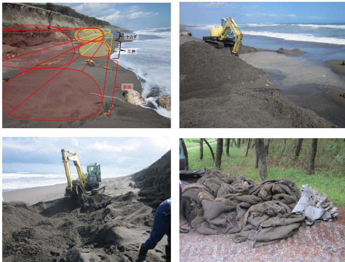
図 I-4.9.3 袋材取り残しの確認及び撤去状況（左上：設置位置復元、 右上：取り残しの確認、左下：取り残し袋材の回収、右下：回収された袋材）
