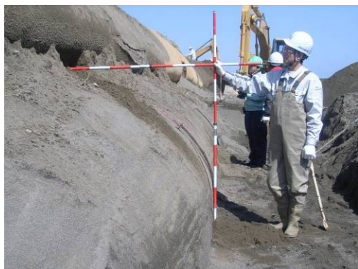
写真 I-4.9.7 撤去時の床掘り状況
