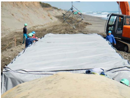
写真Ⅰ-4.5.27 土木用ファスナーによる外蓋の設置
