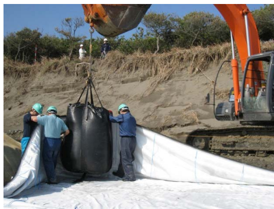
写真 I-4. 5. 22 角部土嚢設置
