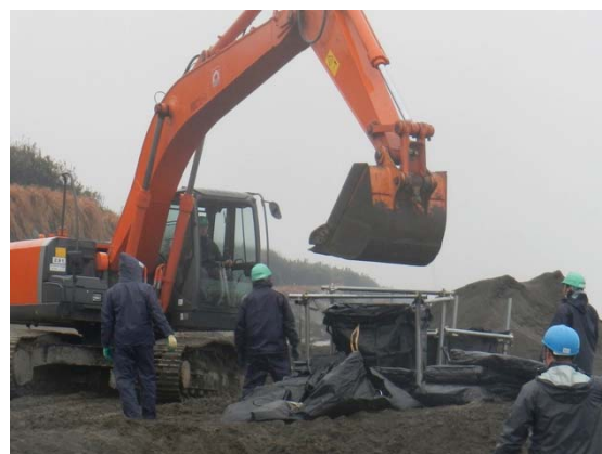
写真 I-4.5.20 大型土嚢製作
