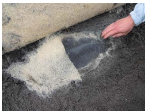
写真Ⅰ-4.4.7 カタピラ等旋回時の破損
