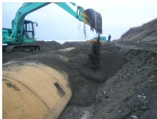
写真 I-4.4.4 埋戻し状況
