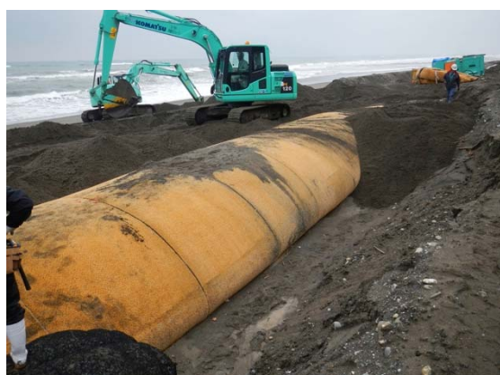
写真 I-4.5.15 背後埋め戻し
