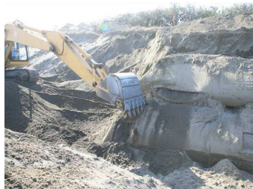
写真 I-4.9.8 の上段・下段の同時撤去状況
