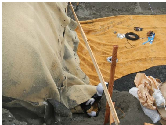
写真Ⅰ-4.5.4 突き合せ部準備
