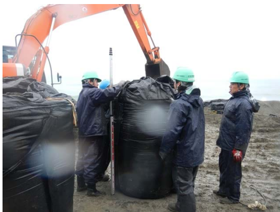
写真 I-4. 5. 21 土嚢個体高さ確認
