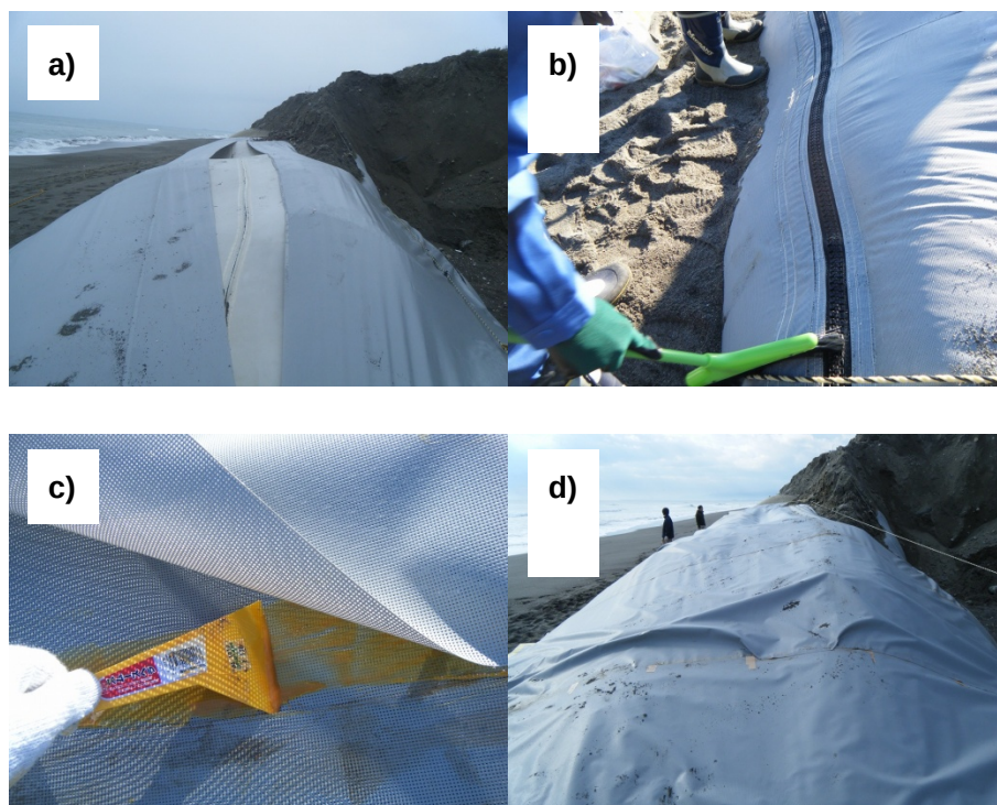
写真 I-4.9.1 基布のカバー工法（接着剤）による補修例
