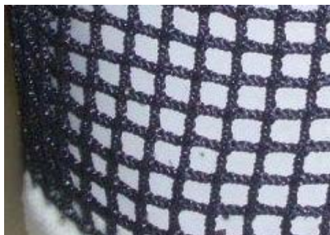
(b) 健全な状態
