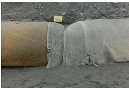
写真 I-2.10.1 筒へ差し込み接続する方法
