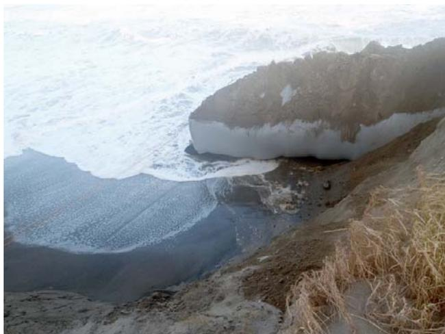
写真 I-2.2.2 施工端の侵食が進行し背面養浜盛土に及んだ様子
