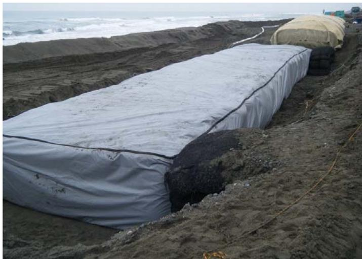
写真 I-2.10.7 網材ファルターによる端部処理
