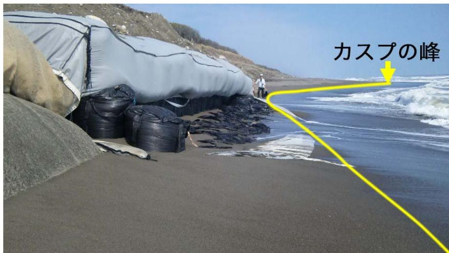
写真 I-2.7.1 カスプの巨大化による地盤低下で破損したサンドバック
