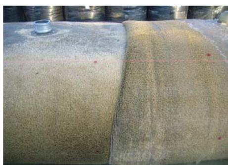
写真 I-2.10.2 凸凹で結合する方法
