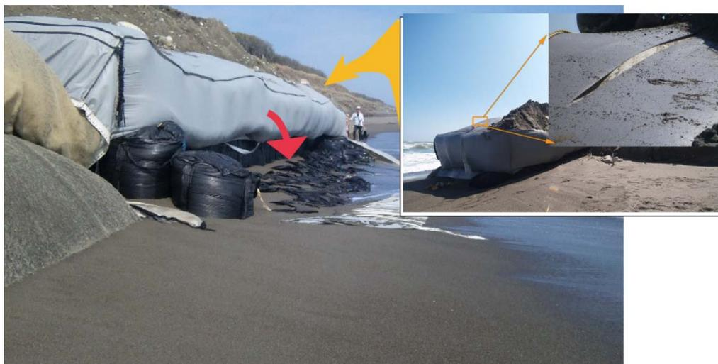
写真 I-2.2.1 海浜の短期的地形変化による地盤低下による下層の破損と上層の変形破損
