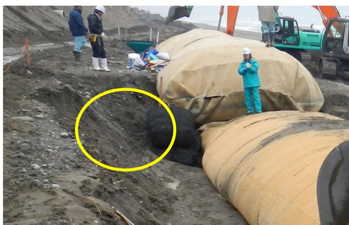
写真 I-2. 10. 4 突合せ部背後に設置したフィルタ材料
