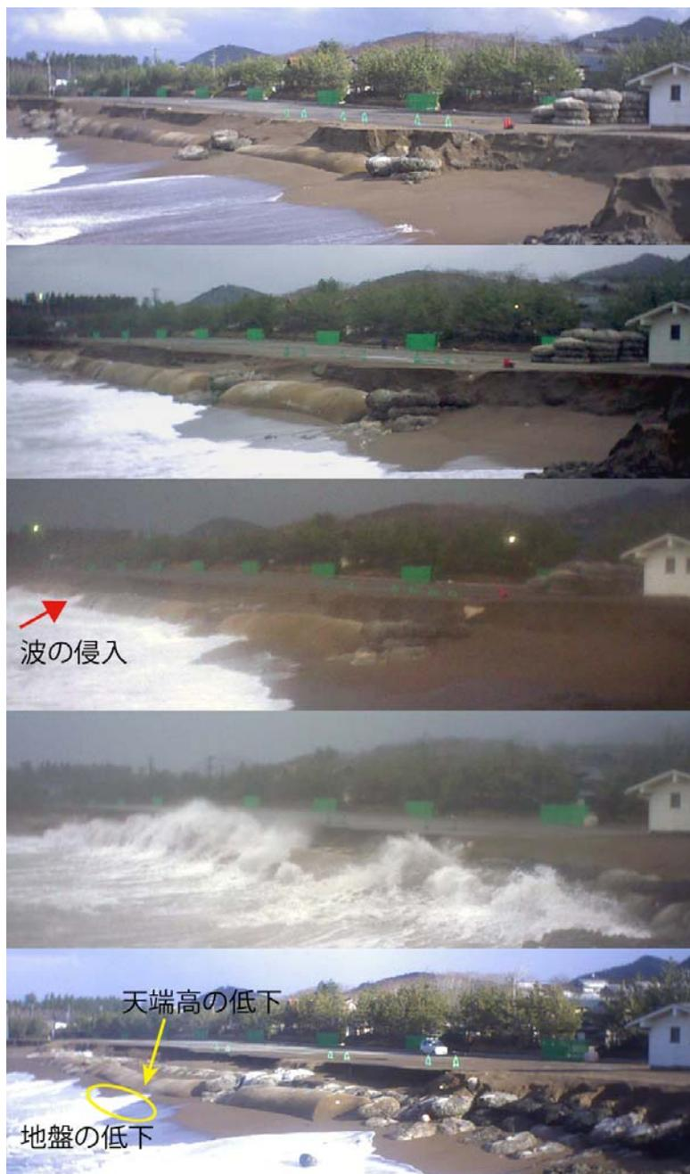
写真 I-2.2.4 サンドパック破損箇所からの波の侵入と背面養浜盛土の流失
