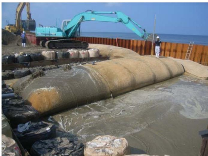
写真 I-2. 10. 5 L字型にサンドパックを設置した端部処理
