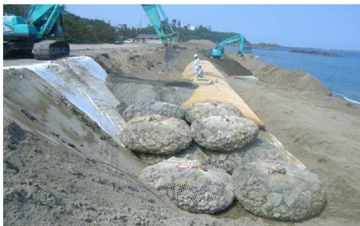
写真 I-2. 10. 6 袋詰め玉石と砕石による端部処理
