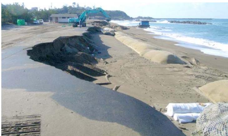
写真 I-2.2.3 サンドパック破損部が端部の効果となり背後盛り土が流出した例
