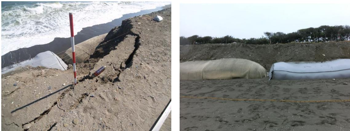
写真 I-2.2.5 突合せが悪い場合に生じる局所的な侵食（左；盛土上から、右；正面から）
