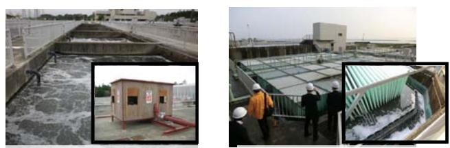
図-10 段階的応急復旧事例
