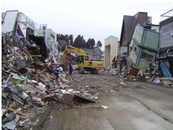
写真3 岩手県山田町国道45号 (平成23年3月15日)
