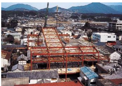
図 3-34 平成の大修理の様子
