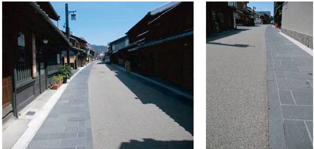
図 3-88 舗装方法の違いにより車道と歩行空間を明示した例（岐阜県川原町） （中央部：脱色アスファルト自然舗装、両端部：御影石の石張舗装）
