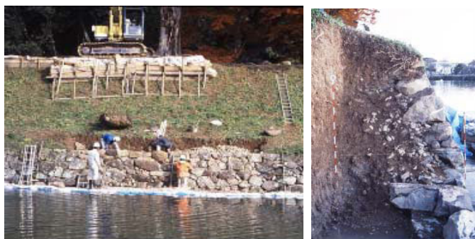
図 3-24 石垣の修復の様子
