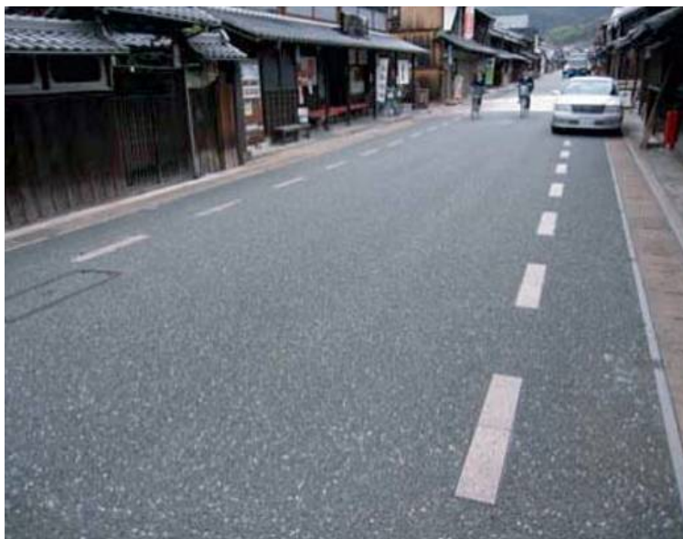
図 3-89 御影石を等間隔に配置し車歩道区分を示した事例（岐阜県美濃市）
