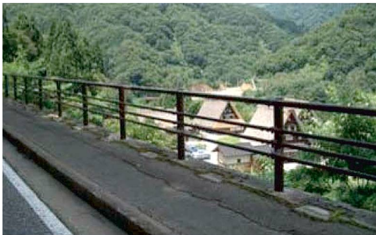
図 3-92 色彩をダークブラウン、構造を横桟式とした転落防止柵（富山県南砺市菅沼集落）
