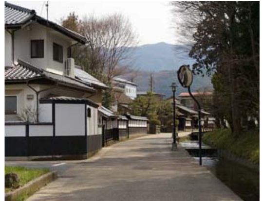
図 3-83 脱色アスファルト自然色舗装の例 (長野県長野市松代地区)
