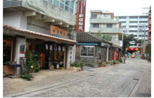
図 3-80 本島南部で採石される琉球石灰岩の舗装事例（沖縄県那覇市壺屋やちむん通り）
