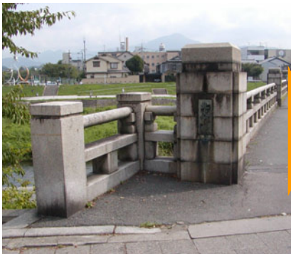
図 3-71 整備前の北大路橋
