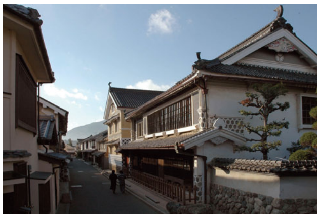
図 3-11 内子町八日市・護国地区のまちなみ 手前は製蠟業で栄えた豪商「本芳我家住宅」
