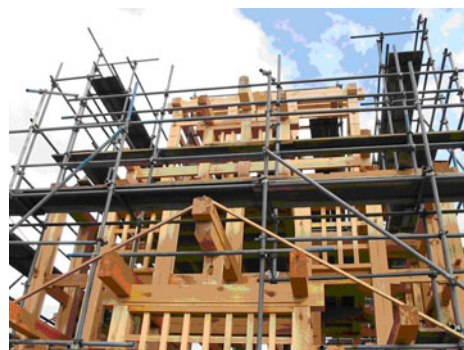
図 3-22 当時の工法を駆使した木造建築(飯田丸五階櫓)の復元の様子
