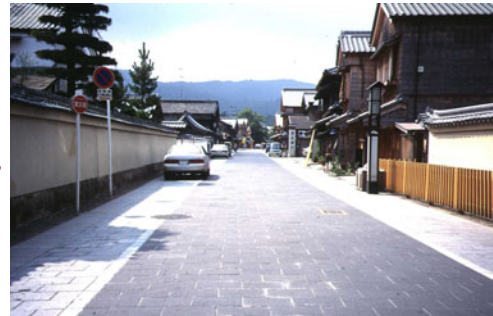
図 3-53 無電柱化 整備後(平成4年頃)
