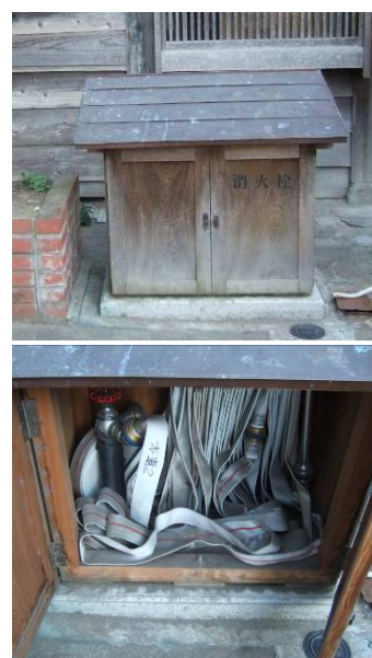
図 3-19 景観に配慮した街かど消火栓の外観と内部
