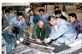
図 3-76 瓦科(本瓦葺の作業)
