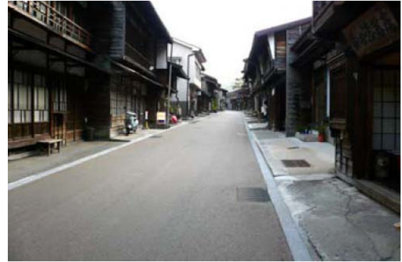
図3-94 管渠型側溝の整備事例（長野県塩尻市奈良井宿）
