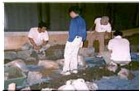
図 3-77 石工科(間知積の石割作業)
