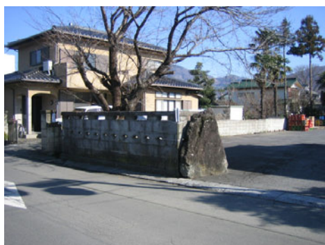
図 3-62 修景前のブロック塀の状況
