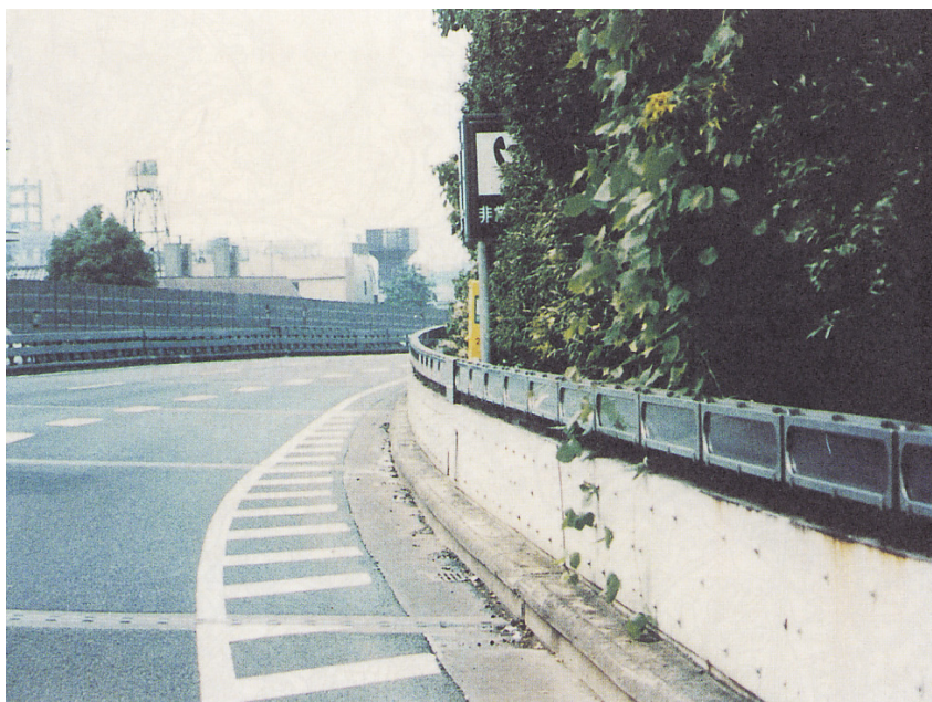
高欄照明の設置事例(事例 No. 1)
