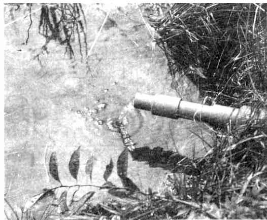
口径で水量を調節する給水パイプ
