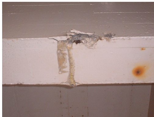
横桁下端に、錆汁、コンクリート剥離・鉄筋露出が発生 （外面被覆塗装箇所）
