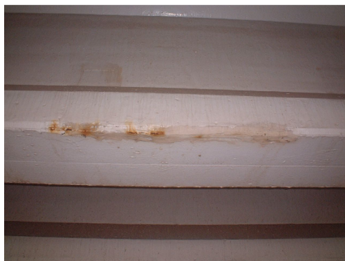
主桁下端に、錆汁、コンクリートのうきが発生 （外面被覆塗装箇所）
