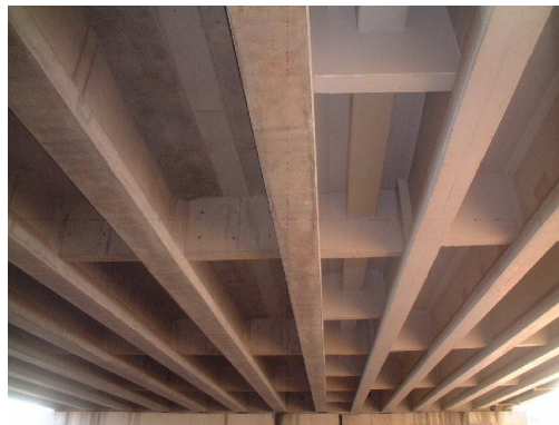
桁下状況（写真右側は、桁下を外面被覆塗装済み）
