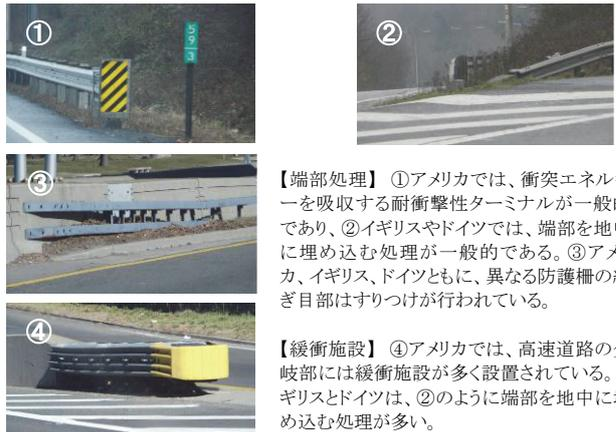
【端部処理】 ①アメリカでは、衝突エネルギーを吸収する耐衝撃性ターミナルが一般的であり、②イギリスやドイツでは、端部を地中に埋め込む処理が一般的である。③アメリカ、イギリス、ドイツともに、異なる防護柵の継ぎ目部はすりつけが行われている。
