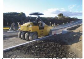
タイヤローラの締固め状況
