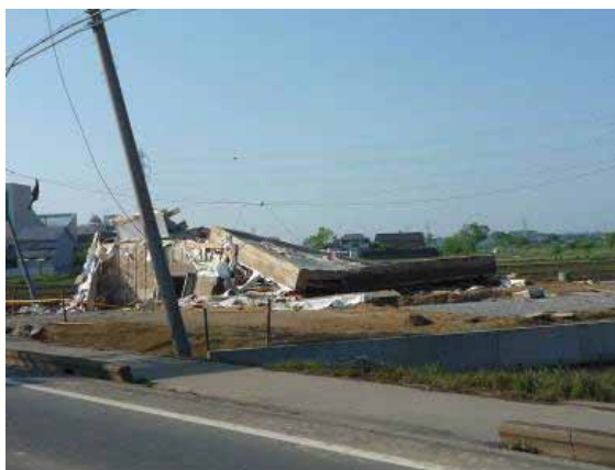
写真 4.2-1 上部構造の転倒
