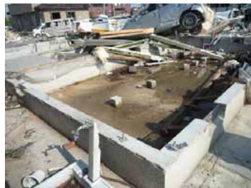
写真 4.2-4 上部構造の飛散
