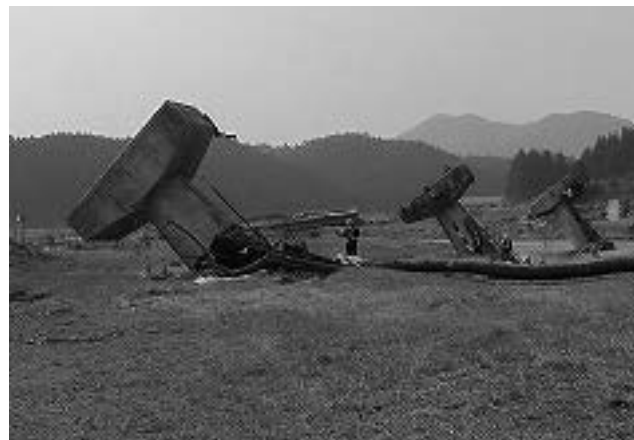
(b) 橋脚に致命的な損傷が生じた例
