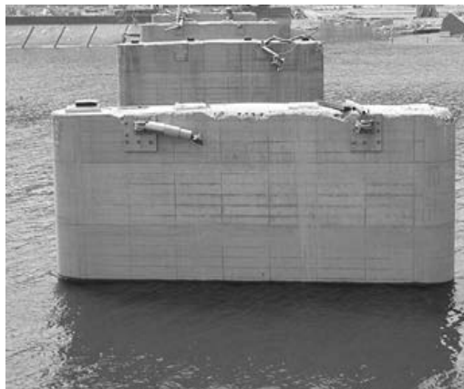
(a) 橋脚は比較的健全な例
