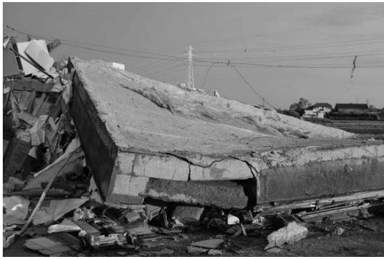
写真 2 転倒した木造住宅の基礎底面
