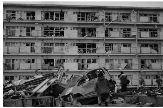
写真 3 開口部等が損壊した集合住宅
